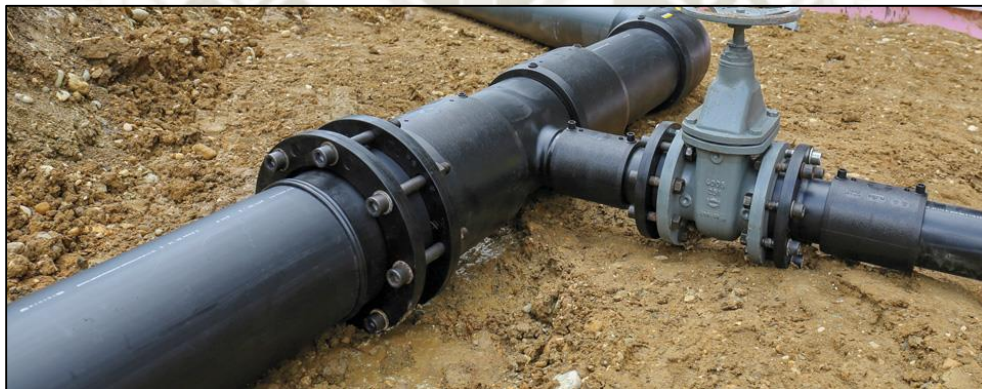
Figura 49: Instalación de accesorios de HDPE [20].
