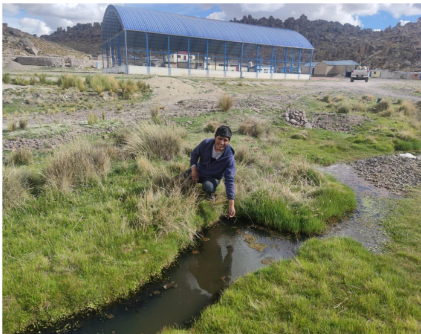
Presencia de agua estancada
