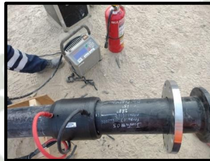
Figura 14 – Unión de tuberías de 8" de diámetros con una máquina de electrofusión. Fuente: Registro fotográfico personal.
