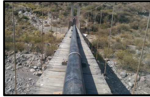
Figura 2 – Instalación de tubería de 16” de diámetro SDR 41 finalizada.
