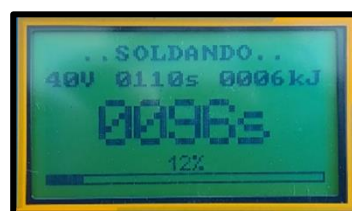
Figura 112 – Porcentaje de ejecución de la electrofusión del tapping tee. Fuente: Registro fotográfico personal.
