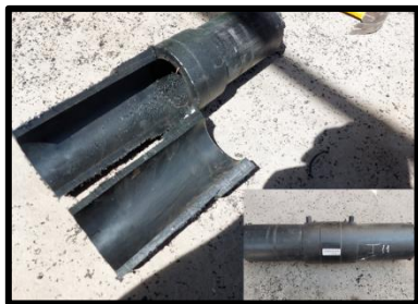
Figura 156 – Corte longitudinal de la copla. Fuente: Registro fotográfico personal.
