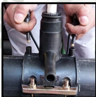
Figura 109 – Conexión de los empalmes de la máquina de electrofusión a los bornes del tapping tee. Fuente: Registro fotográfico personal.
