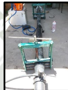
Figura 117 – Tuberías y copla alineadas entre sí. Fuente: Registro fotográfico personal.
