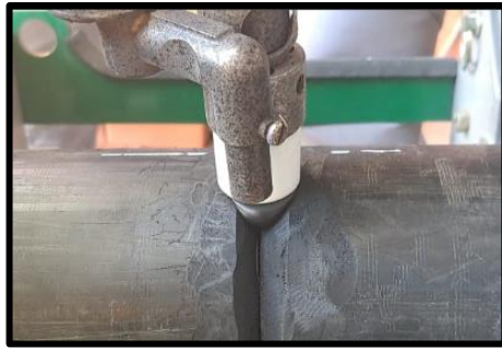
Figura 124 – Unión por extrusión de las tuberías de 110 mm SDR 11.
