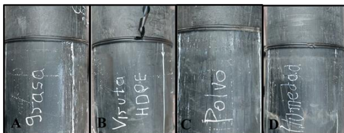
Figura 166 – Tubería de 200 mm SDR 17 contaminadas con: (A)grasa, (B) viruta de HDPE, (C) polvo, (D) humedad.
