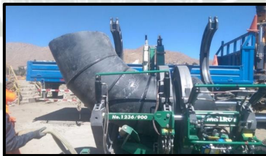
Figura 10 – Fabricación de un codo de Polietileno de Alta Densidad con una máquina de termofusión. Fuente: Registro fotográfico personal
