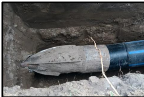
Figura 22 – Cabezal tipo bala para la explosión de tubería antigua. Fuente: Lavel Ingeniería Limitada, 2020
