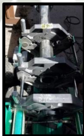
Figura 93 – Unión por termofusión de flange adapter y tubería. Fuente: Registro fotográfico personal.
