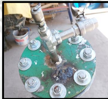
Figura 62 – Brida ciega conectada a tee para instalar bomba y Data Logger6. Fuente: Registro fotográfico personal.
