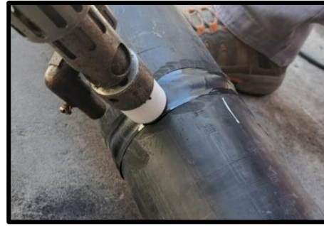
Figura 125 – Extrusión completada alrededor de la tubería de 110 mm SDR 11.
