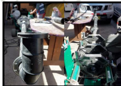
Figura 95 – Línea de prueba del sistema de agua potable finalizada. Fuente: Registro fotográfico personal.
