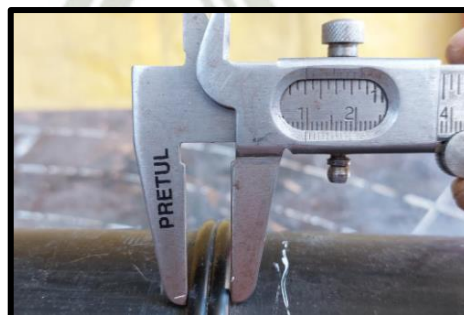
Figura 140 – Labio formado de 4.5 mm luego de aplicar la presión de fusión de las superficies transversales de las tuberías.
