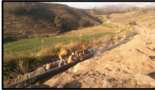
Figura 3 – Termofusión de tubería de 16" de diámetro SDR 41 en zanja. Fuente: Registro fotográfico personal.
