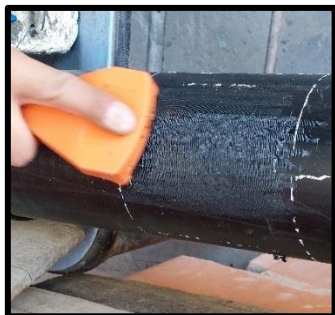
Figura 107 – Raspado de la área seleccionada y marcada. Registro fotográfico personal.
