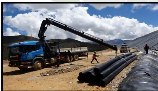
Figura 35 – Almacenamiento de tubería de Polietileno de Alta Densidad (HDPE). Fuente: SGE, 2022.
