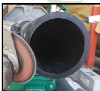
Figura 122 – Biselado de los bordes del área transversal de la tubería de 110 mm. Fuente: Registro fotográfico personal.
