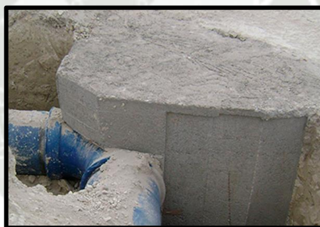
Figura 42 – Bloque de anclaje para la unión de accesorios y tuberías de Policloruro de Vinilo (PVC) y hormigón.
