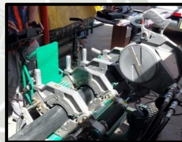
Figura 94 – Unión por termofusión de un tubo con el codo de 90° con su flange adapter al extremo. Fuente: Registro fotográfico personal.
