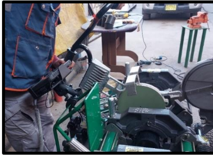
Figura 76 – Inserción del plato calefactor entre las áreas transversales para su calentamiento. Fuente: Registro fotográfico personal.
