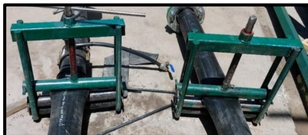
Figura 115 – Estrangulamiento de la tubería de 110 mm de diámetro con prensa. Fuente: Registro fotográfico personal.
