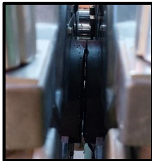
Figura 72 – Alineación de los segmentos de la tubería de 110 mm.
