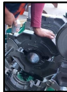
Figura 71 – Sujeción de segmentos con las mordazas para tubería de 110 mm. Fuente: Registro fotográfico personal.
