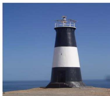
Faro de la Planchada Fuente: Google imágenes 2013.
