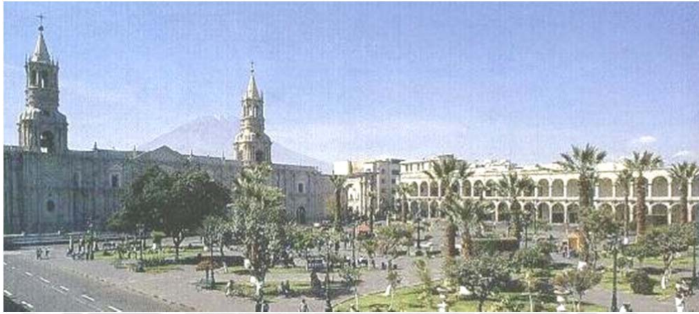
Foto N° 34: Fotografía de la Plaza de Armas de Arequipa. Fuente: http://es.wikipedia.org/wiki/Arequipa
