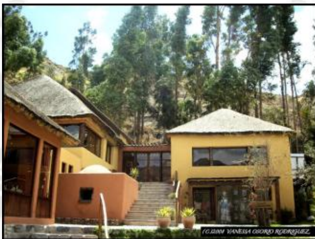
Foto N° 14: Fotografía vista frontal de la recepción y tienda de souvenirs del “Hotel Colca Lodge”. Fuente: http://www.colca-lodge.com
