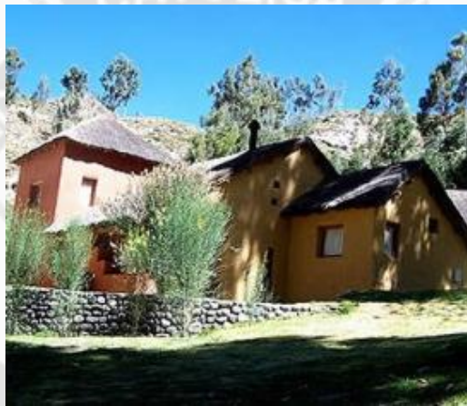
Foto N° 20: Fotografía del exterior de la zona de servicio del Hotel Colca Lodge.
