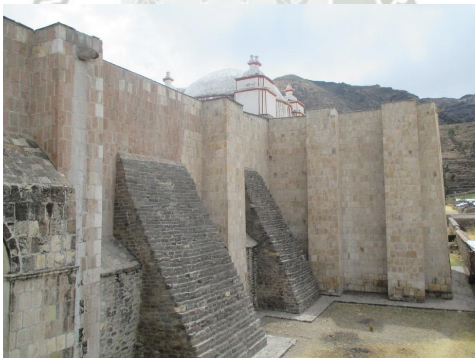
Imagen 8: Contrafuertes de la estructura del templo.
