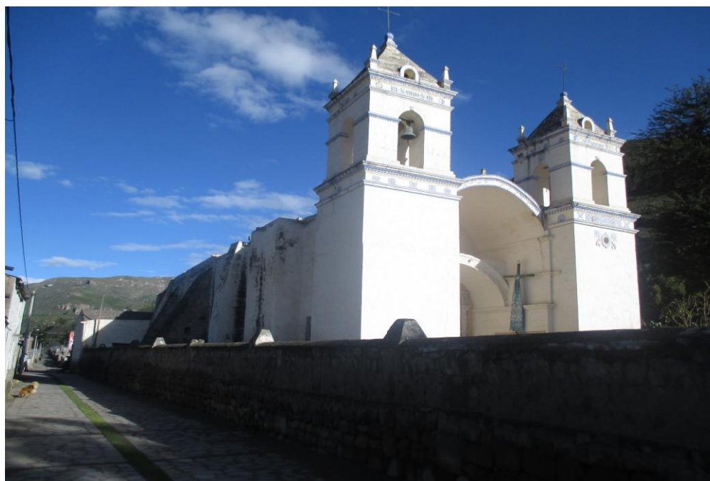
Imagen 2: Fachada y pared lateral derecha del templo.
