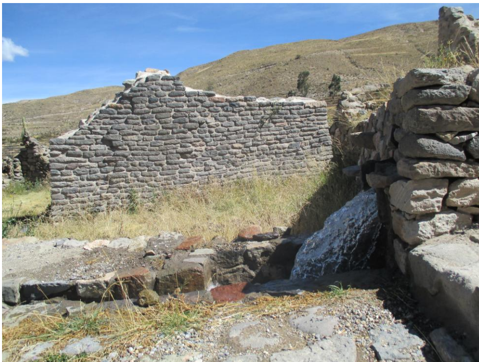
Imagen 8: Acueductos y sistema de riego.
