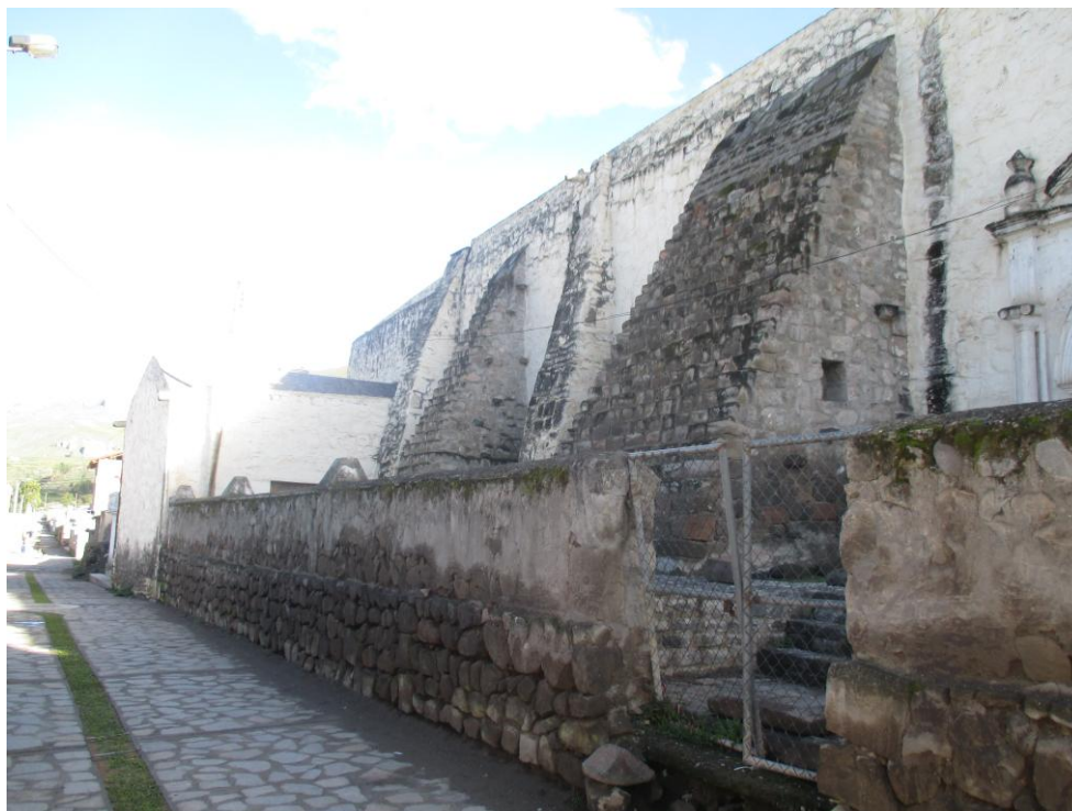
Imagen 3: Pared lateral derecha, contrafuertes e ingreso a capilla
