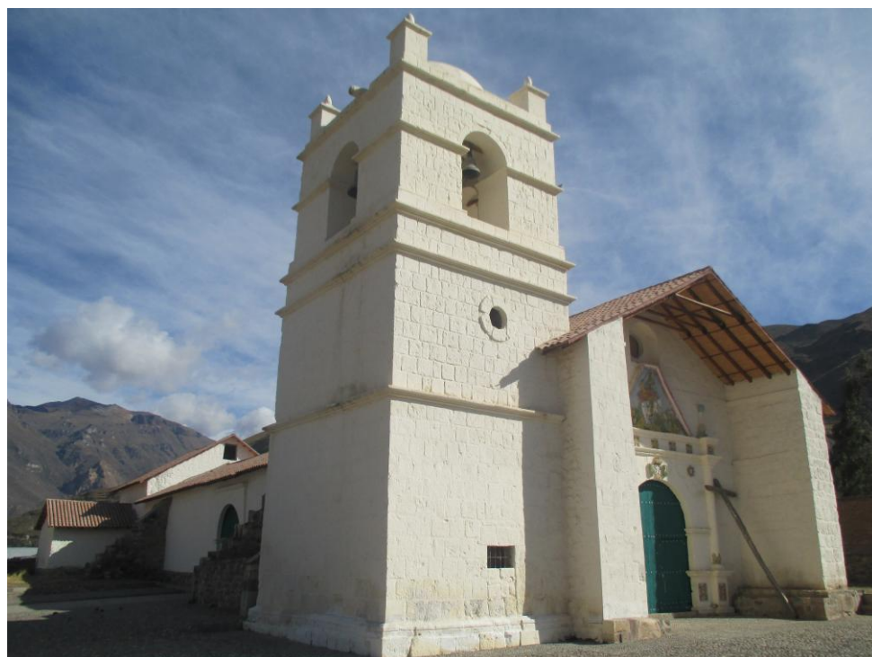
Imagen 2: Fachada y pared lateral derecha del templo.
