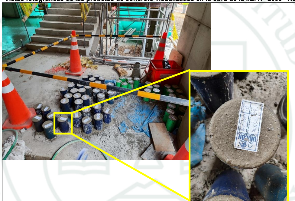
Fotografía N° 5: Vista de probetas de concreto vaciadas el día anterior a la visita de inspección (es decir, el 8 de febrero de 2024), almacenadas al costado de la escalera del primer nivel al interior del Activo 418.
