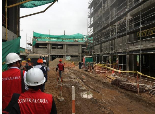
Fotografía N° 1: El ingreso provisional a la obra se realiza por la Av. Alcázar.
