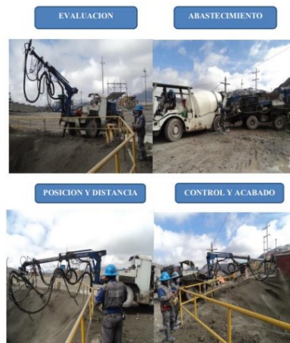
Figura 3. Técnicas para la proyección de shotcrete vía húmeda
