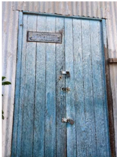
Figura 21 Condiciones de almacenamiento de materiales en almacén 2
