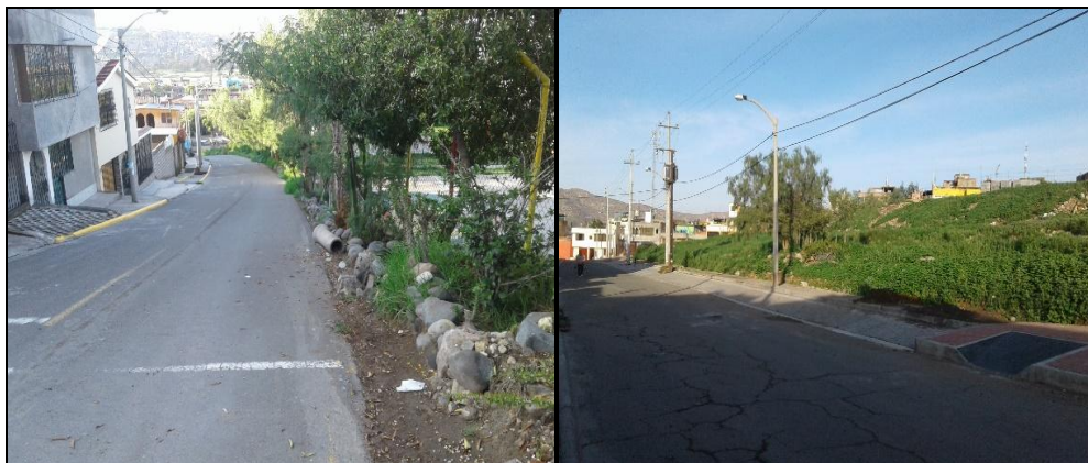
Grafico N° 4.13: Izquierda calle Lateral Pedro Paz, derecha calle nivel bajo Francisco Mostajo Fuente: Elaboración propia
