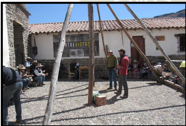
Fuente: Propia trabajo de Campo
