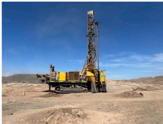
Figura 1 Perforación de taladros
