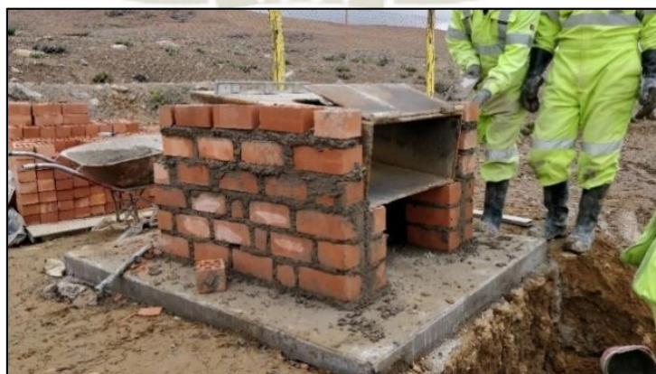
Figura 40: Proceso de construcción del horno para deshidratación de lodos.
