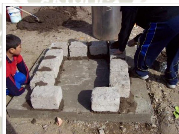
Figura 22: Construcción del leñero de horno artesanal de barro.
