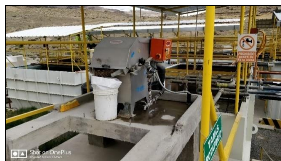
Figura 6: Tamiz rotatorio del tanque ecualizador de la PTARD dentro de la U.O.
