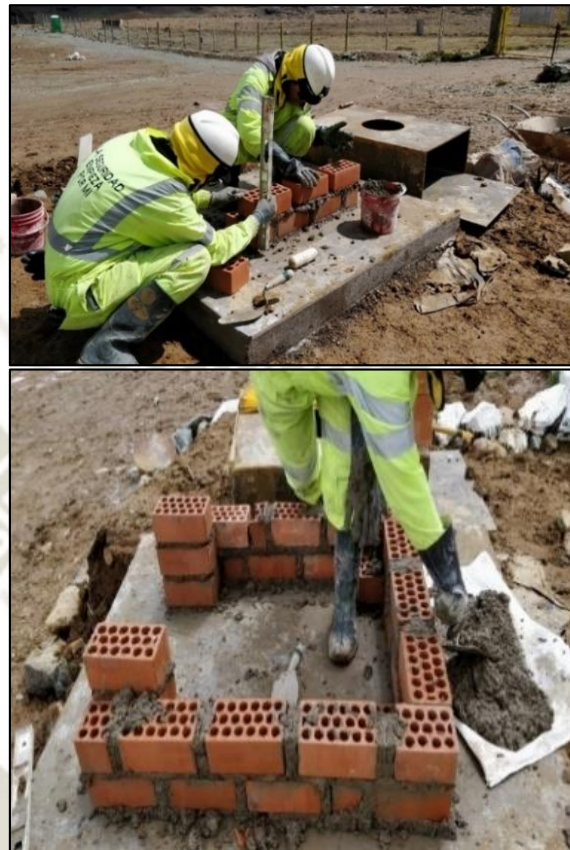
Figura 39: Construcción de estructura exterior de horno de deshidratación de lodos.
