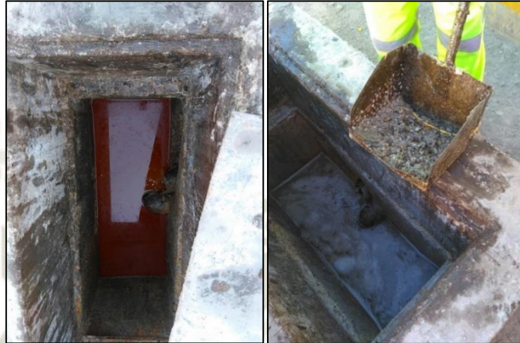
Figura 19: Sólidos y grasa acumulados en la antigua trampa de grasas en la U.O.
