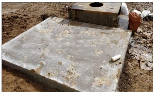
Figura 38: Loza de concreto de 1.5m x 1.8m construida en el relleno sanitario de la U.O.
