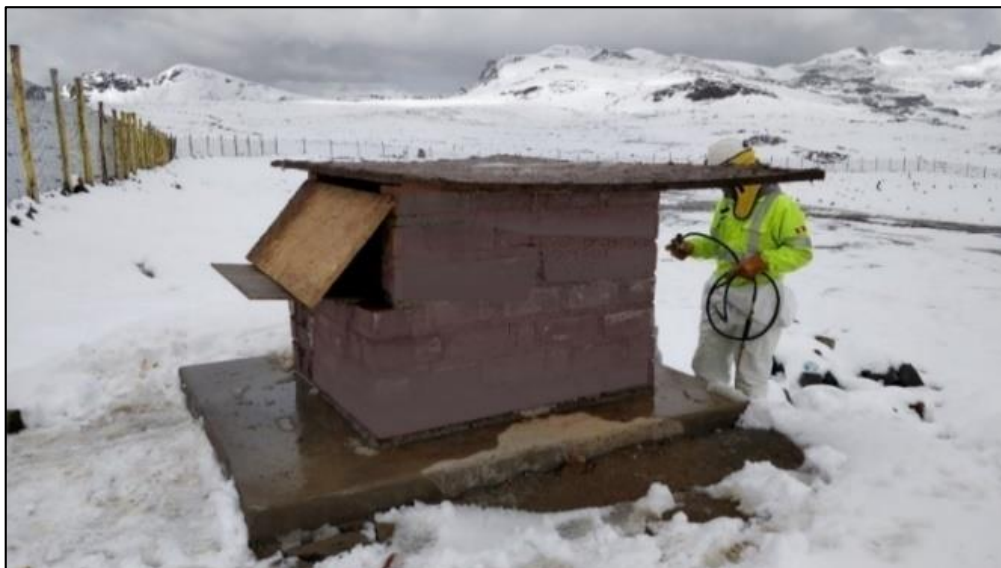
Figura 41: Estado final del horno para tratamiento de lodos de la U.O.
