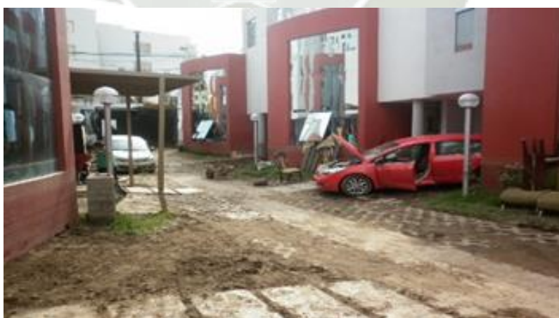
Fotografía 8. Viviendas Afectadas ubicadas en la Urb. Santa Rosa C.C. febrero 2016 Fuente: Obtenido de (SGGRD, 2016)
