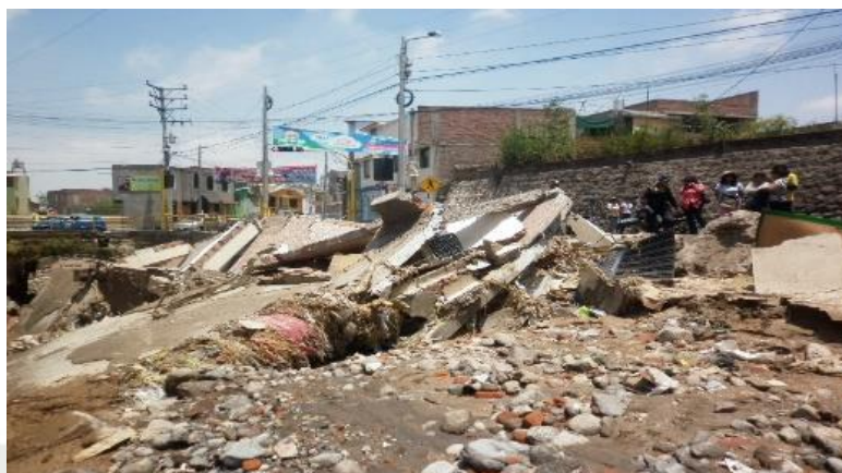
Fotografía 6. Vivienda destruida ubicada en Cerro Viejo C.C. febrero 2016 Fuente: Obtenido de (SGGRD, 2016)
