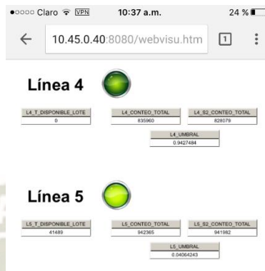
Figura 5.230. Visualización web del PLC M251 - supervisión de LP04 y LP05
