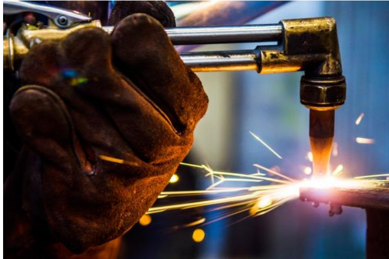
Figura 56. Proceso de soldadura
