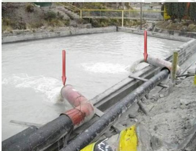
Figura 2. Descarga de las tuberías de conducción de las aguas de mina en la poza de acopio y sedimentación.
