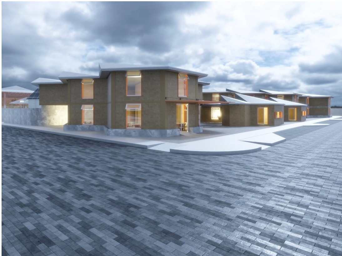
Figura 151. Vista de modelado 3D , del área construida en bloquetas .
