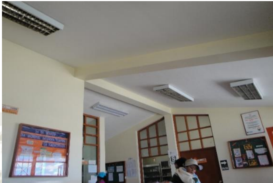
Figura 78. Interior de la posta de Imata .
