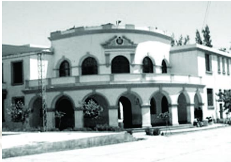
Figura 6. Fachada del antiguo local del colegio Independencia América , Arequipa -Perú.
