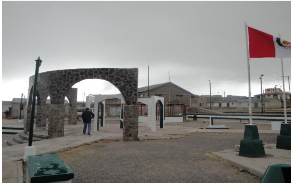
Figura 85. Vista del clima nublado y vientos fríos , plaza de Imata entre la carretera y los rieles .
