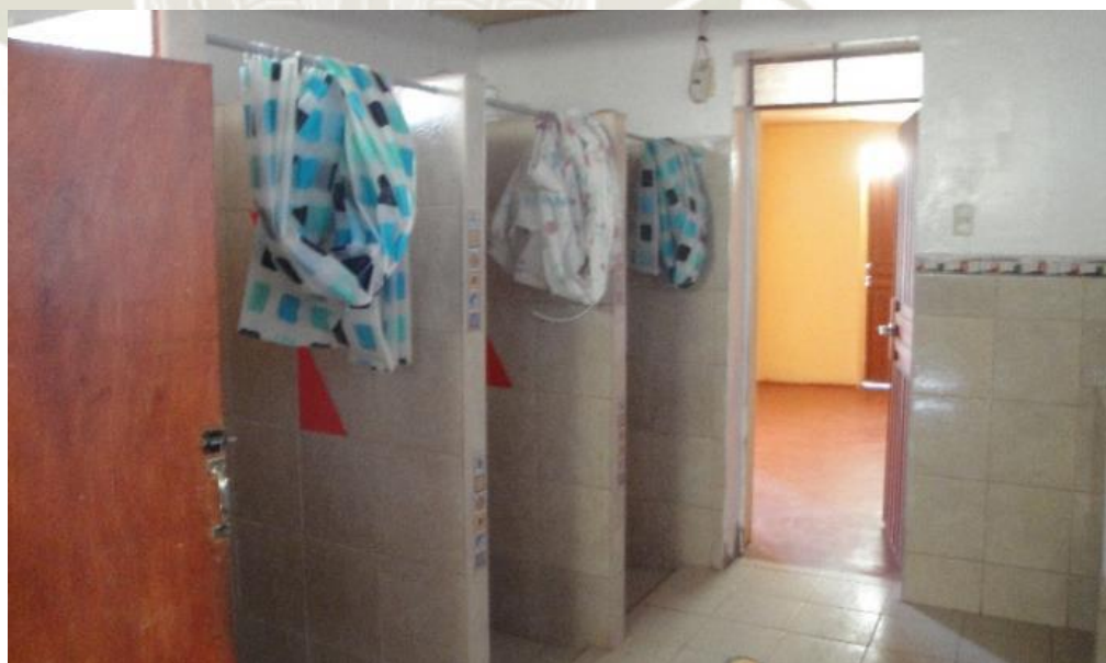
Figura 40. Vista de las duchas del internado.
