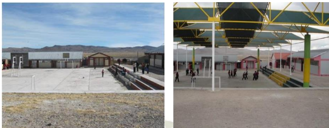
Figura 71.Derecha, Vista del patio principal de juego sin el techo .Izquierda. Vista del patio principal de juego con la estructura metálica y malla raschell..
