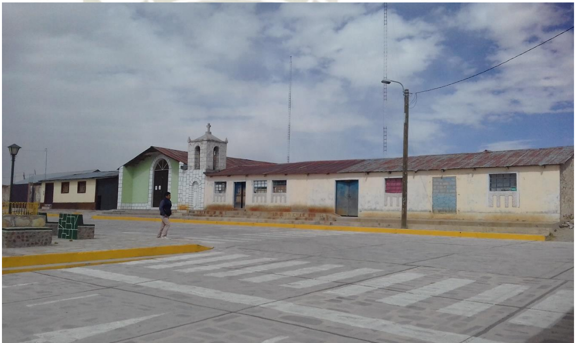
Figura 36. Fachada principal del Internado y la iglesia de Imata.
