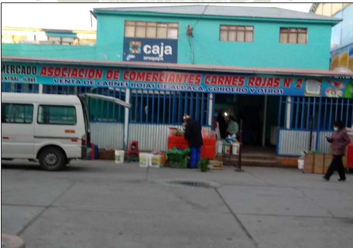
Fotografía 18. Mercado Central Ilave
