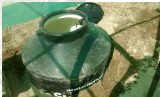
Fotografía N° 7: Colocación del depósito de agua.
