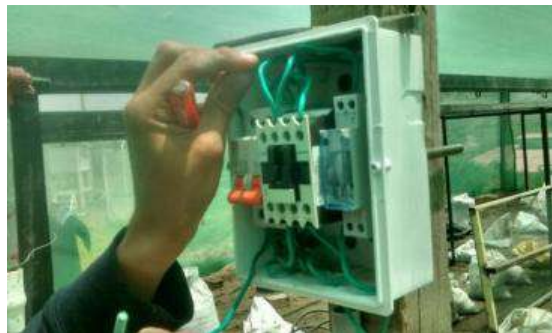
Fotografía N° 13: Unión del sistema.
