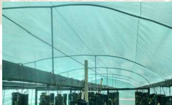
Fotografía N° 23: Cubierta de plástico a la altura del techo.
