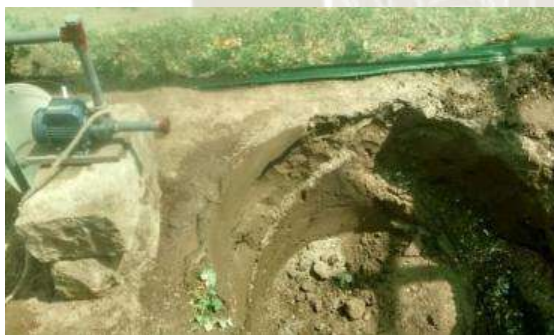
Fotografía N° 6: Realización del hoyo para la colocación del tanque.
