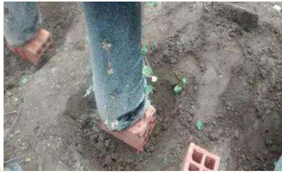
Fotografía N° 24: Ladrillo en la base para favorecer el drenaje del agua.
