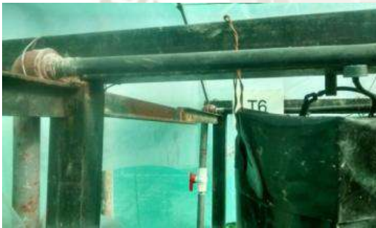
Fotografía N° 10: Instalación de tuberías de distribución-microirriego.
