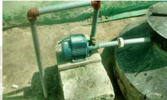
Fotografía N° 9: Instalación de la electrobomba.
