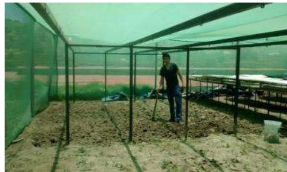
Fotografía N° 4: Eliminación de malezas, piedras y nivelación.
