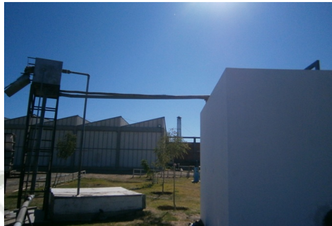
Figura 7: Fotografía de Separador de Sólidos
