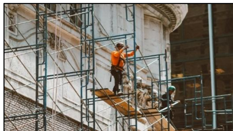
Figura 15 Sector de Construcción
