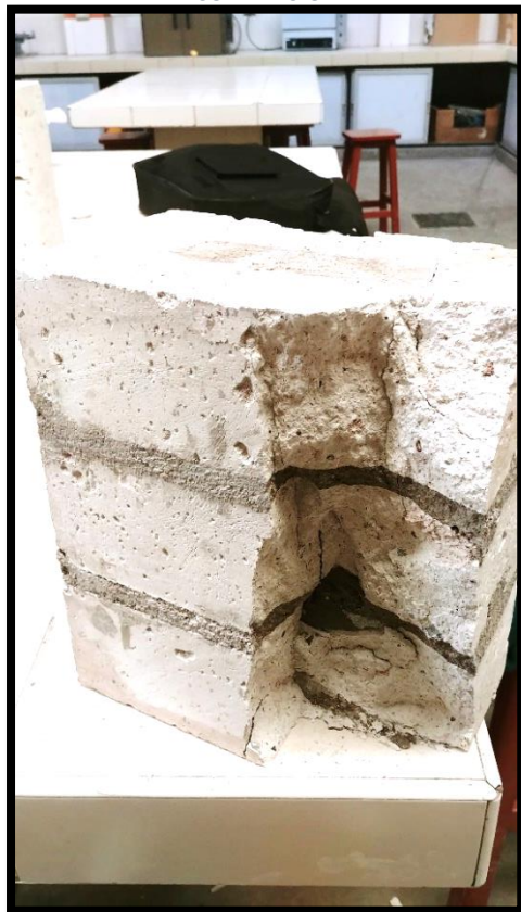
IMAGEN 3.28.- ENSAYO DE COMPRESIÓN AXIAL EN PRISMAS: PILA DE SILLAR TIPO P POST COMPRESIÓN
