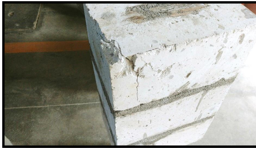
IMAGEN 3.31.- ENSAYO DE COMPRESIÓN AXIAL EN PRISMAS: PILA DE SILLAR TIPO G POST COMPRESIÓN
