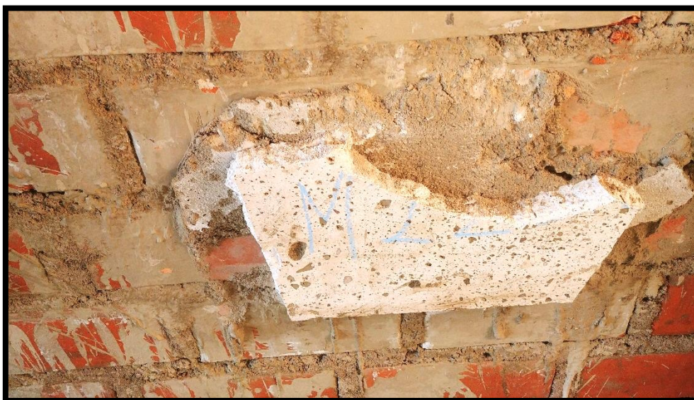
IMAGEN 4.10.- ENSAYO DE ADHESIÓN VERTICAL: ZÓCALO DE SILLAR CON MORTERO 02 DURANTE SU EXTRACCIÓN
