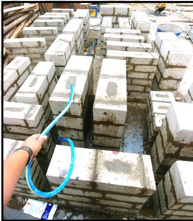
IMAGEN 2.01.- CURADO DE 27 MURETES DE SILLAR
