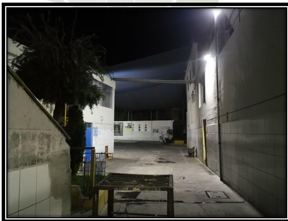
Fotografía N°28. Instalaciones del Camal Frigorífico Don Goyo visitado en la madrugada.
