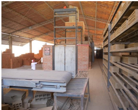
Llenado del Horno túnel mediante vagones
