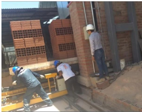
Descarga de vagones de ladrillo cocido del Horno Túnel
