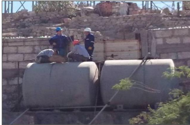
Medición de consumo del R500 mediante el método de la varilla
