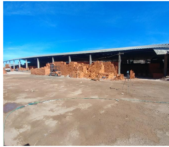
EMRO4: Área de almacenamiento de producto terminado
