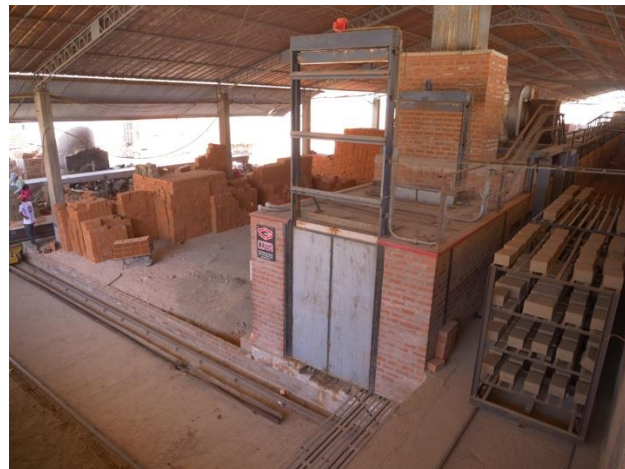
Área de cocción con el Horno túnel y los rieles de carga y producto terminado
