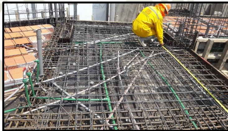
Figura 41: Fotografía losa maciza
