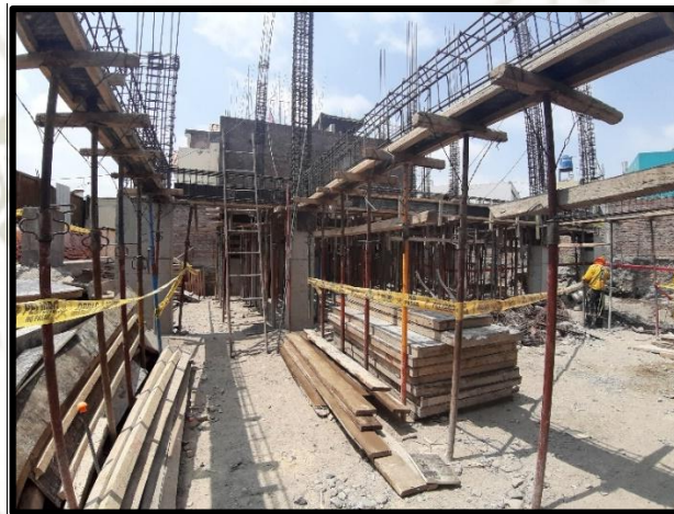
Figura 38: Fotografía encofrado de fondos de vigas y colocación de acero de vigas
