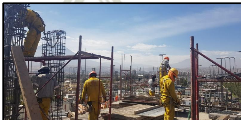
Figura 36: Fotografía cuadrilla de acero y encofrado
