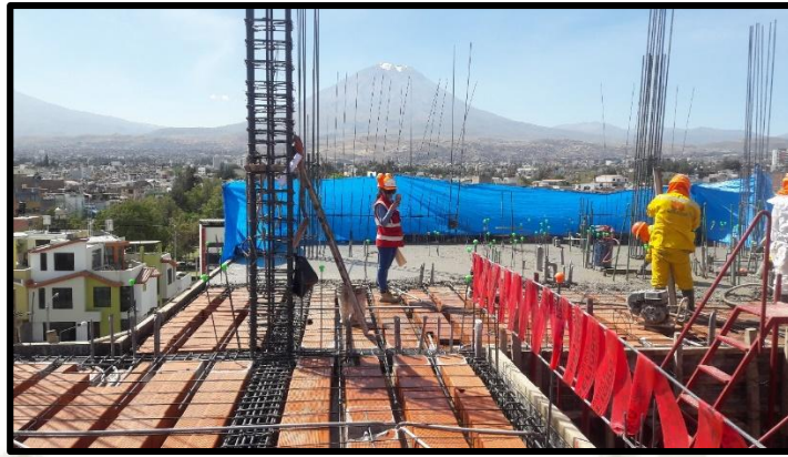
Figura 46: Fotografía control de seguridad en trabajos..
