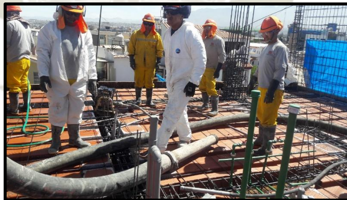
Figura 45: Fotografía Cuadrilla de vaciado de vigas y losas
