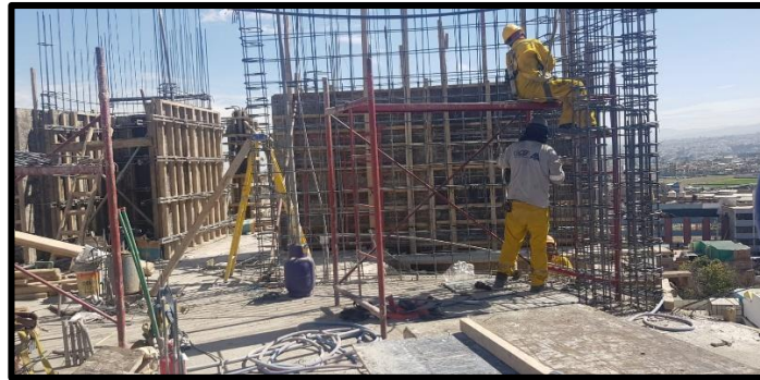
Figura 37: Fotografía cuadrilla de acero y encofrado elementos verticales
