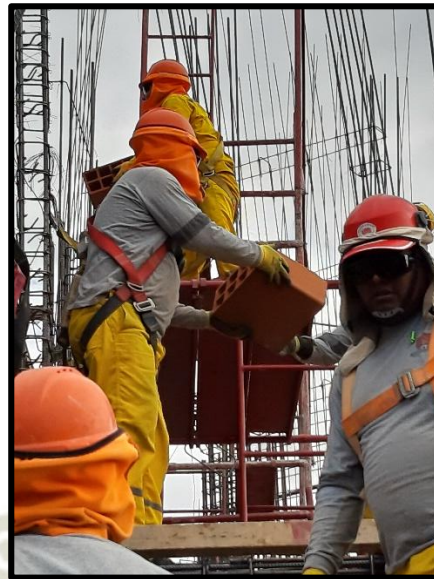
Figura 40: Fotografía colocación de ladrillos en techo
