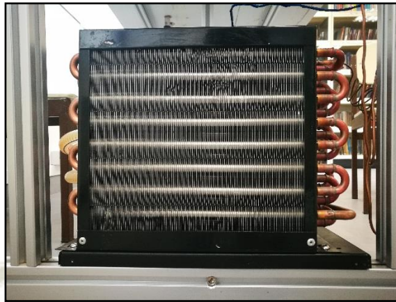
Figura 63: Condensador del equipo de refrigeración Chiller.
