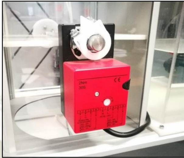
Figura 83: Servomotor de compuertas de ducto
