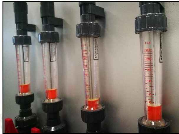
Figura 67: Caudalímetro de agua de 25 – 250 L/h
