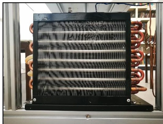
Figura 13: Evaporador de expansión directa instalado en el módulo.
