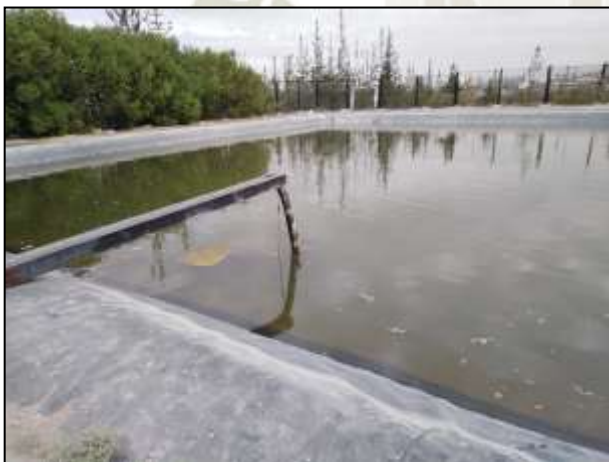
Figura 17. Pozo de sedimentación y almacenamiento de agua (Fuente: Elaboración propia)
