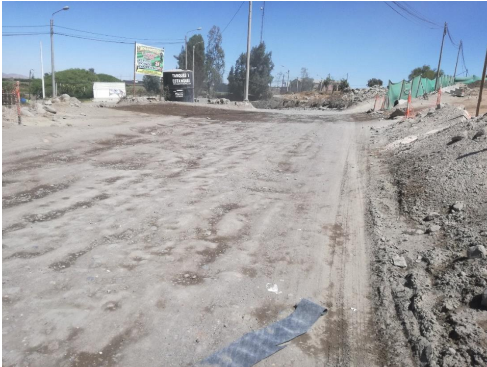
Figura 76. Ingreso a Callejón Arrayanes y Mojados – Estado Actual Fuente: Elaboración Propia
