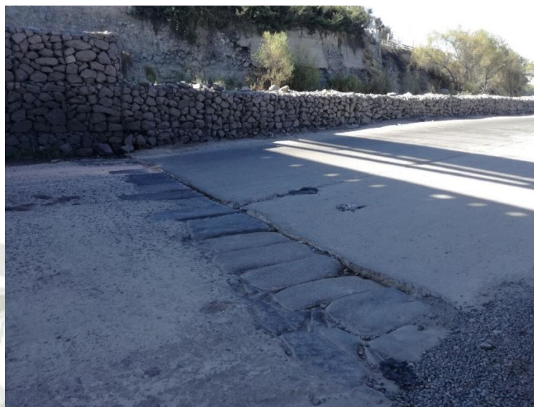
Figura 74. Vía Ribereña – Estado Actual Fuente: Elaboración Propia.
