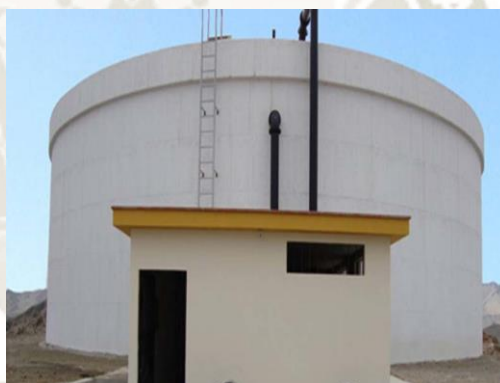
Figura 11. Reservorio concreto armado apoyado
