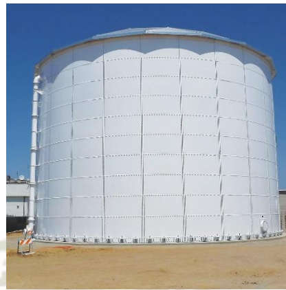
Figura 6. Reservorio de almacenamiento
