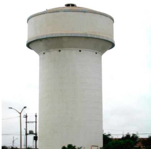
Figura 12. Reservorio concreto armado elevado
