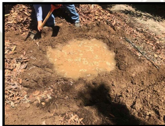
Fotografía 1: Construcción de bordes
