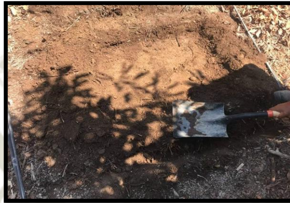
Fotografía 5: Limpieza del terreno
