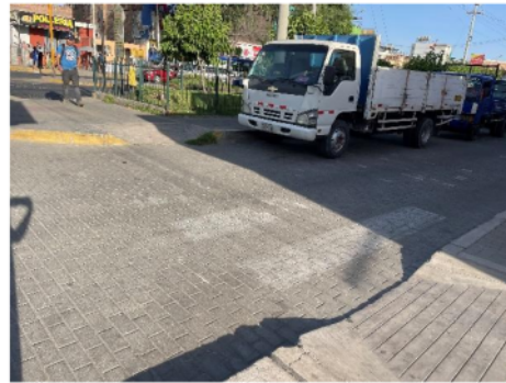
Foto 20: Desgaste de la señalización horizontal
