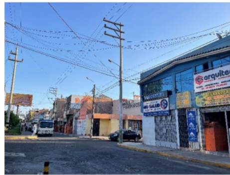
Foto 58: Ubicación de los postes de alumbrado
