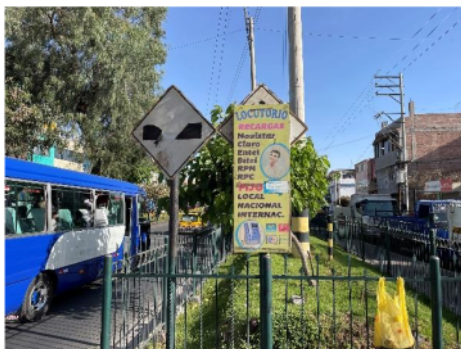
Foto 11: Obstaculización de la señalización vertical
