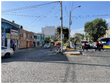
Foto 57: Ubicación de los postes de alumbrado
