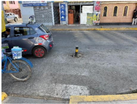
Foto 19: Desgaste de la señalización horizontal
