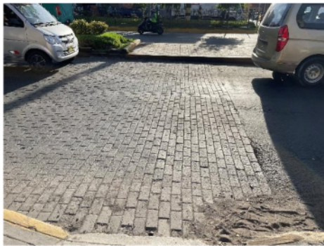
Foto 21: Desgaste de la señalización horizontal
