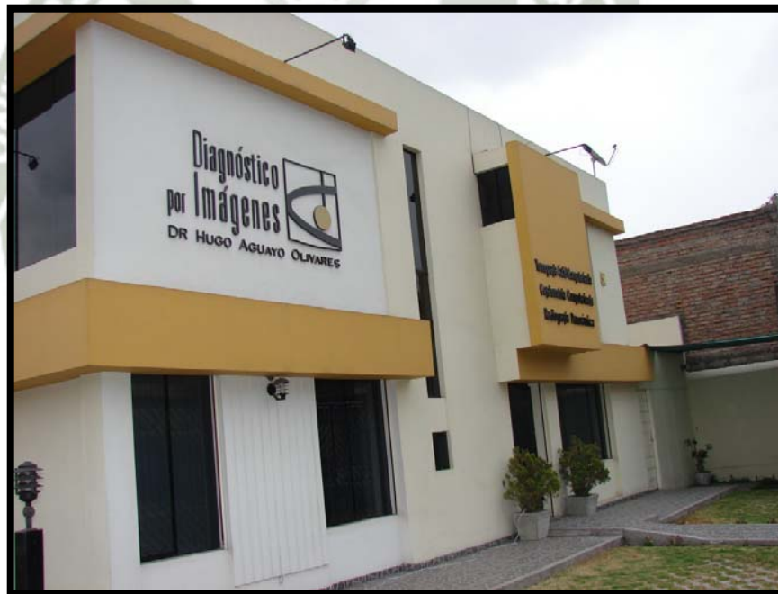
Centro de Diagnóstico por Imágenes, ubicado en calle Juan de Dios Salazar 282 Urb. La Perla – Cercado – Arequipa
