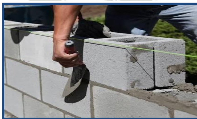
Figura 6 Cerco Perimétrico de bloquetas de concreto con buen acabado
