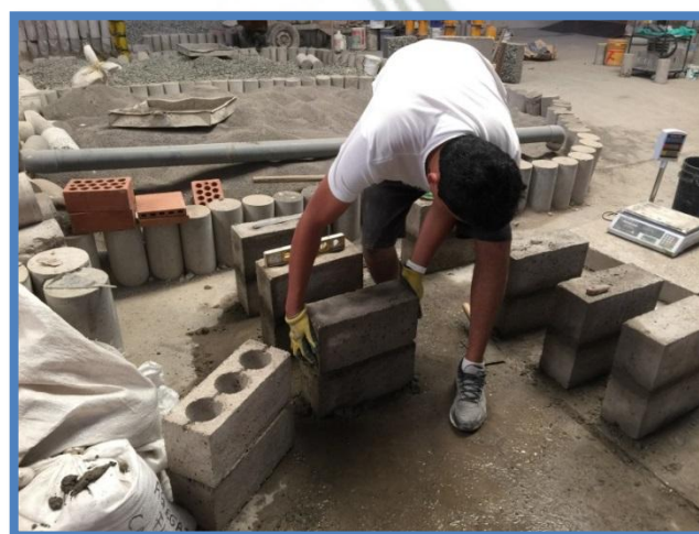
Figura 40 Proceso de asentado de bloquetas con mortero formando las pilas
