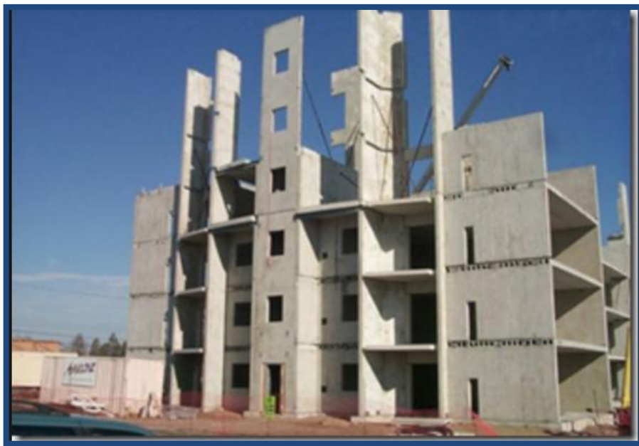
Figura 1 Empleo de prefabricados para edificaciones
