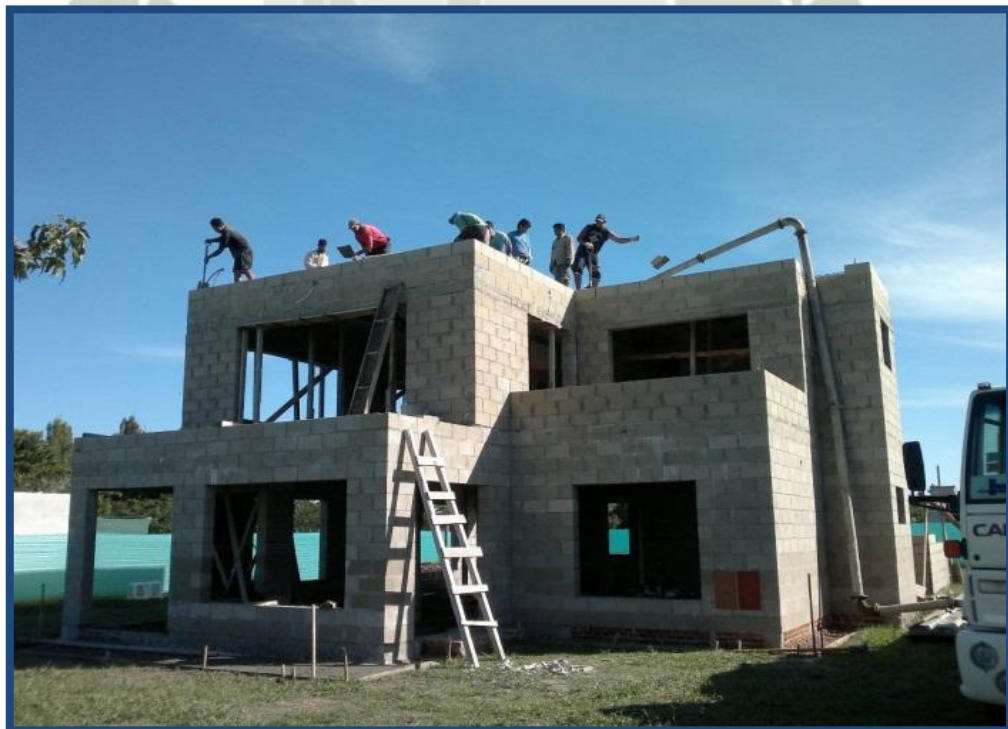
Figura 4 Construcción de Viviendas Unifamiliares con Bloquetas
