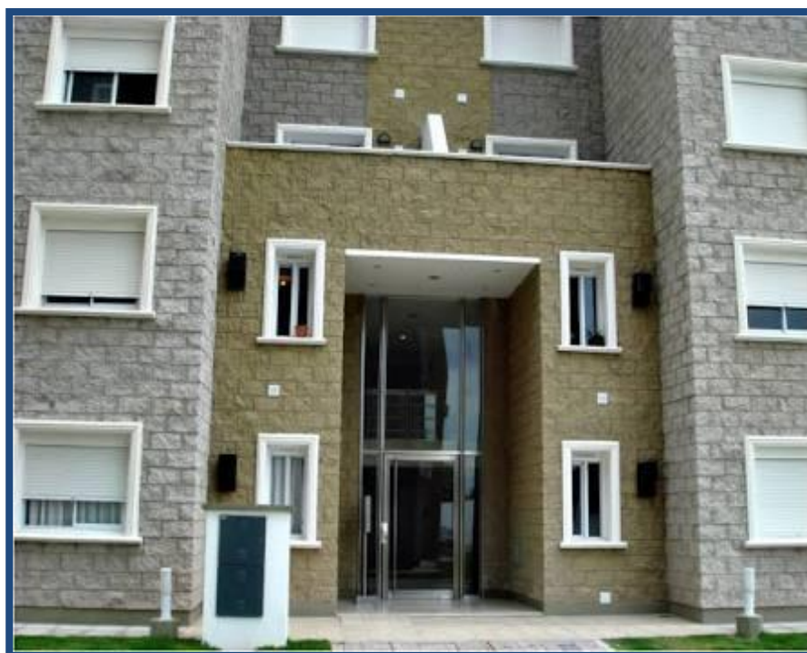
Figura 5 Construcción de Viviendas Multifamiliares con Bloquetas
