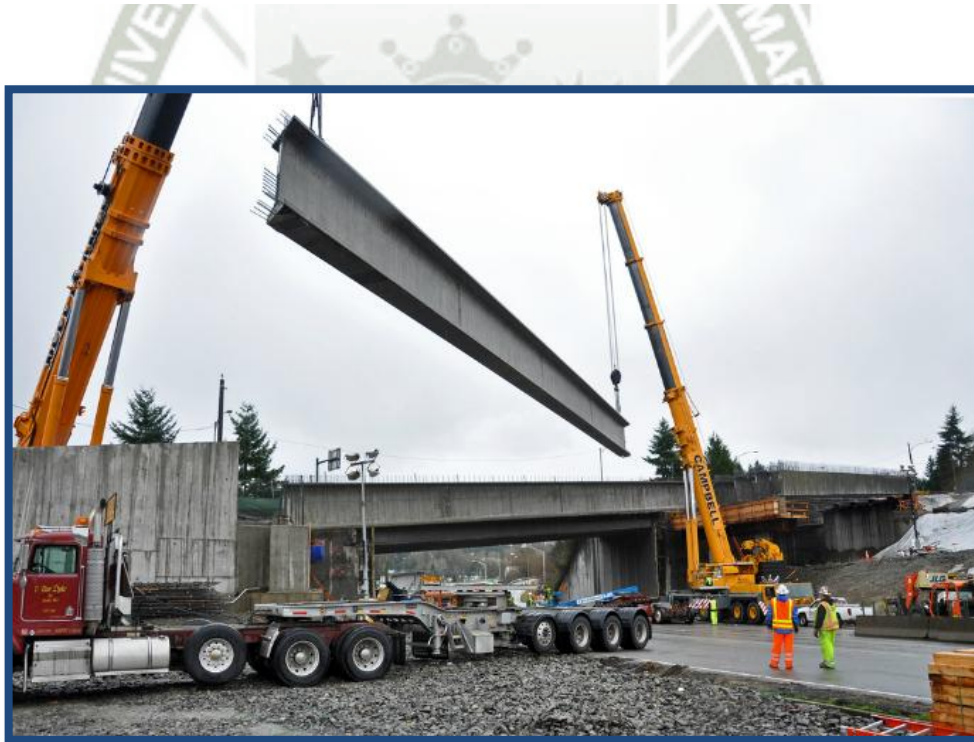
Figura 2 Montaje de prefabricados para puentes
