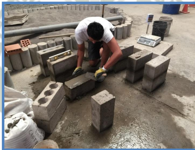
Figura 39 Colocación y nivelado del mortero en la bloqueta
