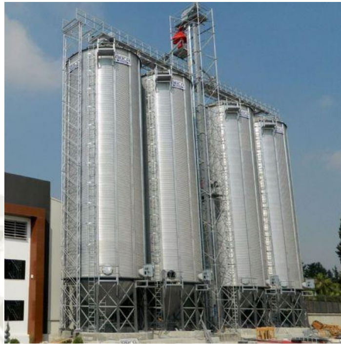
Figura N° 13: Silos de materia prima
