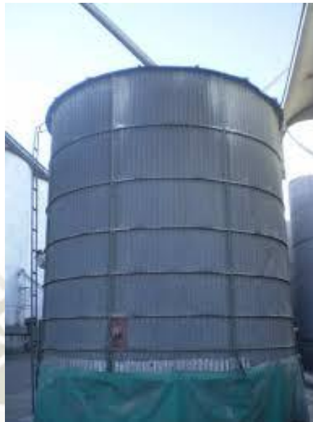
Figura N° 21: Silos de descanso
