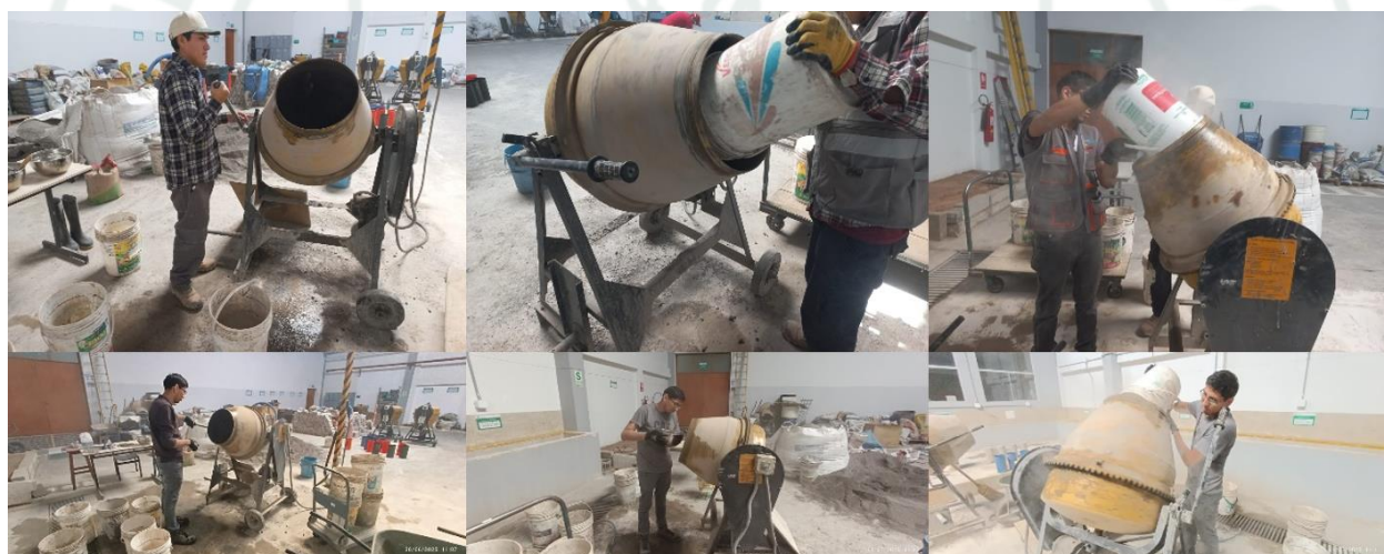
Figura 127 Procedimiento de carga y adición de componentes para la elaboración de la mezcla de concreto
