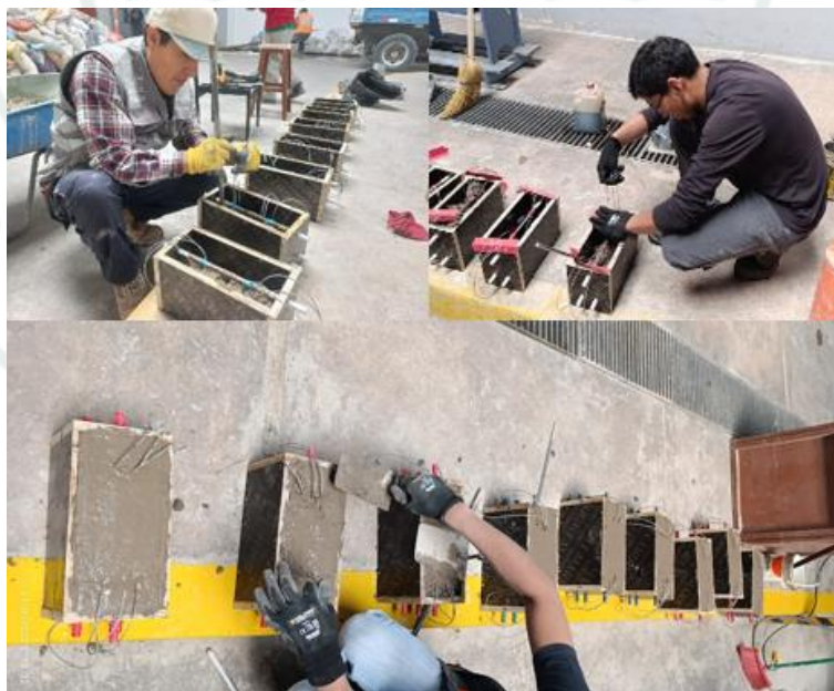
Figura 131 Procedimiento de enrasado y acondicionamiento de las salidas eléctricas en las probetas prismáticas
