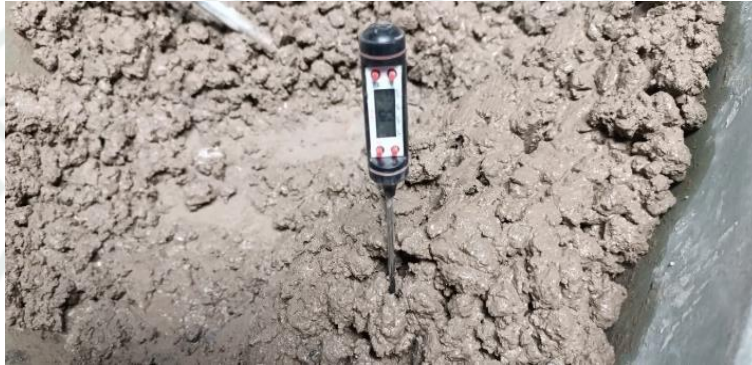
Figura 45 Prueba de temperatura del concreto fresco
