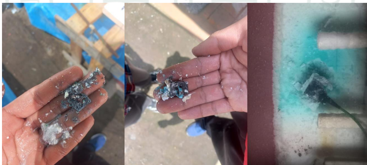
Figura 145 Corrosión y consumo de ánodos
