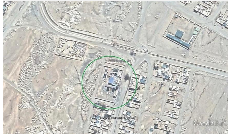
Planta de Tratamiento de Agua Potable El Pedregal
