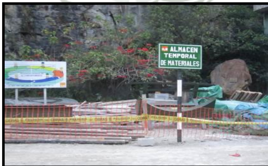
Figura 38 - Instalación de letrero informativo: "Almacén temporal de materiales".
