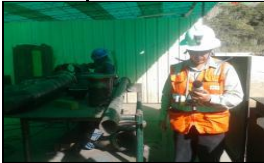
Figura 49 - Taller de soldadura
