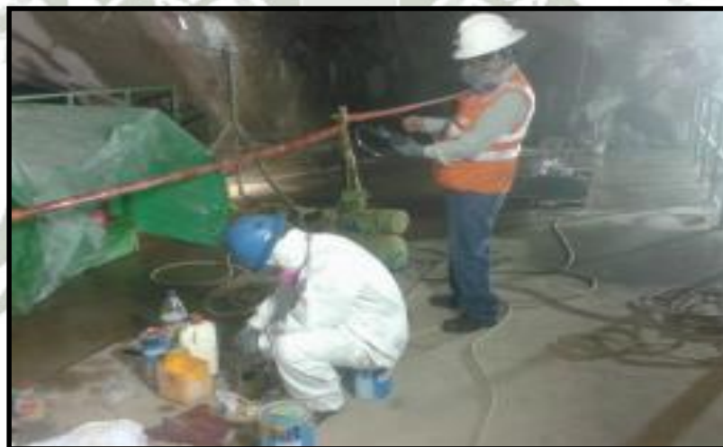
Figura 53 - Monitoreo de gases trabajos de pintura
