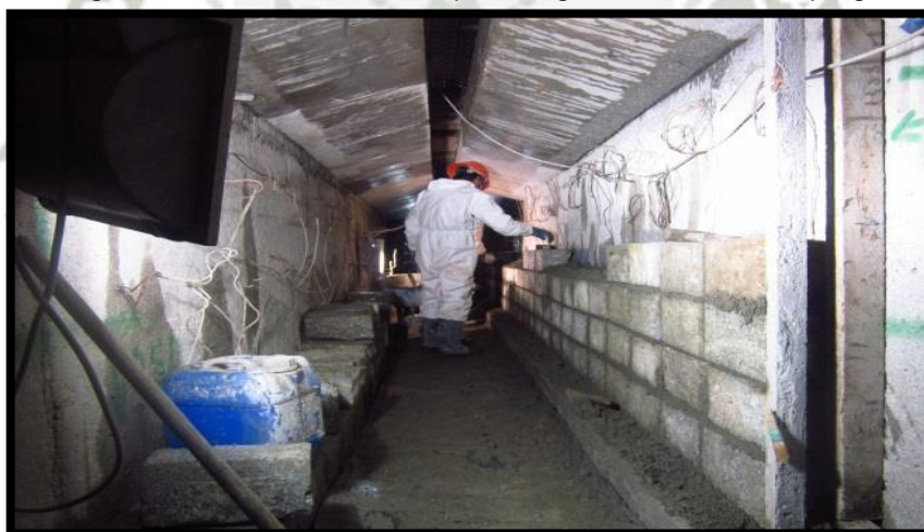
Figura 34 - Colocación de bloques de granito en canal de purga.
