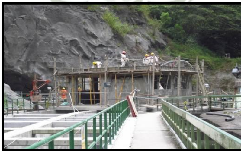
Figura 32 - Colocación de concreto en Caseta de Control km 107
