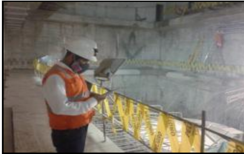
Figura 47 - Diversas actividades spiral case, casa de maquinas
