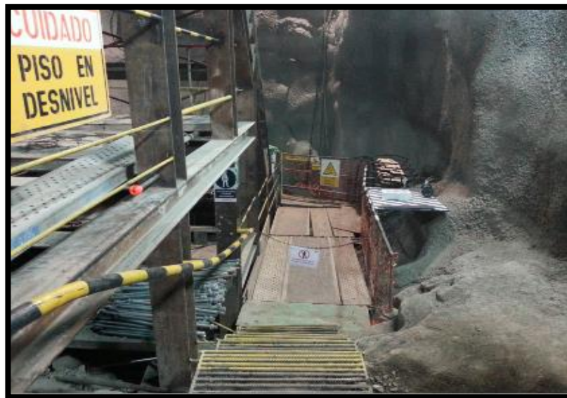
Figura 29 - Señalización de ingreso al Winche
