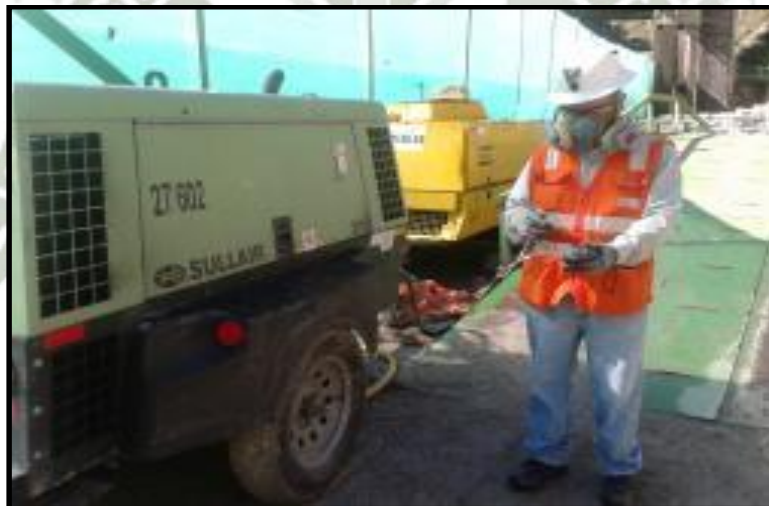
Figura 51 - Monitoreo de gases trabajos de esmerilado
