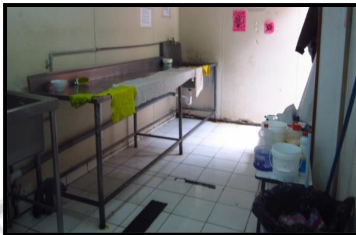
Figura 61 - Inspección cocina Panaservice
