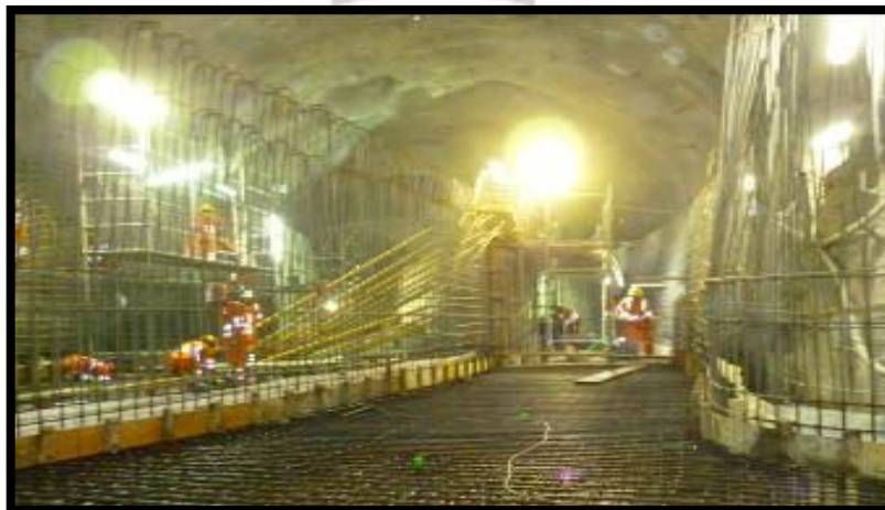
Figura 30 - Colocación de acero en piso (losa) y muros
