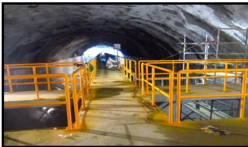
Figura 33 - Colocación y pintado de barandas definitivas.
