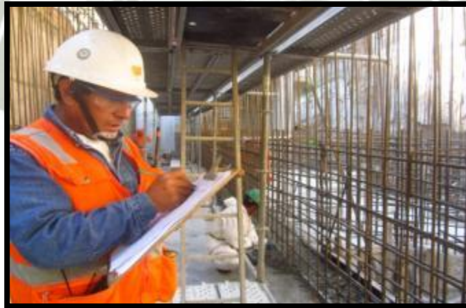
Figura 22 - Inspección de andamios
