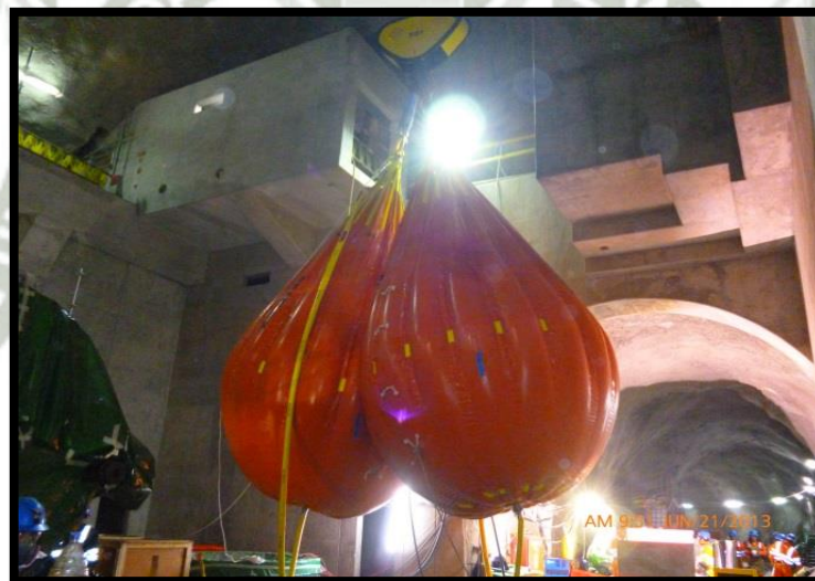
Figura 28 - Prueba de carga del puente grúa de 50 toneladas.
