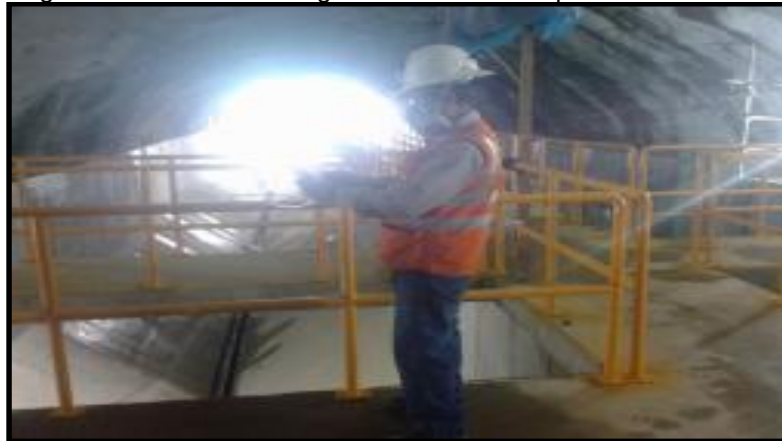
Figura 52 - Monitoreo de gases cerca de compresora EGEMSA
