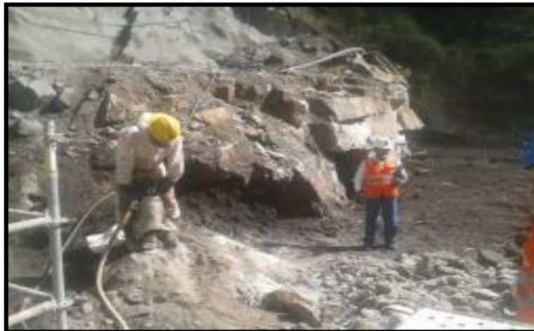
Figura 43 - Medición de ruido cerca de personal perforando con Jack leg
