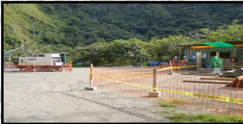
Figura 37 - Colocación de delineadores móviles, cintas y mallas de seguridad.
