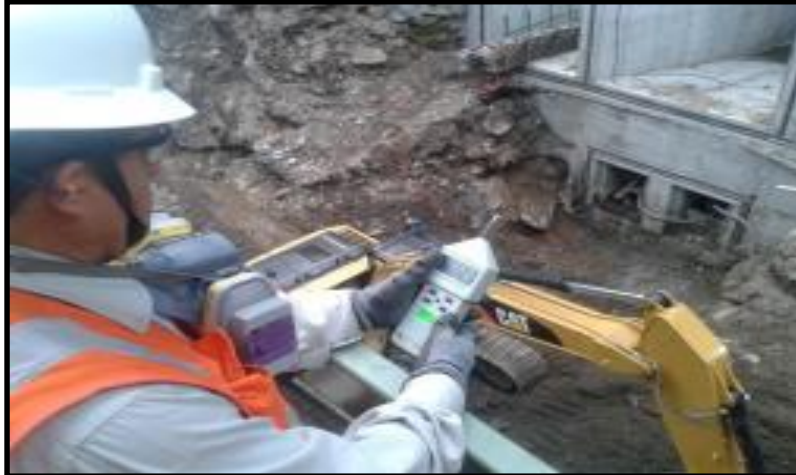
Figura 45 - Medición de ruido maquinaria pesada realizando trabajos de excavación
