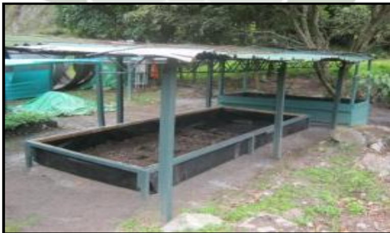
Figura 57 - Cancha de volatilización ubicado en el km 122
