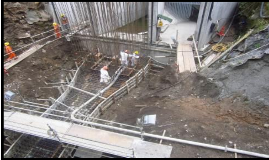
Figura 35 - Colocación de concreto en Canal de Purga.
