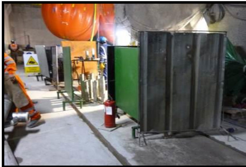
Figura 27 - Uso de biombos metálicos como protección para los trabajos de esmerilado.
