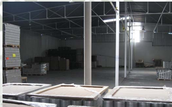
Imagen 6- Deficiente señalización en áreas de almacén
