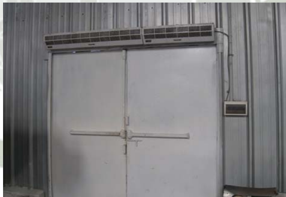
Imagen 8.- Puerta sin ninguna señalización
