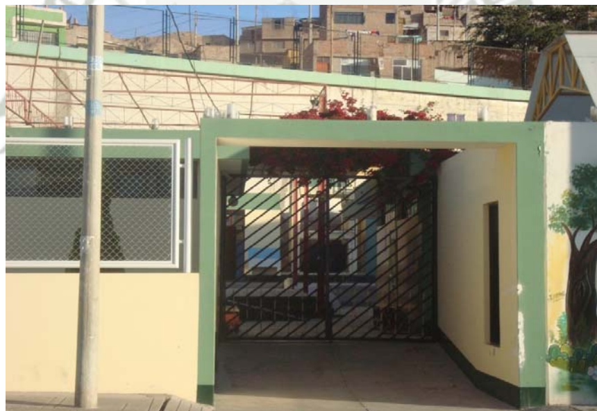
ILUSTRACION N° 16. Se puede apreciar en la entrada del colegio que tiene rampas y en los costados de la berma.
