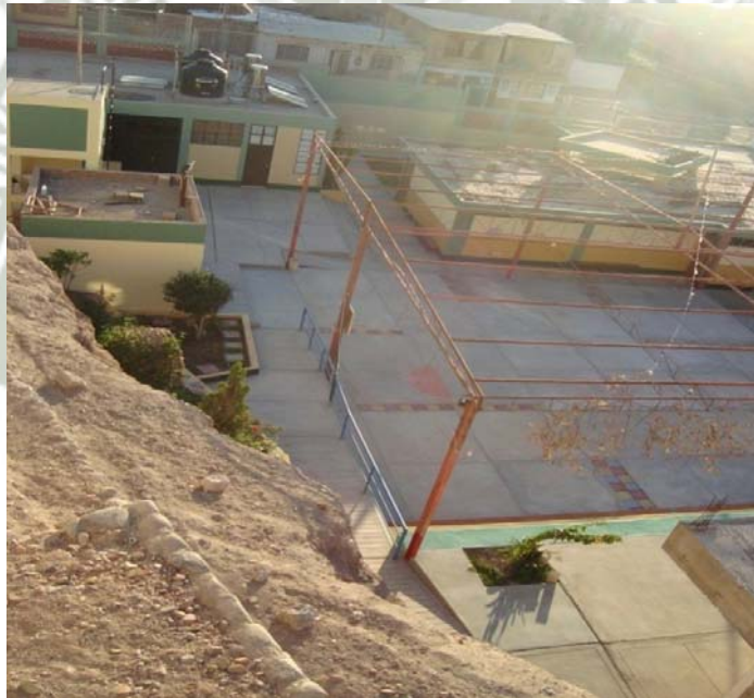
ILUSTRACION N° 22. Se puede apreciar el desbordamiento del cerro.
