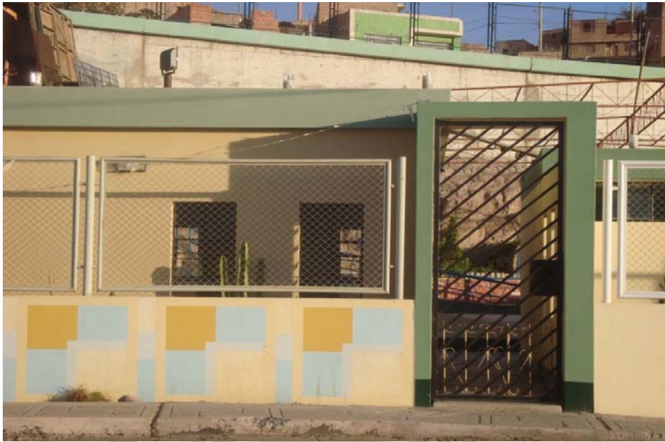
ILUSTRACION N° 17. Se puede apreciar en la otra puerta de entrada que también tiene rampa de Acceso.
