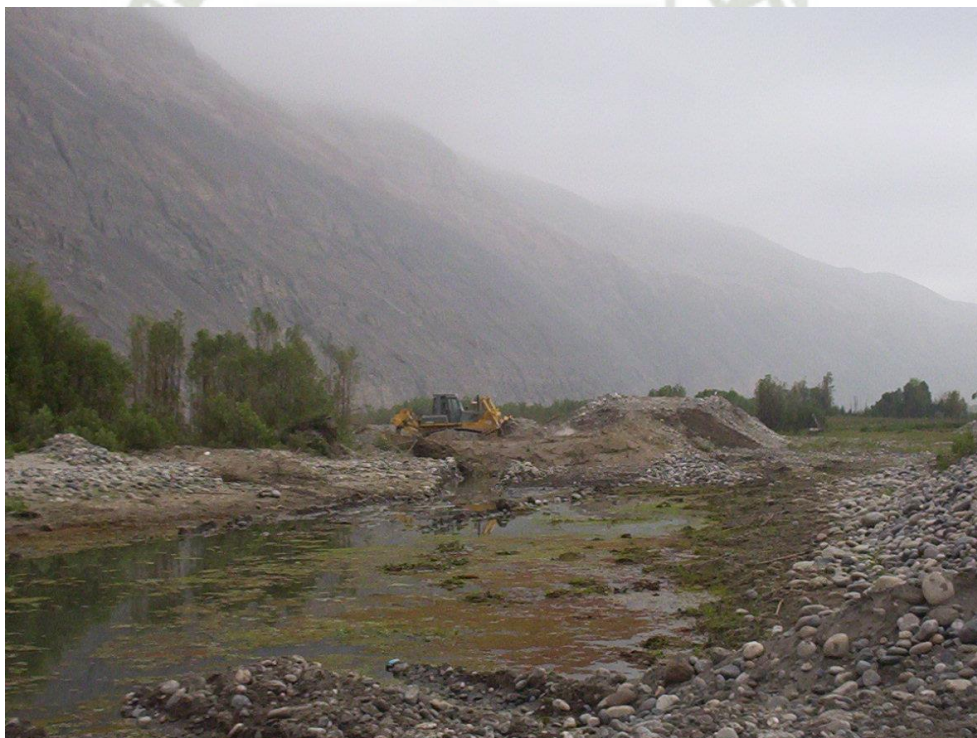
Ilustración 13. Construcción de terraplén.
