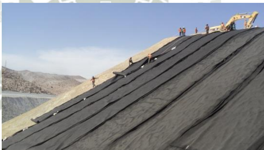
Foto 14: Cuadrado de panel de Geocompuesto
