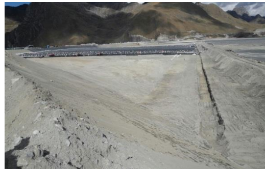
Foto 129: Excavación de Zanja de anclaje en Playa de Relaves y Espigón - Antamina
