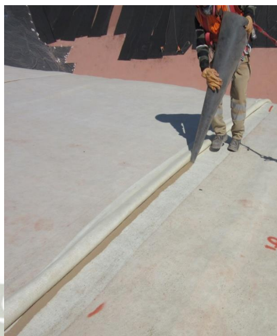
Foto 50: Sellado de uniones de paneles de GCL con Bentonita - Cujone
