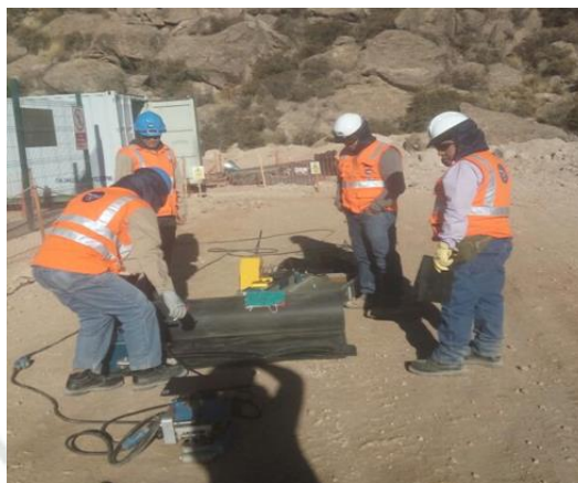
Foto 82: Movilización y Desmovilización de Instalaciones - Quellaveco
