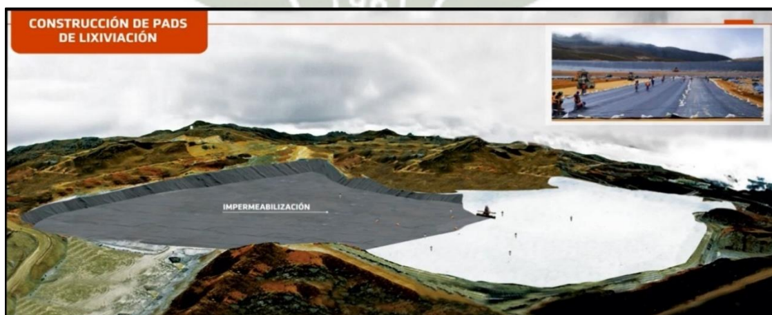
Grafico 5: Construcción de PAD – Impermeabilización
