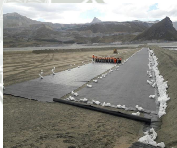
Foto 125: Despliegue manual de paños largos en IDT0025 - Antamina
