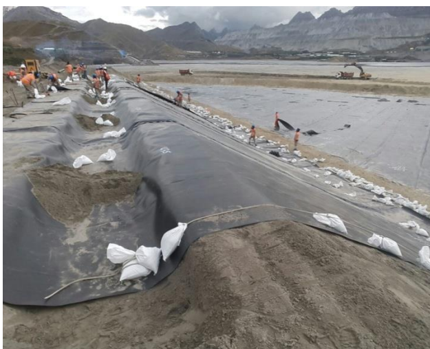
Foto 127: Revestimiento en Espiños de IDT0027 - Antamina
