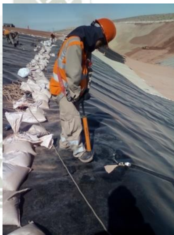
Foto 56: Pruebas de Calidad en Uniones - Cuajone
