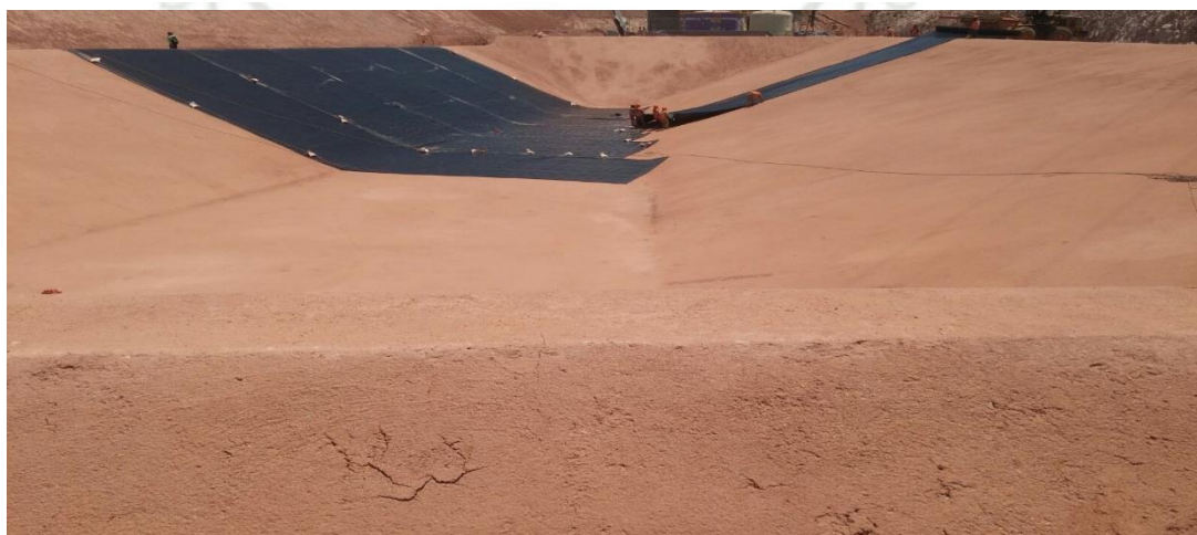
Foto 47: Despliegue de Geomembrana con cargador frontal (Poza de Mayores Eventos) - Cuacone
