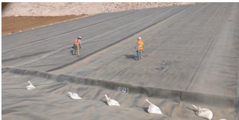
Foto 72: Inspección para entregas de área en Talud - Quellaveco
