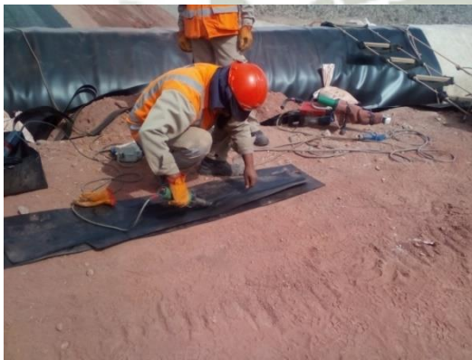
Foto 19: Preweld y soldadura de geomembrana - Cuajone
