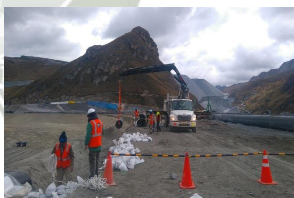
Foto 131: Revestimiento con Geomembrana en playa de Relaves - Antamina
