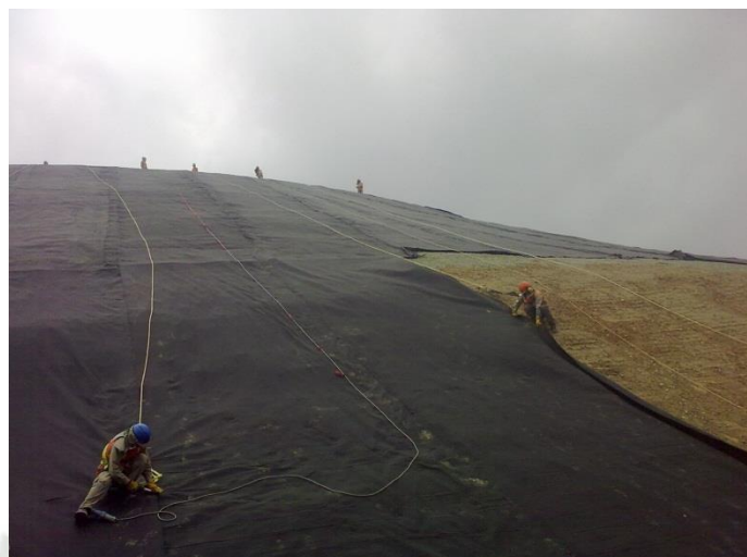
Foto 15: Unión de paneles de Geocompuesto
