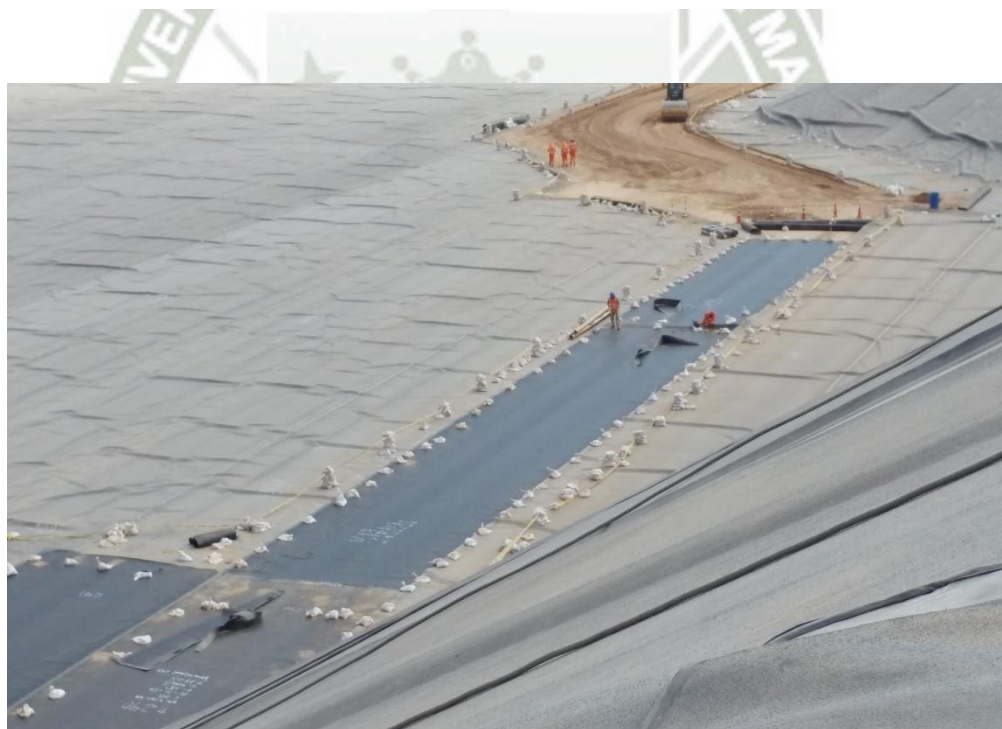
Foto 81: Completando impermeabilización de área que se utilizaron como acceso - Quellaveco
