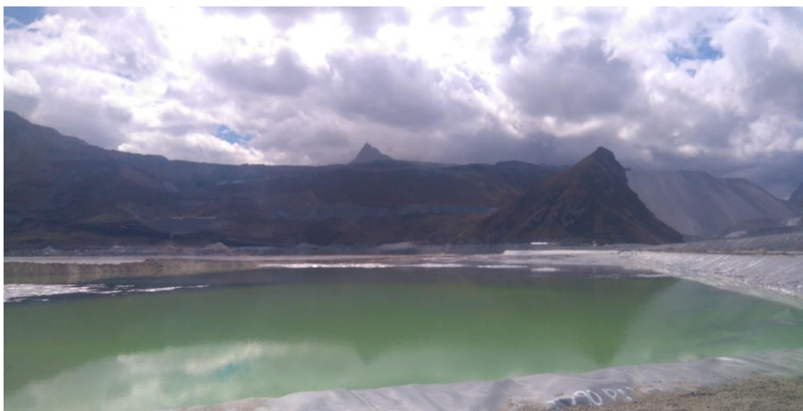
Foto 132: Playa de Relaves finalizada y en funcionamiento - Antamina
