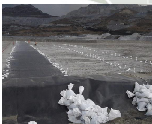
Foto 131: Revestimiento con Geomembrana en playa de Relaves - Antamina
