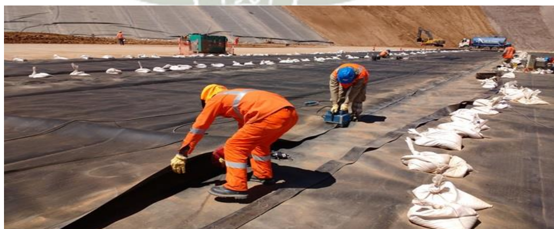
Foto 77: Sacos en uniones de paneles para ser soldados - Quellaveco
