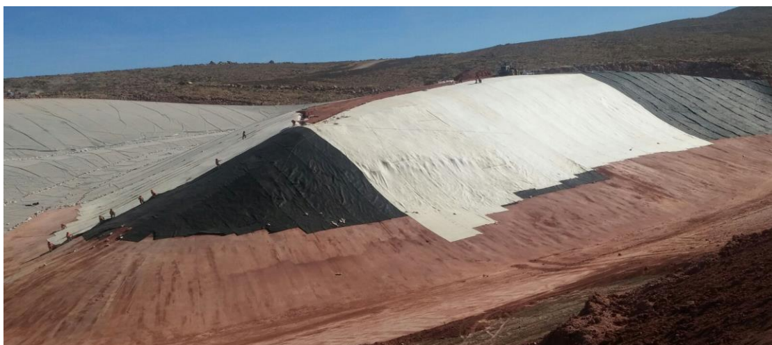
Foto 46: Despliegue de Geomembrana con Cargador Frontal (Sector 3 - PAD) - Cuajone
