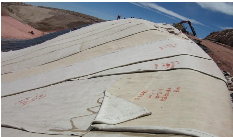
Foto 10: Despliegue de GCL - Cuacone
