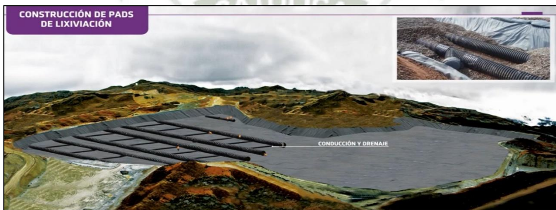
Gráfico 7: Construcción de PAD - Tubería de Colección
