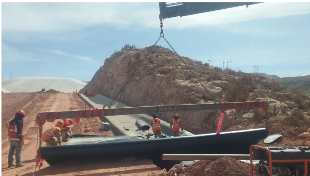
Foto 36: Despliegue Geomembrana con Camión Grúa (Canal PLS) - Cuajone
