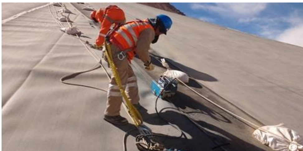
Foto 71: Cierre de costuras por Fusion en Talud - Quellaveco
