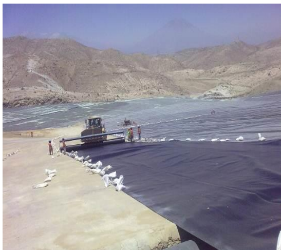
Foto 73: Ejemplos de despliegue con Cargador frontal en pendiente 0
