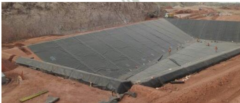
Foto 53: Vista Panorámica del Revestimiento PME - Cuajone
