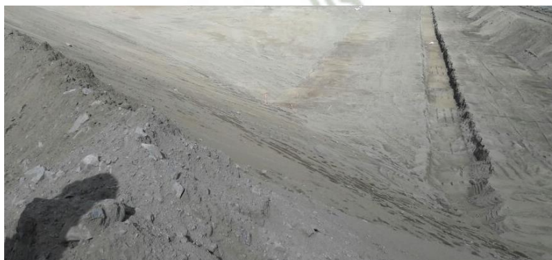
Foto 103: Excavación de Zanja de Anclaje Playa de relaves Sector A - Antamina
