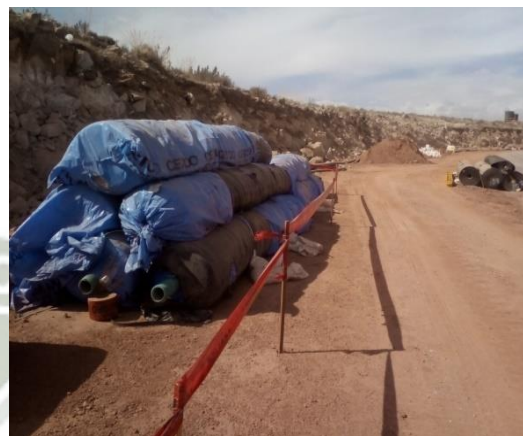
Foto 21: Acopios de rollos de Geosintéticos - Cuajone
