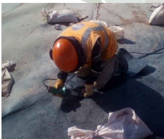
Foto 23: Soldadura por Extrusión y Fusión - Cuajone
