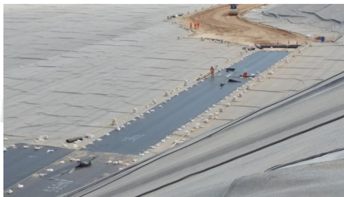
Foto 88: Cierre con geomembrana de áreas que se utilizaron de acceso - Quellaveco
