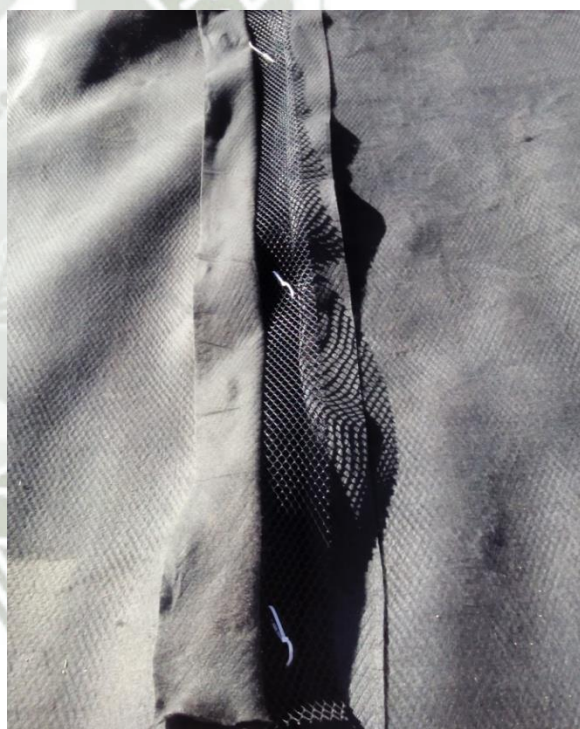
Foto 50: Sellado de uniones de paneles de GCL con Bentonita - Cujone
