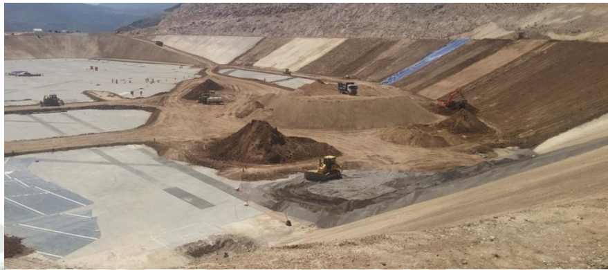
Foto 60: Evidencia de entregas de área por Islas en talud y Base - Quellaveco
