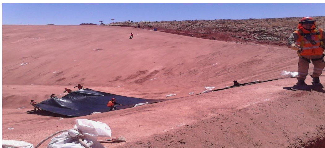
Foto 29: Desenrollando Geomembrana (Sector 2 - PAD) - Cuajone
