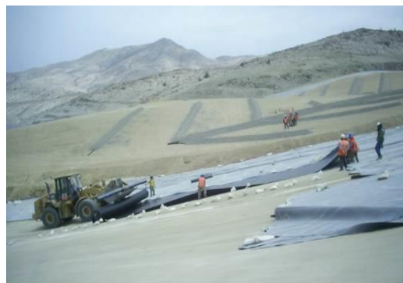
Foto 73: Ejemplos de despliegue con Cargador frontal en pendiente 0
