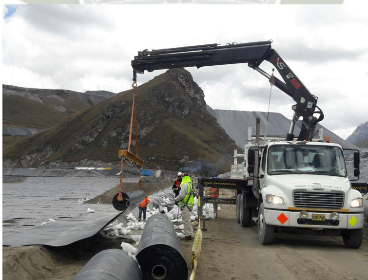
Foto 105: Despliegue con Camión Grúa Sector B - Antamina
