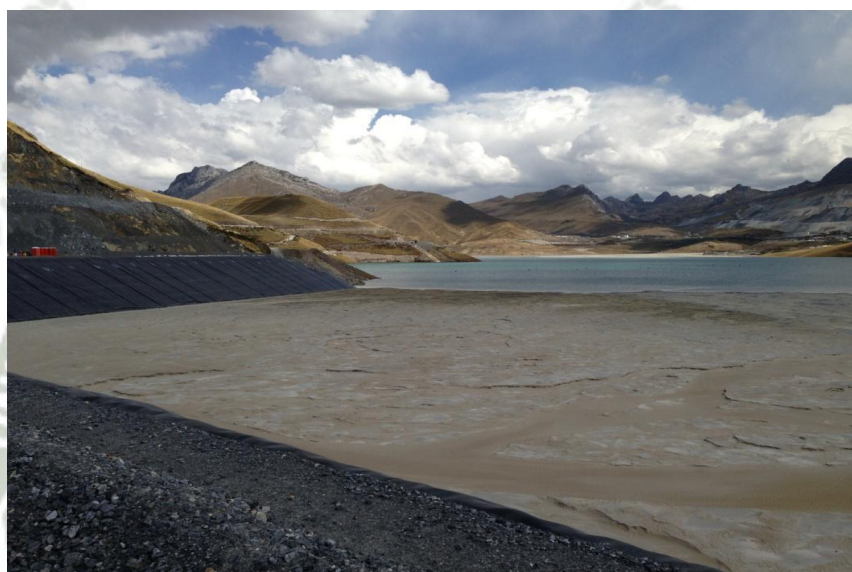
Foto 4: Presa de relaves - Antamina
