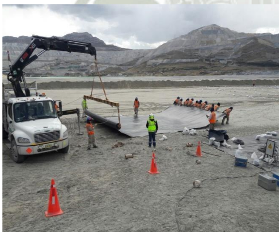
Foto 126: Despliegue con Camión grúa de paños cortos en IDT0025 - Antamina
