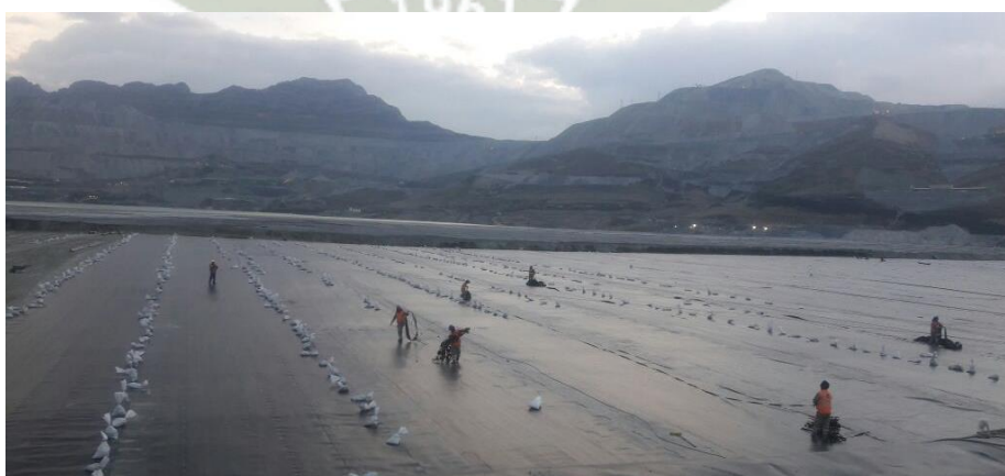
Foto 111: Asegurando paneles desplegados con sacos de lastre - Antamina
