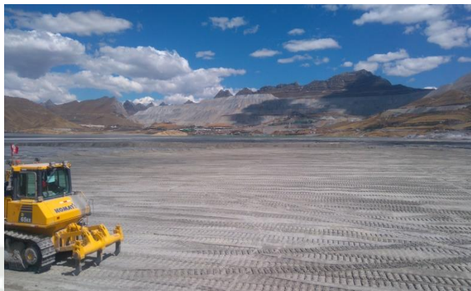
Foto 104: Entrega de área para revestimiento - Antamina
