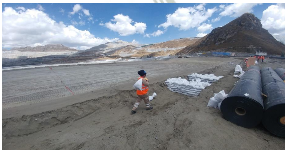
Foto 115: Apoyo con sacos de lastre para rollo en Zanja de Anclaje - Antamina
