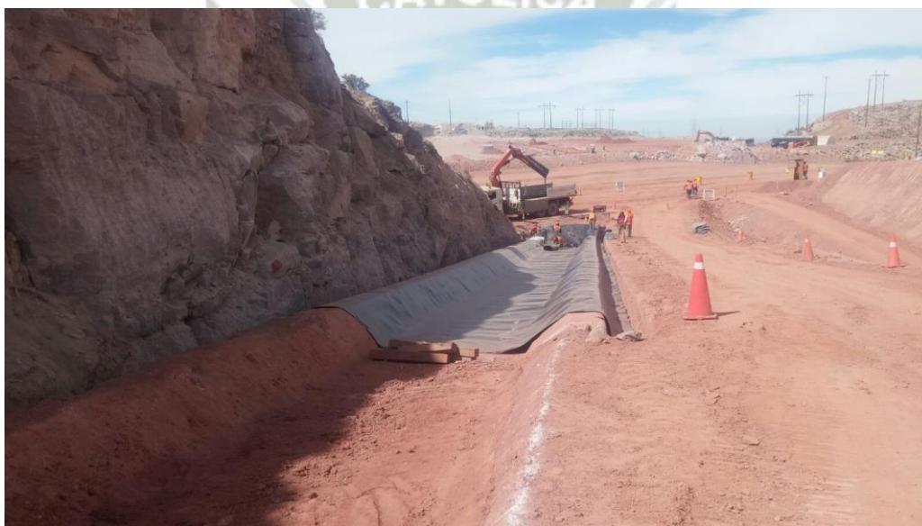
Foto 35: Despliegue Geomembrana con Camión Grúa (Canal PLS) - Cuajone
