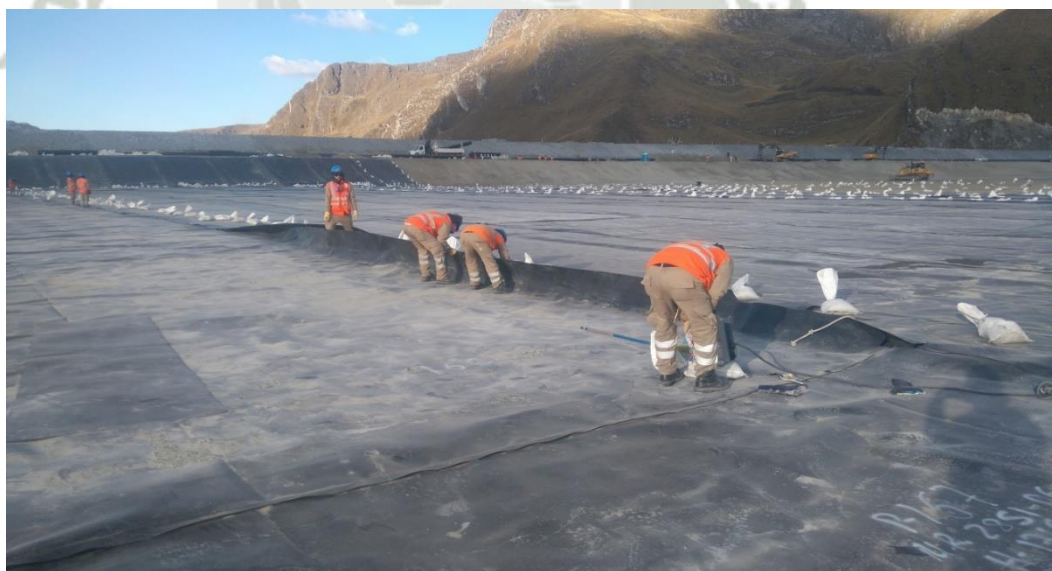
Foto 142: Limpieza de uniones para Soldadura por Fusión - Antamina
