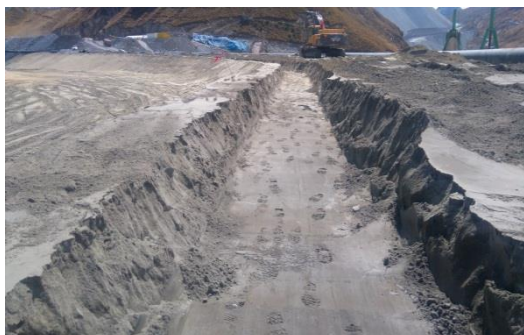
Foto 129: Excavación de Zanja de anclaje en Playa de Relaves y Espigón - Antamina
