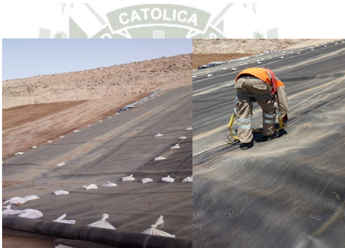
Foto 66: Panel instalado en el día es panel soldado - Quellaveco
