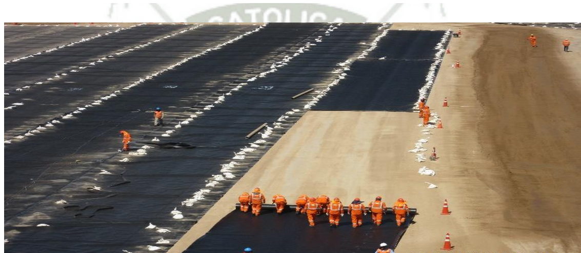
Foto 75: Desenrollado manual de rollo en Base de Poza - Quellaveco
