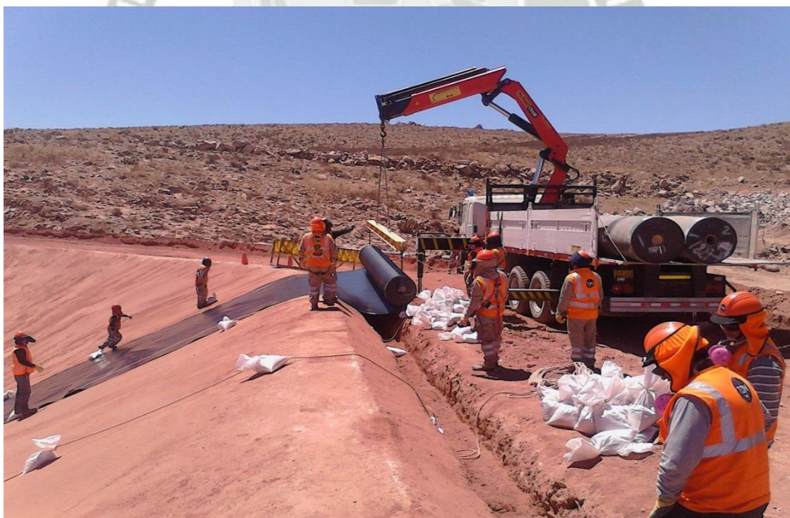
Foto 25: Despliegue con Camión Grúa (Sector 2A - PAD) - Cuaione
