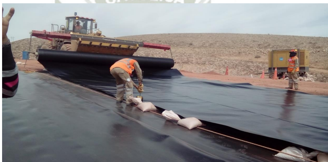
Foto 40: Despliegue con Cargador frontal (Sector 2 - PAD) - Cuajone
