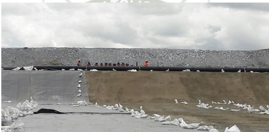
Foto 116: Rollos apilados a lo largo del espigón para despliegue manual – Antamina
