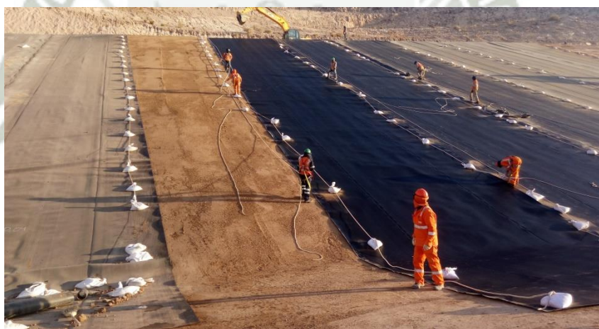
Foto 62: Anclaje de personal en Talud - Quellaveco
