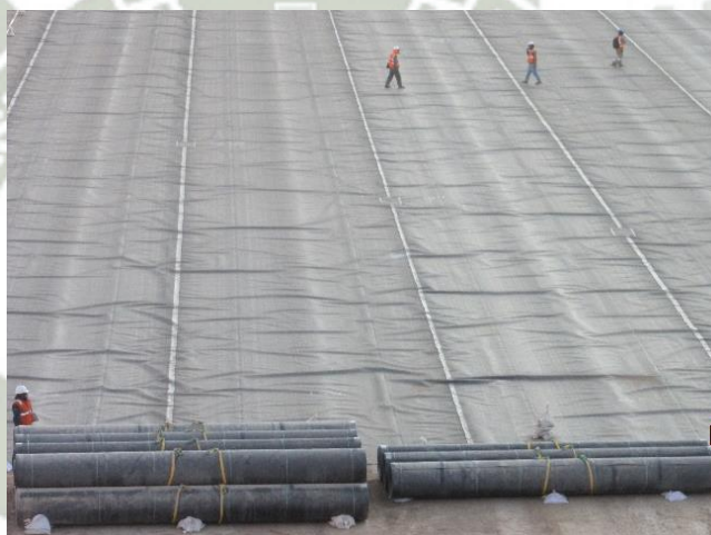
Foto 63: Implementación de zonas de acopio de rollos - Quellaveco
