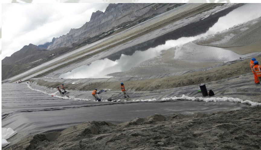
Foto 138: Revestimiento completo - IDT0027 - Antamina
