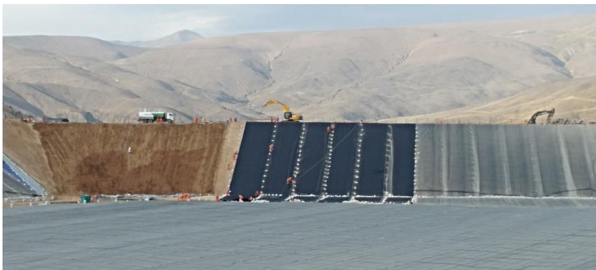
Foto 67: Cierre de impermeabilización de área entregada en el día - Quellaveco
