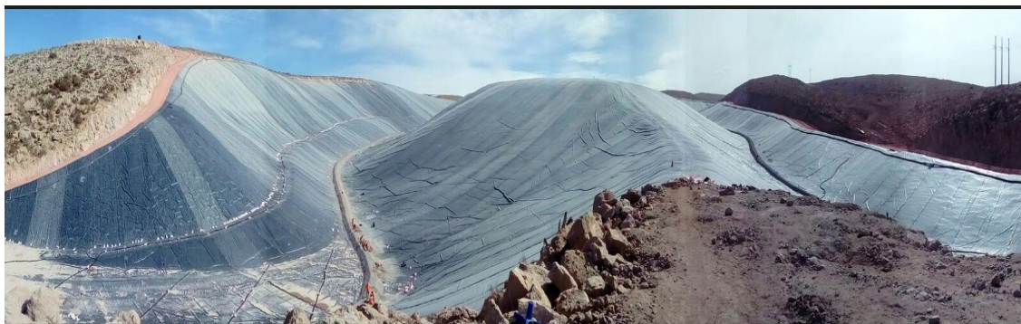
Foto 50: Vista Panorámica Revestimiento con Geomembrana PAD - Cuacone
