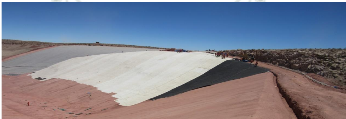
Foto 52: Paneles de GCL PAD - Cuajone
