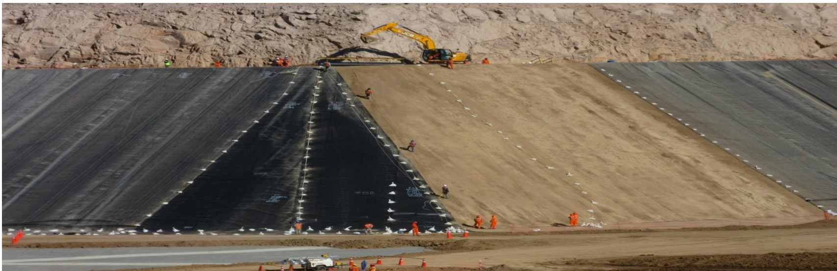
Foto 69: Cierre d impermeabilización de área entregada en el día (Vaso de Poza) - Quellaveco
