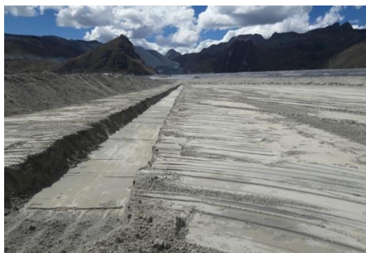
Foto 124: Excavación de Zanja de anclaje en IDT0025 e IDT0027 - Antamina
