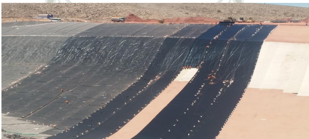
Foto 43: Despliegue de GCL con Cargador Frontal (Sector 1 - PAD) - Cujone
