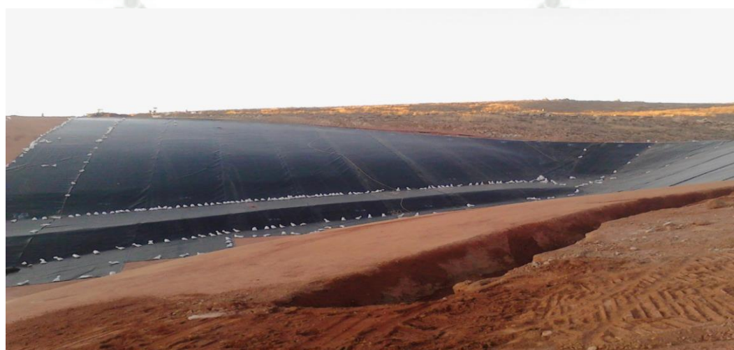
Foto 28: Soldadura de Paneles (Sector 2 - PAD) - Cuajone
