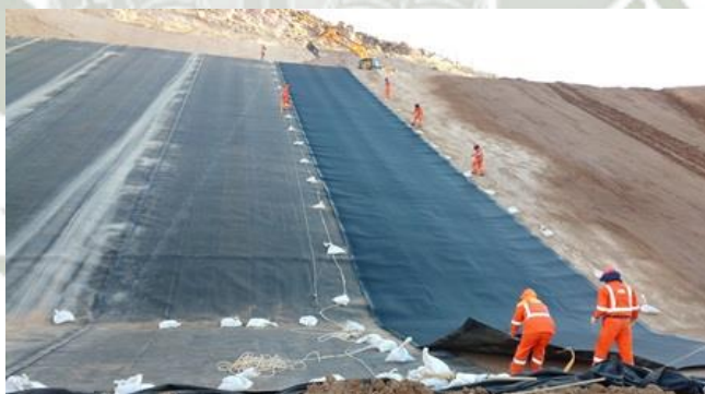
Foto 89: Unión de Paneles antiguos con nuevos - Quellaveco
