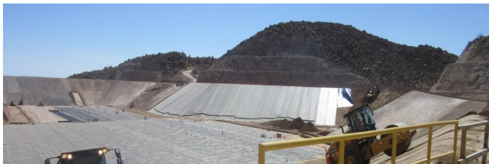
Foto 83: Talud de Poza C4 impermeabilizado - Quellaveco
