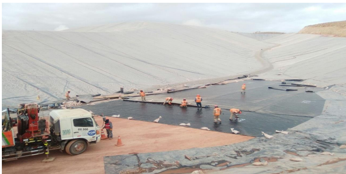
Foto 31: Despliegue con Camión Grúa (Sector 3 - PAD) - Cuajone
