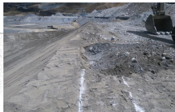
Foto 94: Evidencia de la variación del tipo de suelo a excavar en Espigón - Antamina
