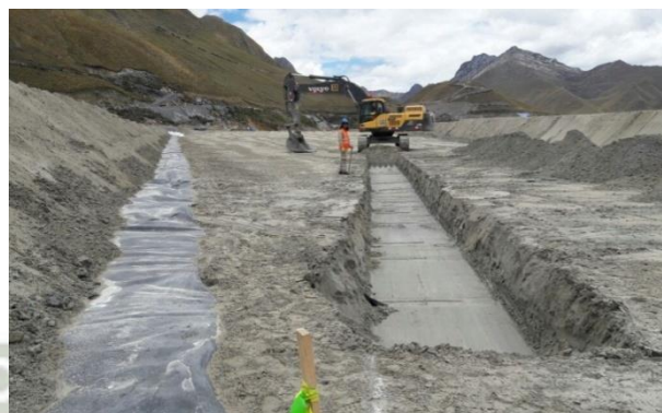
Foto 124: Excavación de Zanja de anclaje en IDT0025 e IDT0027 - Antamina
