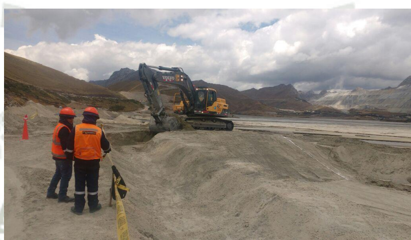
Foto 114: excavación en Espigón Sector C - Antamina
