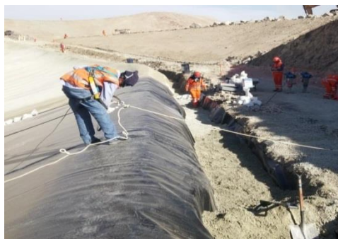
Foto 20: Anclaje de Personal - Cuajone
