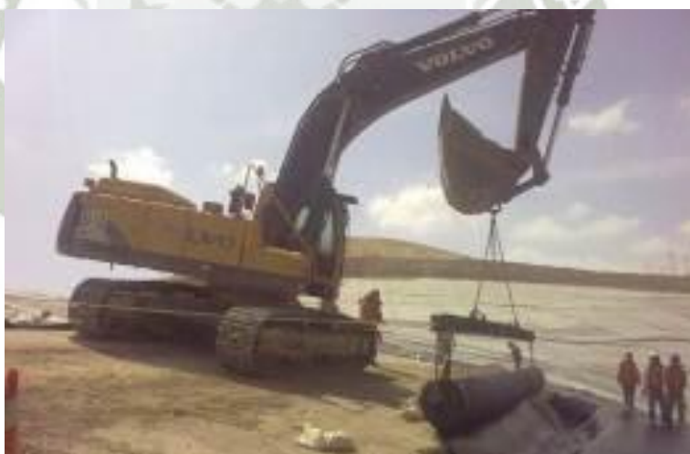
Foto 13: Despliegue de panel con excavadora
