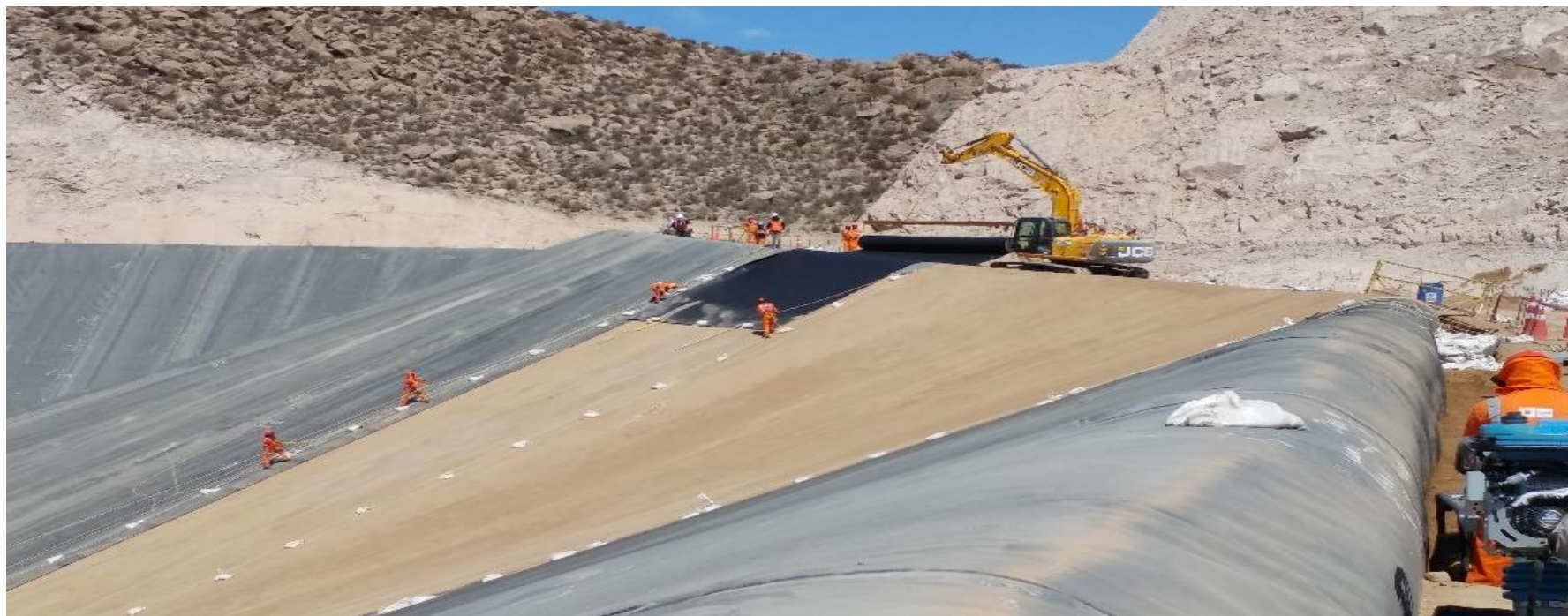
Foto 70: Izaje de rollo con excavadora para ser desenrollado - Quellaveco
