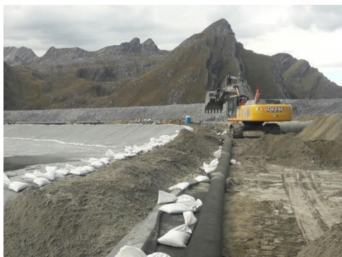
Foto 130: Relleno de Zanja de Anclaje en Playa y Espigón - Antamina
