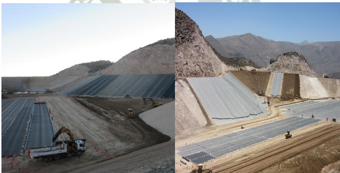
Foto 59: Evidencia extensas distancias y alto tráfico para el Camión Grúa - Quellaveco
