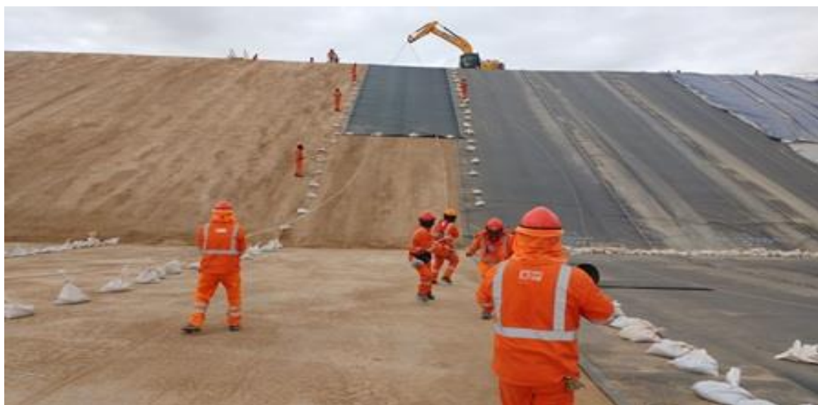
Foto 64: Se tira del paño por el talud con sogas - Quellaveco
