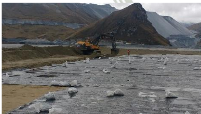
Foto 135: Relleno de Zanja de Anclaje - IDT0025 - Antamina
