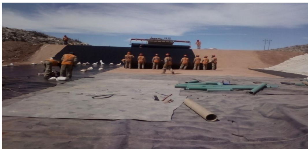
Foto 48: Despliegue de Geomembrana con cargador frontal (Poza de Mayores Eventos) - Cuacone
