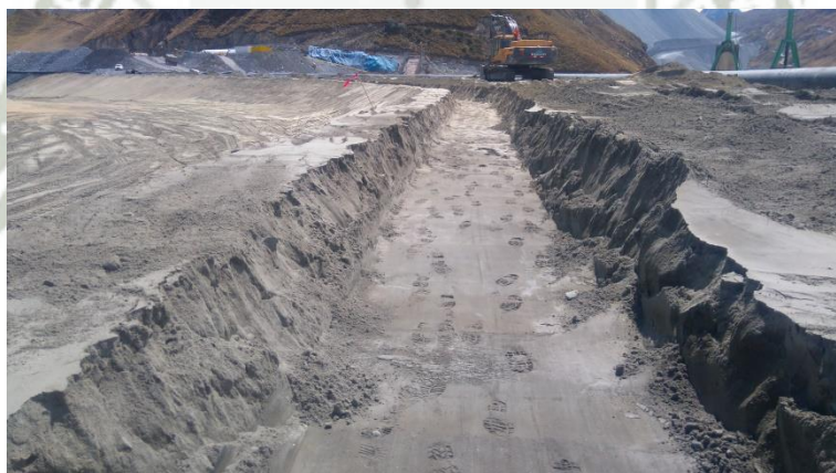
Foto 102: Excavación de Zanja de Anclaje Espigón Sector A - Antamina
