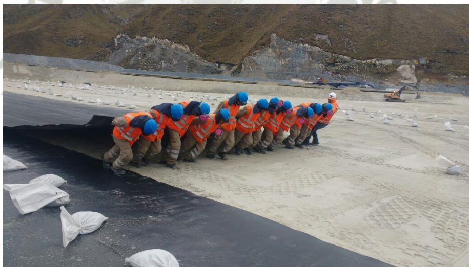
Foto 109: Personal esforzándose en tirar del panel – Antamina – crédito: Jorge Zegarra
