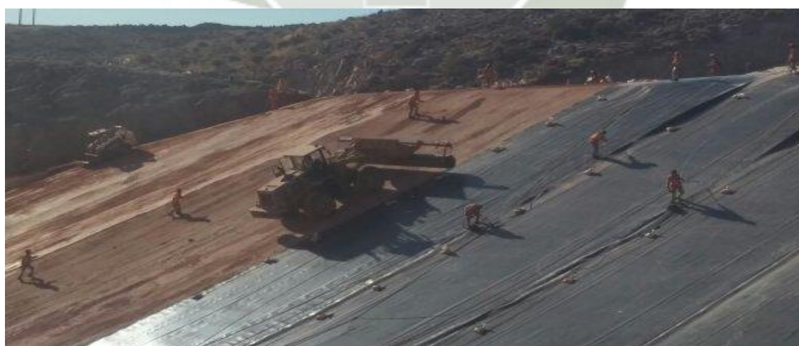
Foto 45: Sellado de uniones de paneles de GCL con Bentonita - Cuajone
