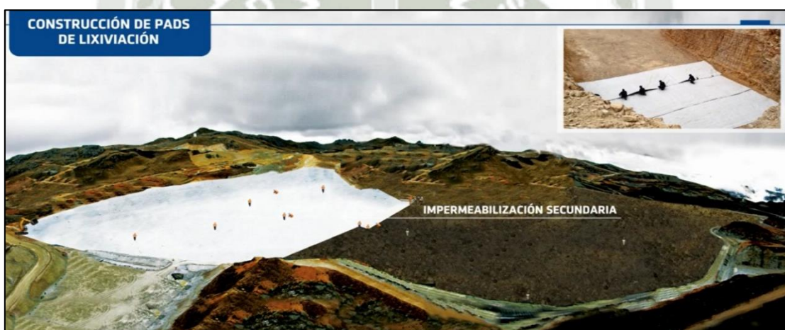
Gráfico 4: Construcción de PAD - Relleno Soil liner o GCL
