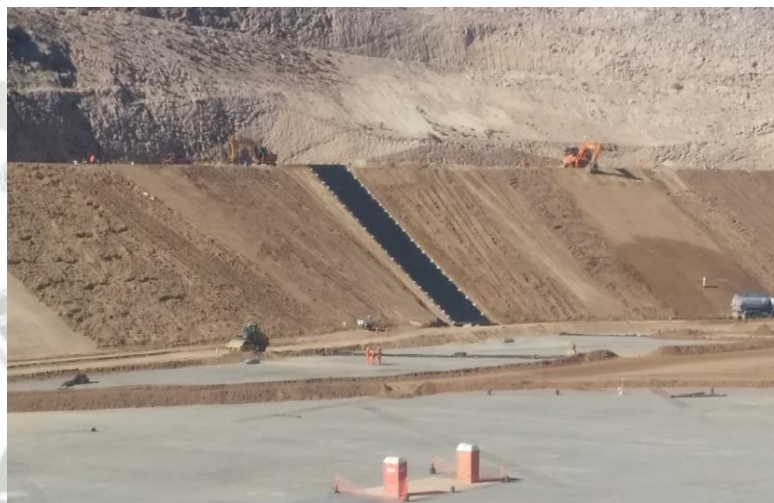
Foto 58: Despliegue de primeros paños en Talud - Quellaveco
