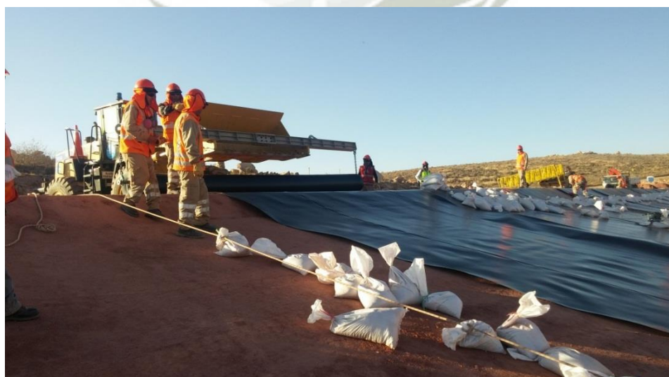
Foto 38: Despliegue con Cargador frontal (Sector 2B - PAD) - Cuajone
