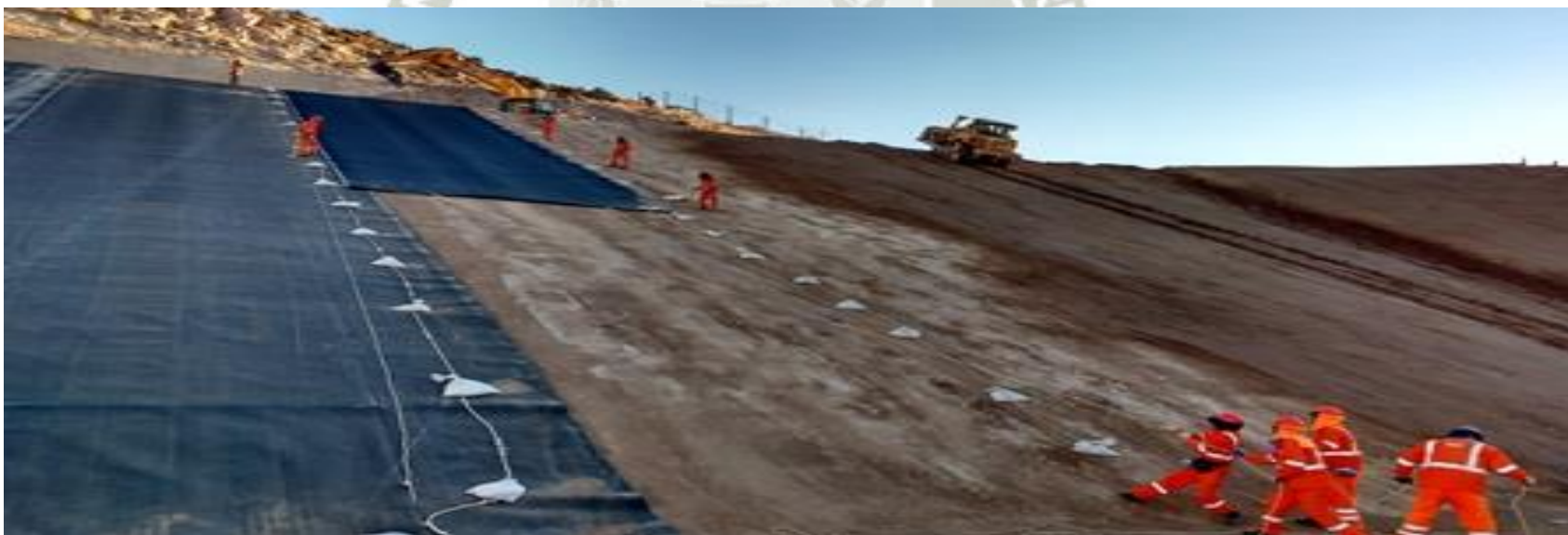
Foto 68: Fuerza laboral para tirar del panel en el talud - Quellaveco
