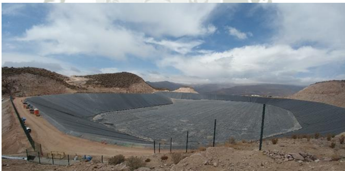
Foto 85: Vista panorámica de impermeabilización completa Poza C4 - Quellaveco
