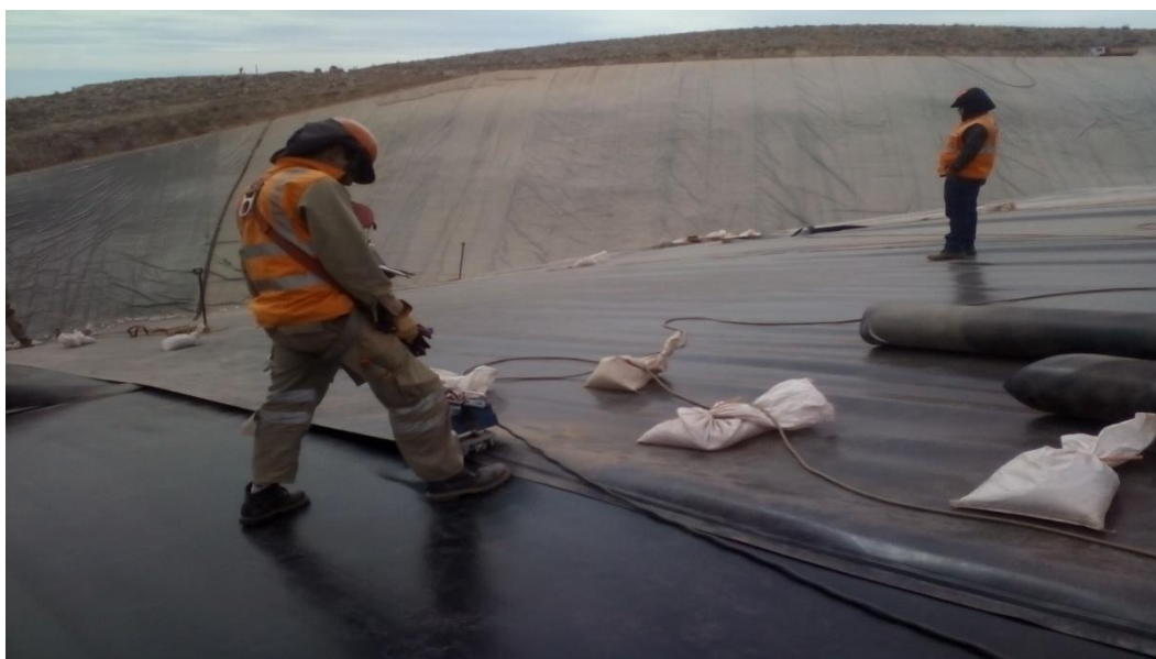
Foto 55: Cierre de paneles con Soldadura por Fusión- Cuajone
