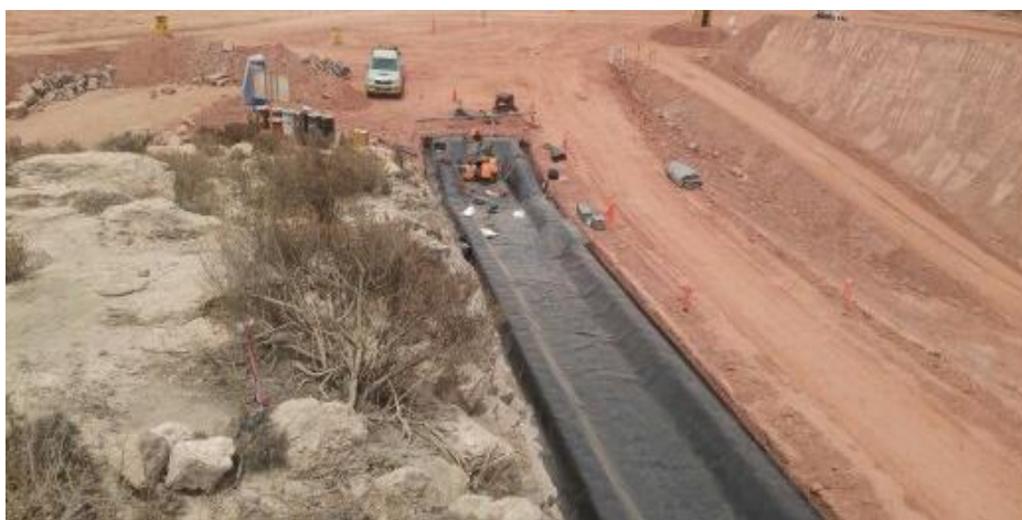
Foto 55: Revestimiento en Canal PLS - Cuajone
