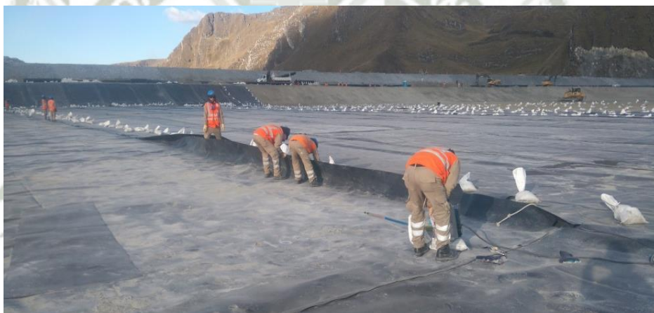
Foto 110: Limpieza de uniones para Soldadura por Fusión - Antamina
