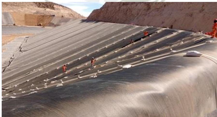
Foto 84: Cierre de Talud Vaso de Poza - Quellaveco
