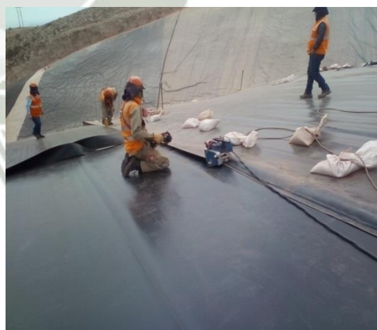
Foto 23: Soldadura por Extrusión y Fusión - Cuajone
