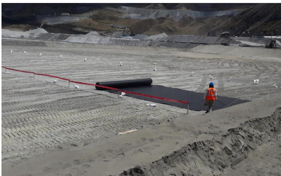
Foto 119: El personal se aparta cuando desciende el rollo por el talud - Antamina
