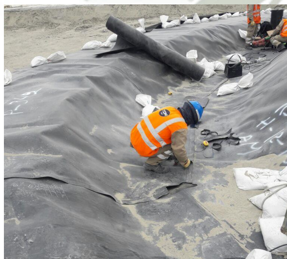
Foto 113: Habilitación de parque para soldadura - Antamina
