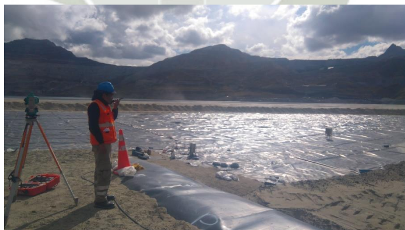
Foto 136: Revestimiento completo - IDT0025- Antamina
