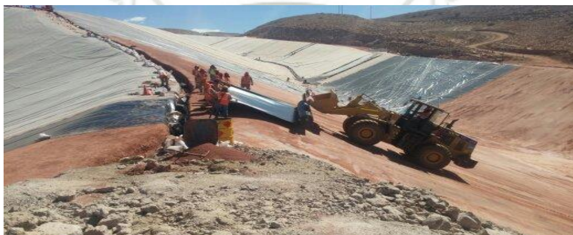
Foto 48: Traslado por talud de Cargador Frontal (Sector 1 - PAD) - Cuajone
