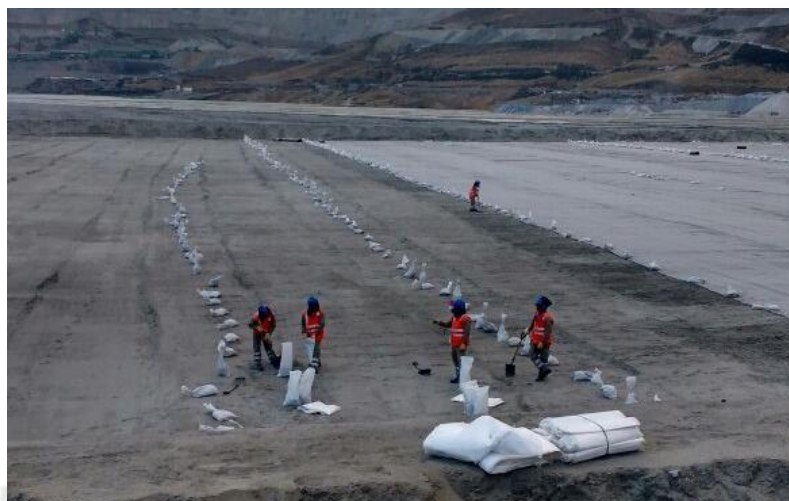
Foto 93: Habilitación de sacos de lastre en el largo de la playa de relaves
