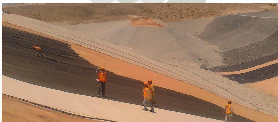
Foto 51: Paneles de Geocompuesto PAD - Cuacone
