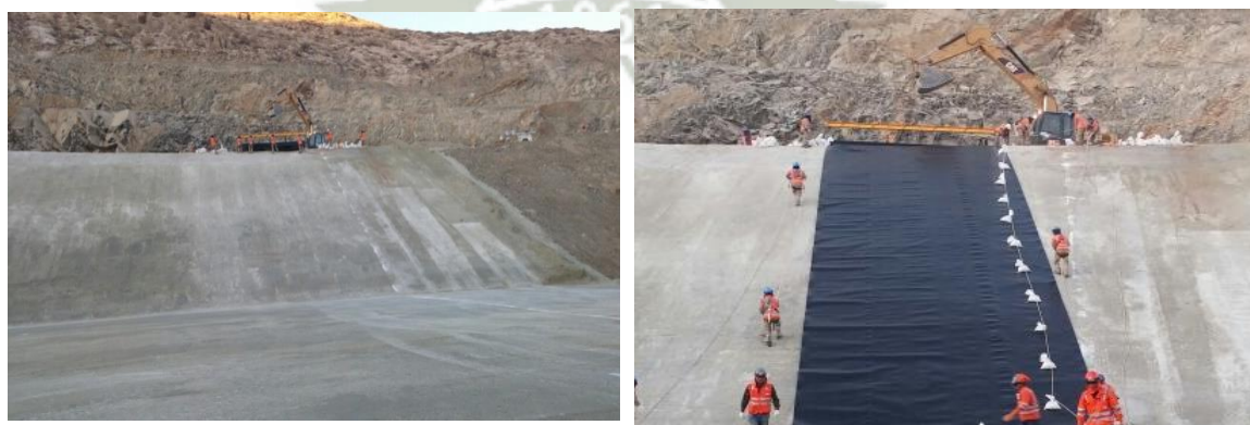
Foto 16: Despliegue con Excavadora en PAD - Cuajone
