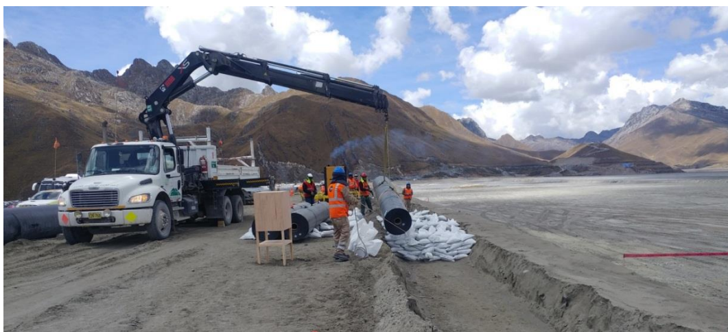
Foto 117: Izaje de rollo sobre sacos en Zanja de anclaje - Antamina
