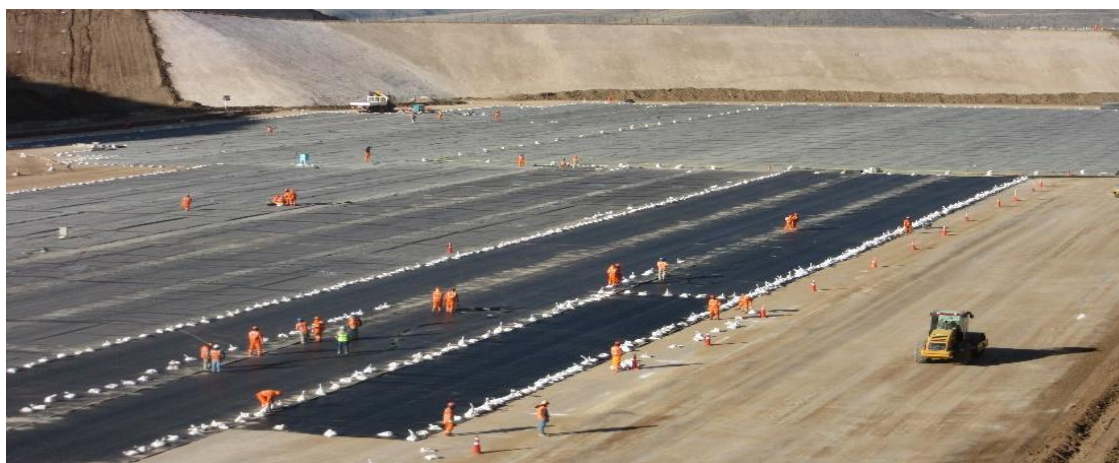
Foto 74: Desenrollado manual de rollo en Base de Poza - Quellaveco
