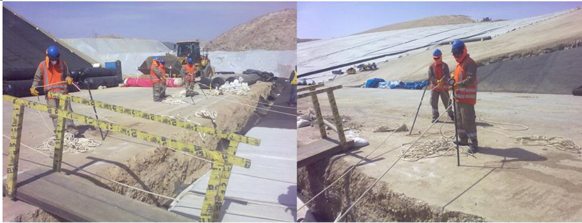
Foto 12: Anclaje de personal para despliegue
