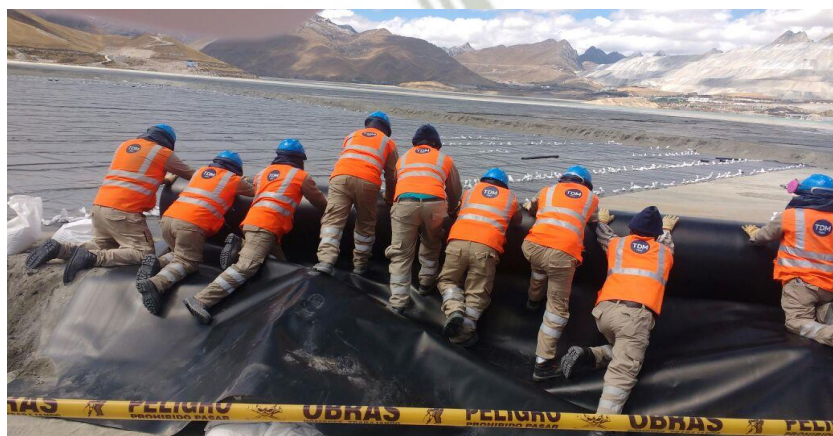
Foto 118: Personal empuja rollo desde cresta en Espigón - Antamina
