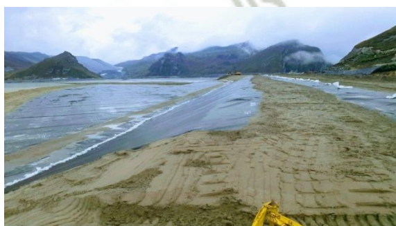
Foto 137: Zanja de Anclaje en Espigón - IDT0027- Antamina
