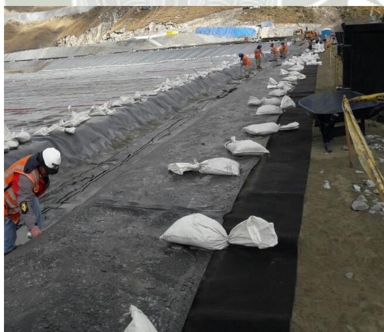
Foto 133: Geotextil como proteccion en zanja de anclaje - Antamina
