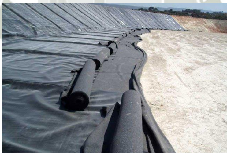
Foto 8: Despliegue de geotextil
