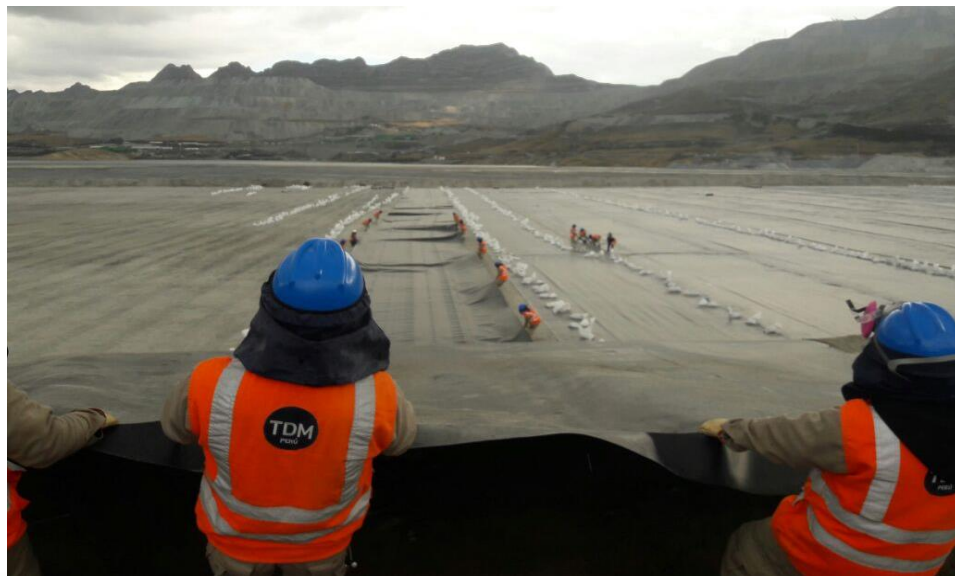
Foto 140: Alineación de panel en playa de Relaves - Antamina
