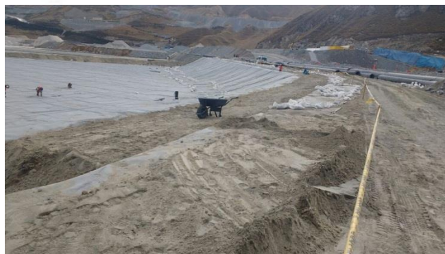
Foto 130: Relleno de Zanja de Anclaje en Playa y Espigón - Antamina
