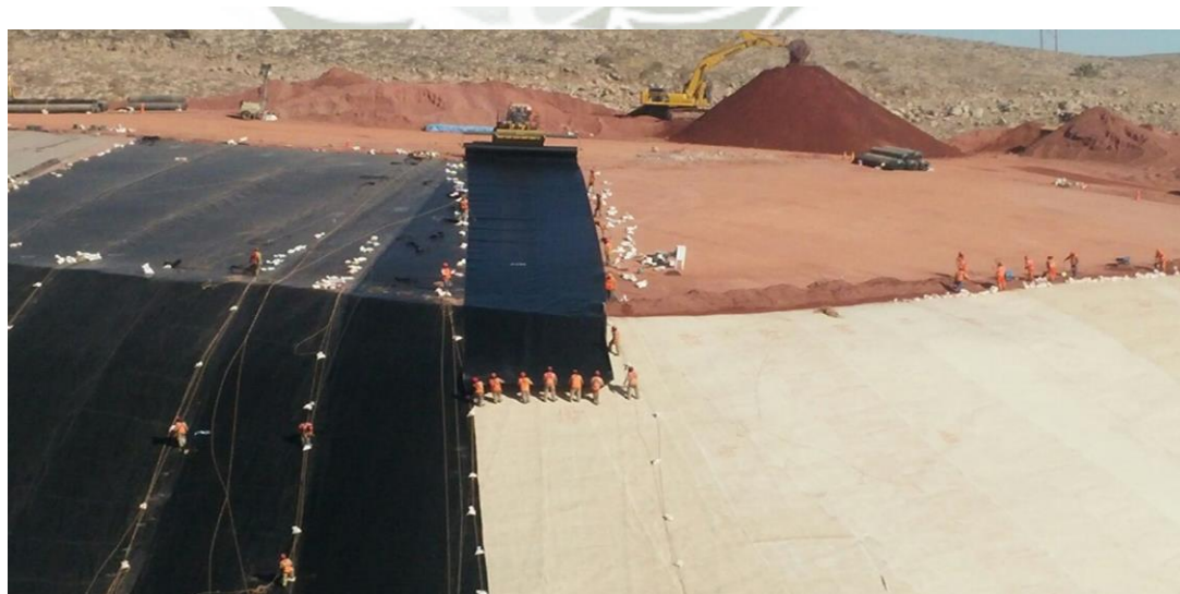
Foto 39: Detalle del desenrollado de rollo con cargador frontal (Sector 3 - PAD) - Cuajone
