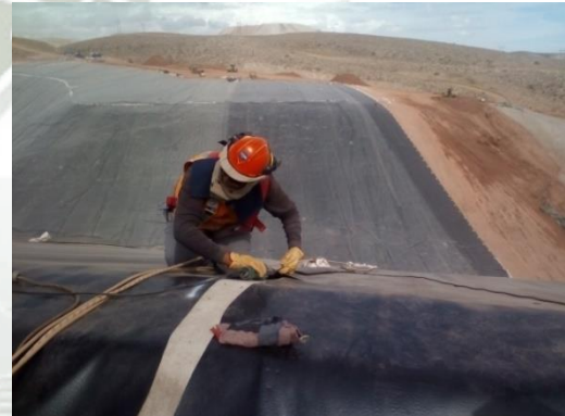
Foto 19: Preweld y soldadura de geomembrana - Cuajone
