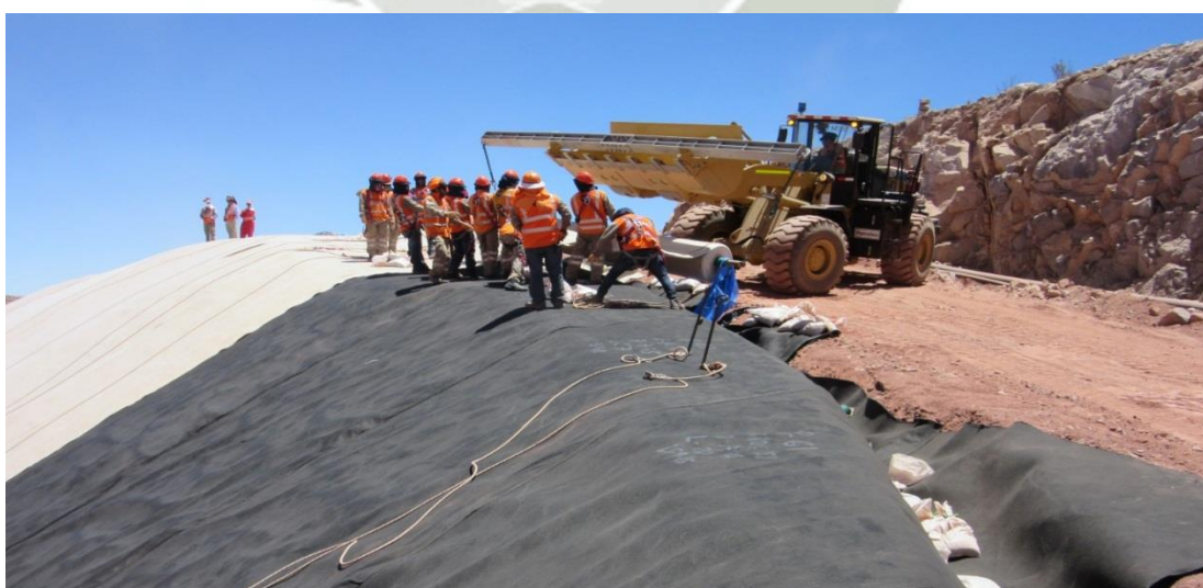
Foto 42: Geocompuesto y GCL (Sector 3 - PAD) - Cujone
