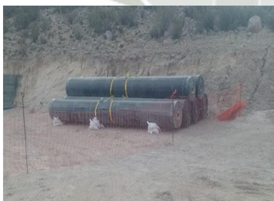
Gráfica 37: Ejemplo de rollos apilados
