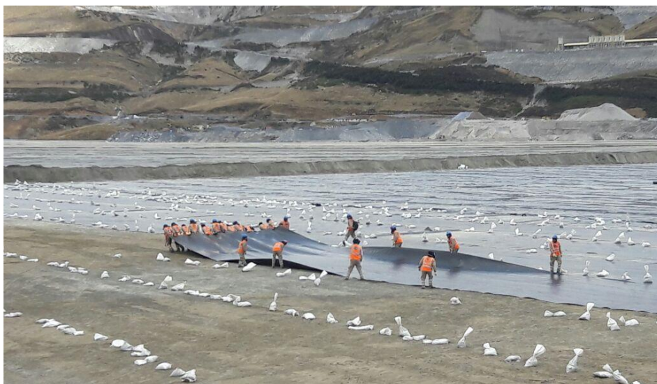
Foto 106: Personal tirando del panel a lo largo de la Playa de Relaves - Antamina
