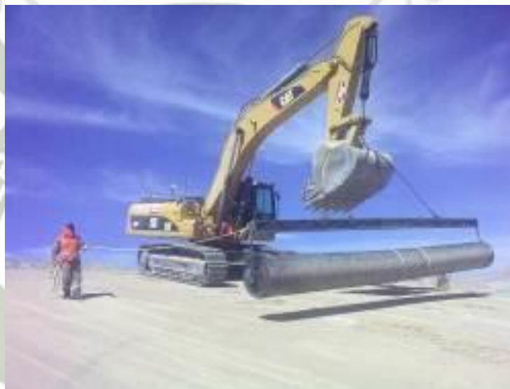
Foto 17: Traslado de rollo con excavadora - Cujone
