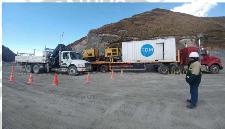
Foto 128: Movilización y Desmovilización de Instalaciones - Antamina
