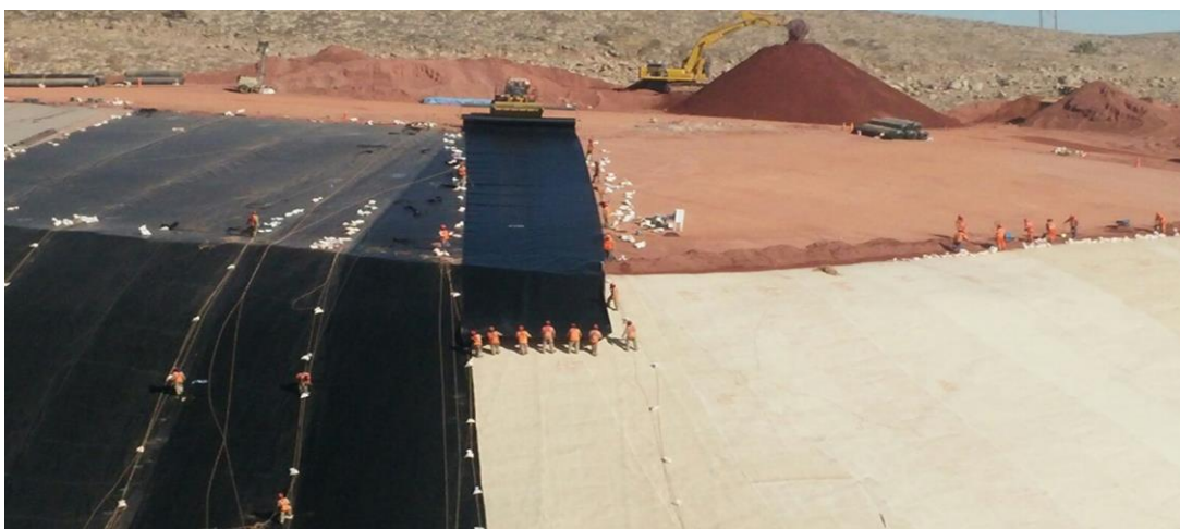
Foto 44: Desenrollado de panel con Cargador Frontal (Sector 2 - PAD) - Cujone
