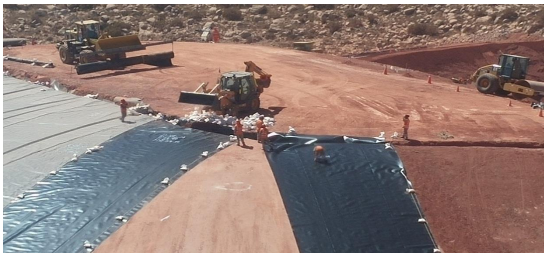
Foto 41: Traslado de rollo con Cargador frontal (Sector 2B - PAD) - Cuajone
