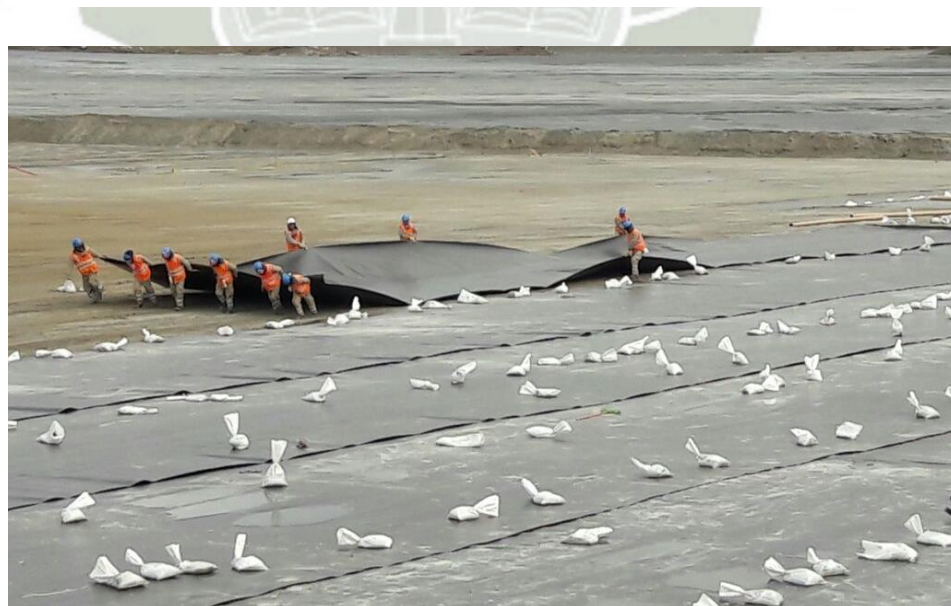
Foto 141: Desplazando panel a lo largo de Playa de Relaves - Antamina
