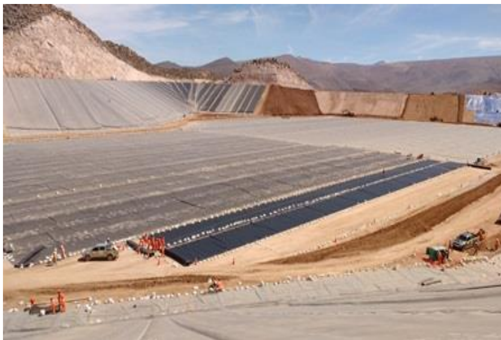
Foto 80: Completando impermeabilización de área que se utilizaron como acceso - Quellaveco
