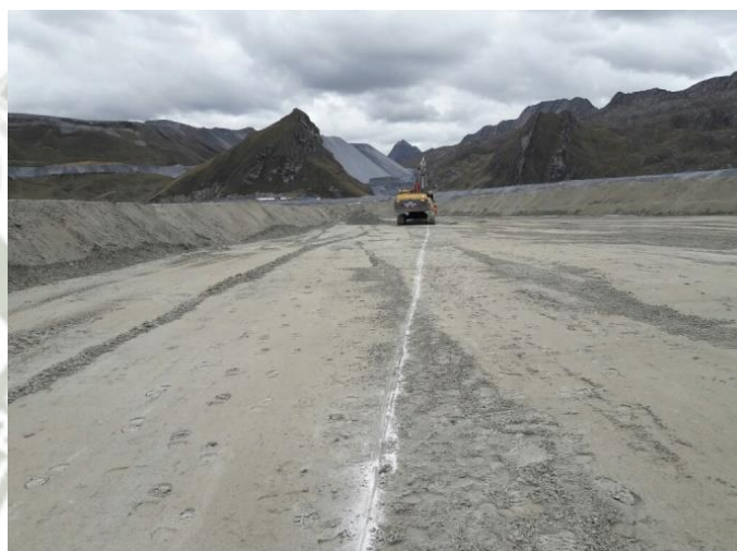
Foto 134: Excavación de Zanja de Anclaje - IDT0025 - Antamina
