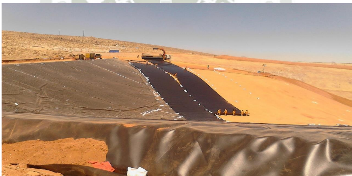
Foto 30: Despliegue con Camión Grúa (Sector 2B - PAD) - Cuajone
