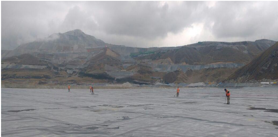
Foto 143: Limpieza de Áreas afectados por la lluvia para su entrega - Antamina
