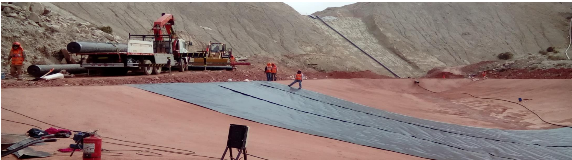
Foto 33: Despliegue Geomembrana con Camión Grúa (Poza PLS) - Cuajone
