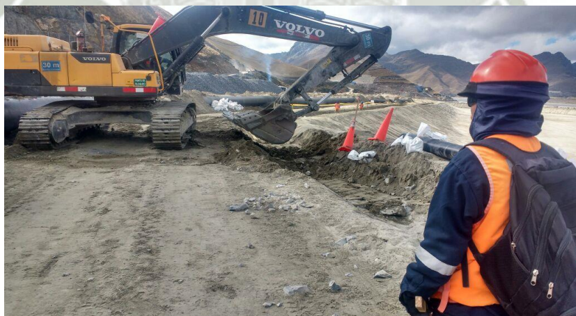
Foto 107: Excavación de zanja de anclaje - Antamina
