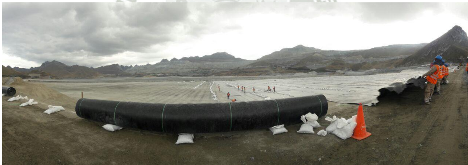
Foto 121: Cuadrando panel para ser asegurados con sacos - Antamina
