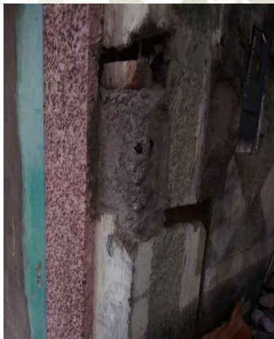
Fotografía 19: Sección de columnas eliminada para colocar medidor.
