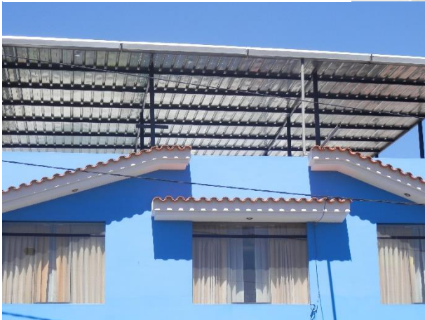
Fotografía 13: Estructuras metálica en la azotea.
