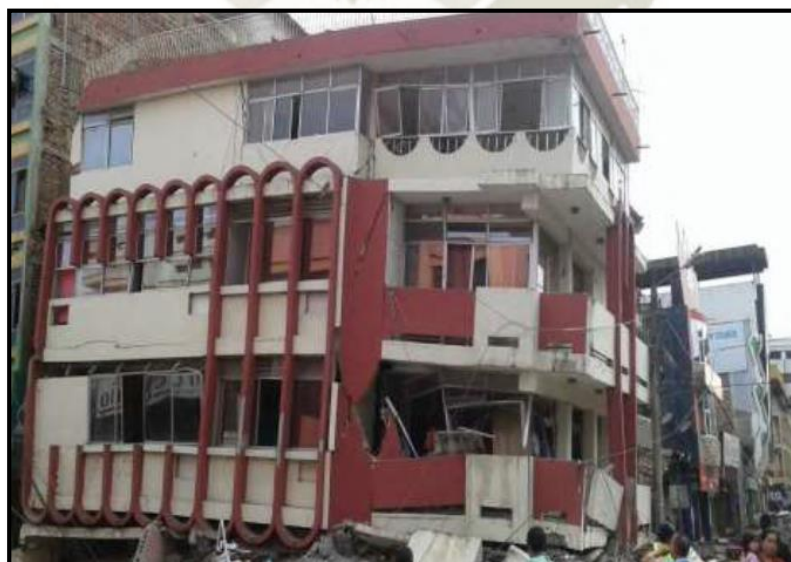
Figura 25: Edificio ubicado en la esquina que colapso en el terremoto de Ecuador, 2016.
