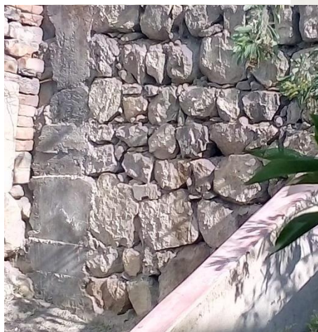
Fotografía 25: Muros de contención de piedras.
