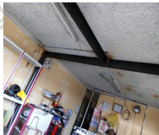
Fotografía 16: Refuerzo de techo del primer piso.
