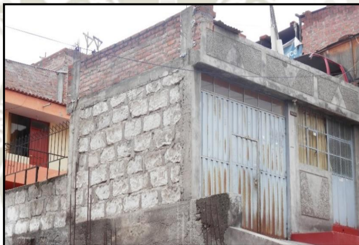
Figura 28: Muros de carga de sillar. Fuente: Fotografía propia.
