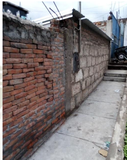
Fotografía 2: Vivienda con muros de bloquetas con techo de calamina.
