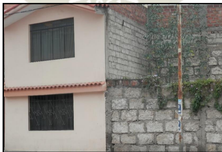
Figura 29: Muros de carga de bloquetas. Fuente: Fotografía propia.
