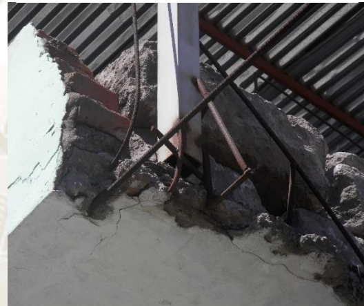
Fotografía 14: Soldadura de anclaje de estructuras metálicas.
