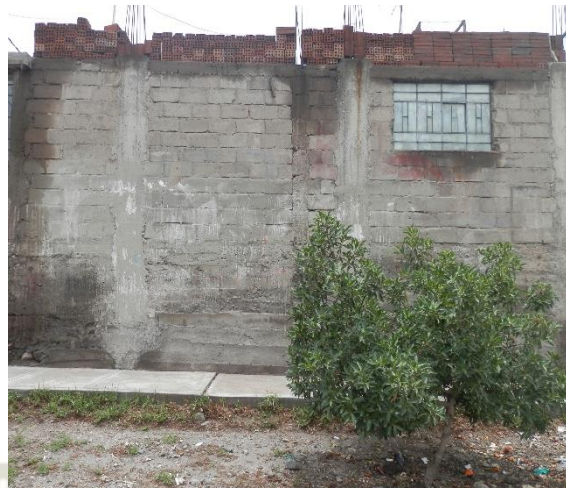
Fotografía 6: Vivienda con muros de bloquetas.
