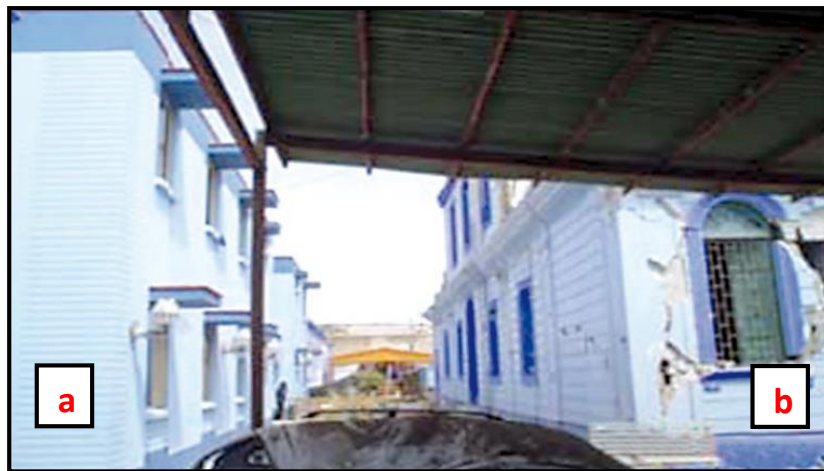
Figura 9: Ejemplo de influencia de una buena cimentación. Pabellón del hospital san juan de dios de Pisco. Terremoto Pisco, 2007. a) pabellón construido con buena cimentación. b) colapso del pabellón por tener una cimentación deficiente.
