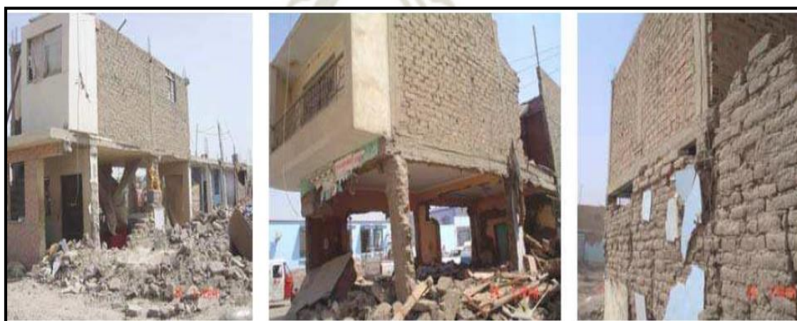
Figura 16: Primer piso de adobe y el segundo de albañilería, Pisco, 2007
