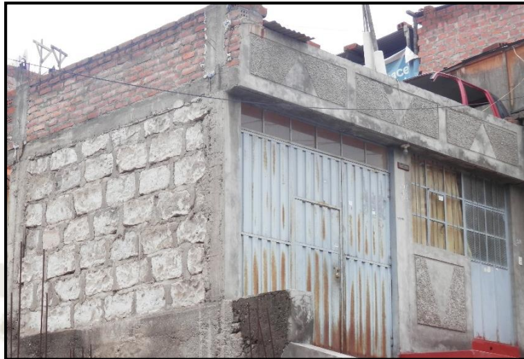
Figura 8: Sistema estructural de sillar.
