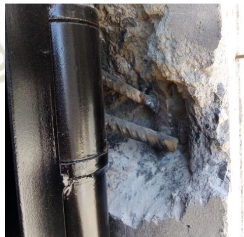
Fotografía 22: Soldadura de puertas a los aceros de las columnas.
