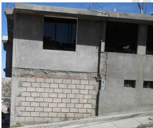
Fotografía 9: Aparente buen estado de mantenimiento de una vivienda con muros de bloquetas
