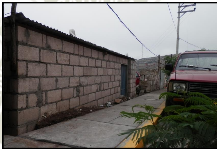
Figura 26: Muros entrelazados de Bloquetas sin confinamiento con techo de calamina. Fuente: Fotografía propia.
