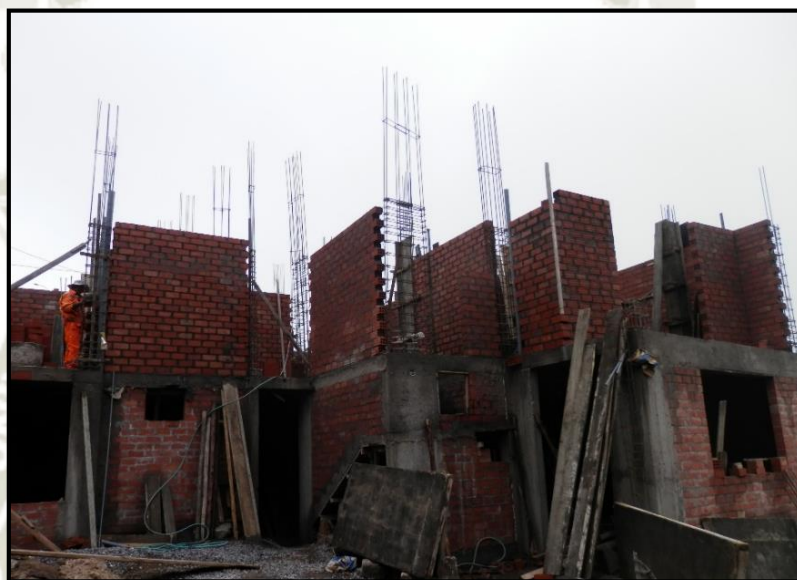
Figura 34: Construcción de muros de carga de albañilería con ladrillos mecanizados.
