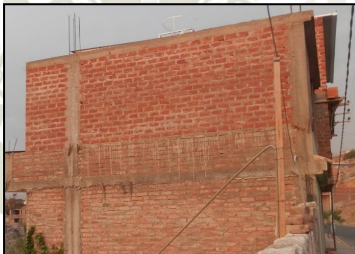
Figura 32: Construcción de muros de carga de albañilería con ladrillos artesanales. Fuente: Fotografía propia.
