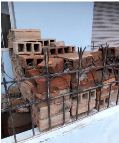
Fotografía 1: Ladrillo hueco para techo artesanales.
