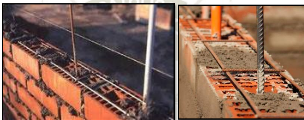
Figura 36: Albañilería totalmente reforzada Fuente: Fotografía de google (Acma, 2019)
