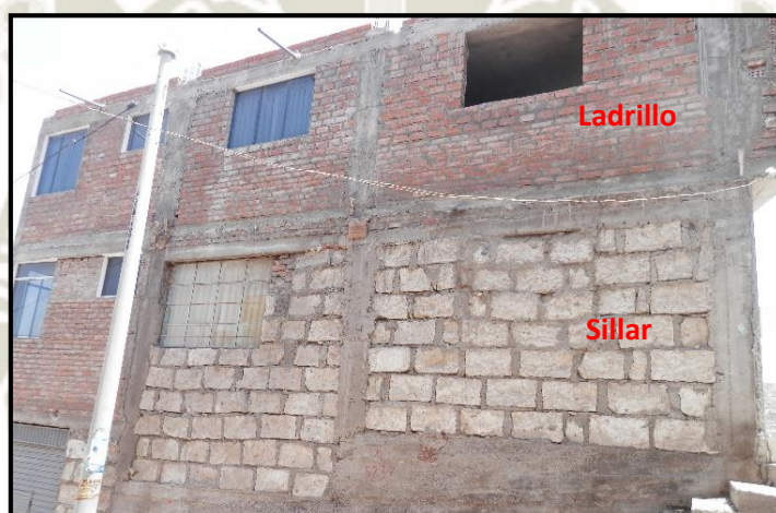
Figura 30: Muros de carga mixto, sillar-ladrillo Fuente: Fotografía propia.
