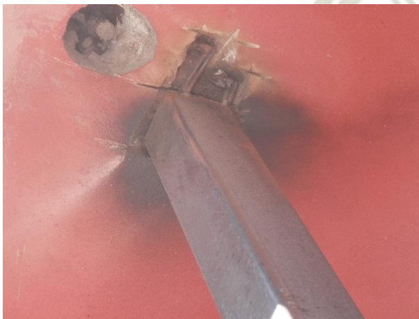
Fotografía 15: Refuerzo de techo de un volado.
