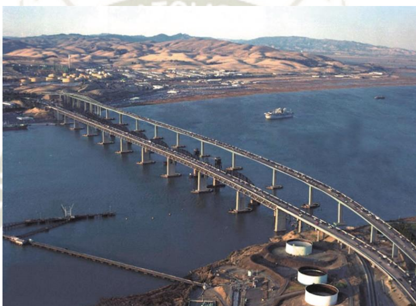
Figura 24 Vista panorámica del puente Benicia – Martínez
