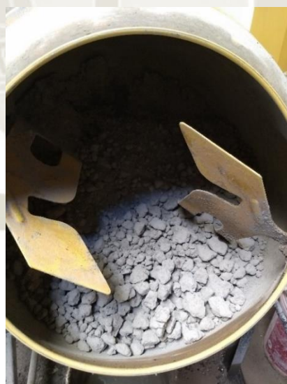
Figura 17 Combinación de los agregados y cemento en la mezcladora
