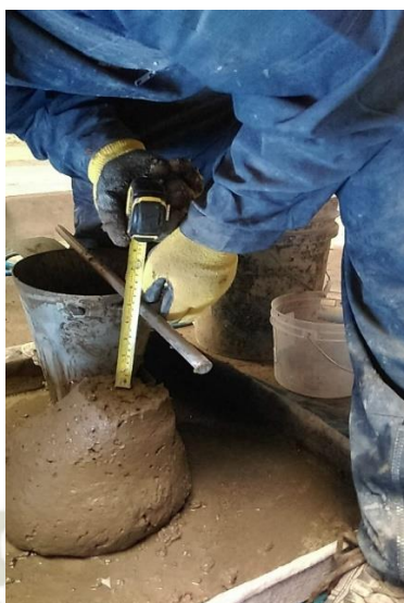
Figura 20 Medición del Slump del concreto
