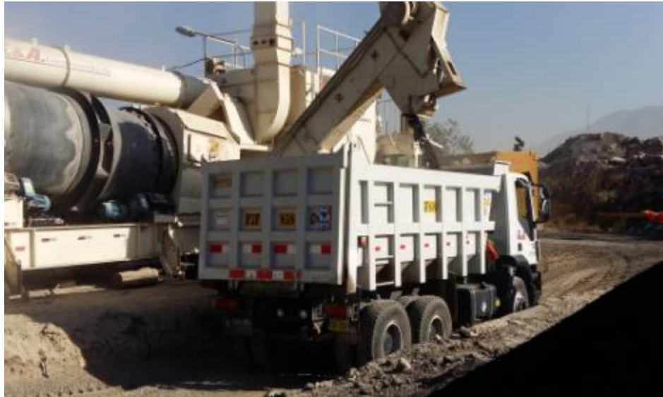
Figura 3: Pavimento Flexible en caliente FUENTE: Elaboración propia, planta de asfalto
