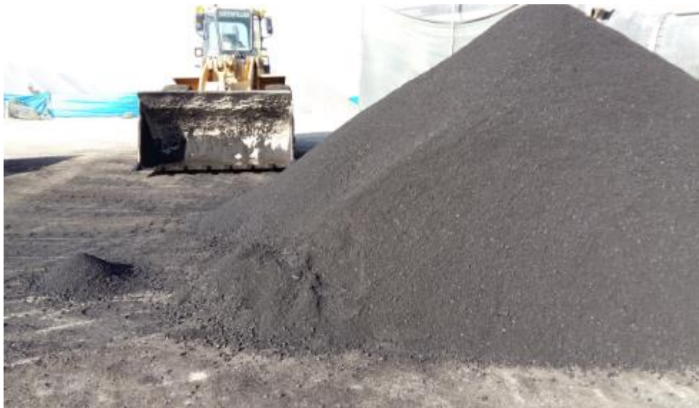
Figura 2: Pavimento Flexible en frío
