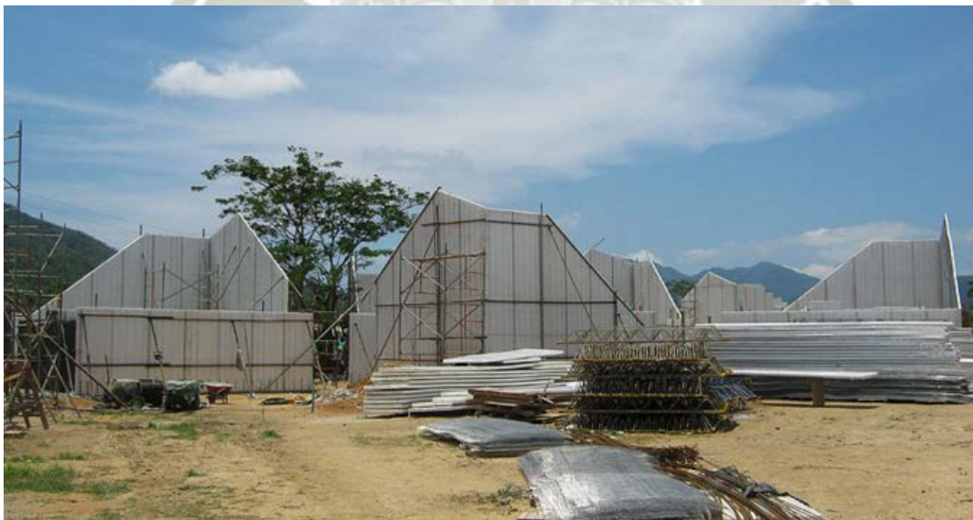
Grafica 20 – Escuela Preescolar TIMAYUI (construcción) Fuente: http://cniingenieros.com/
