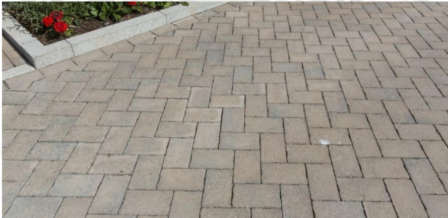
Fig. 1.33: Adoquines con ranura rellenos con material libre. Fuente: http://www.archiexpo.es/prod/hanson/product-59475-301793.html
