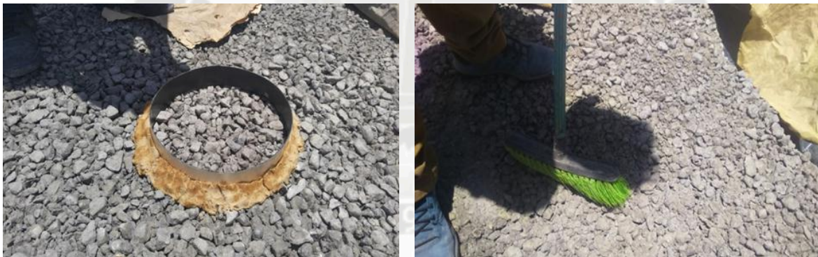
Fig. 6.15: Instalación del anillo de infiltración. Fuente: Propia.
