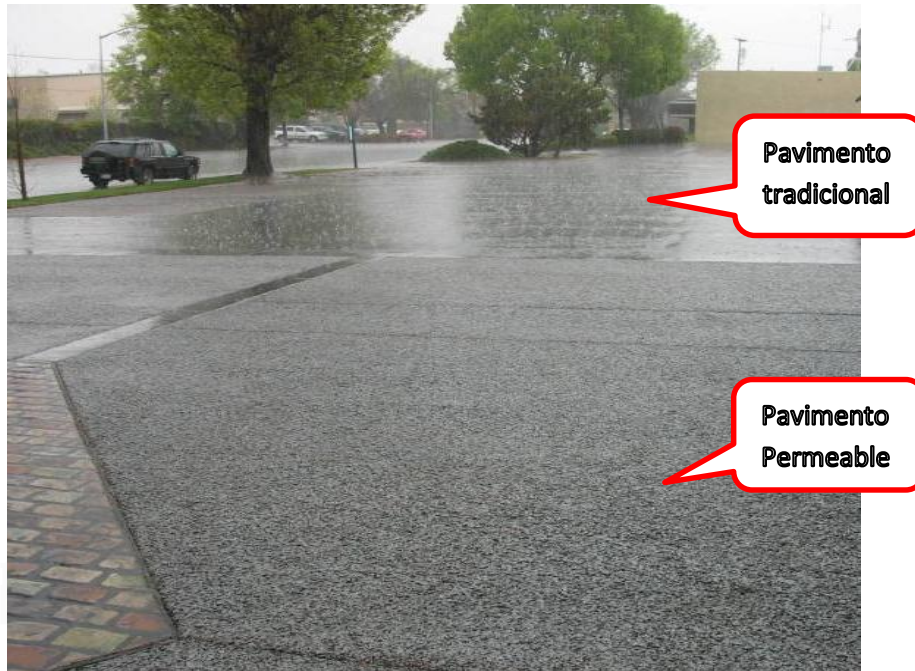
Fig. 1.30: Imagen de un pavimento tradicional y pavimento permeable. Fuente: http://www.imcyc.com/revistacyt/jun11/arttecnologia.htm
