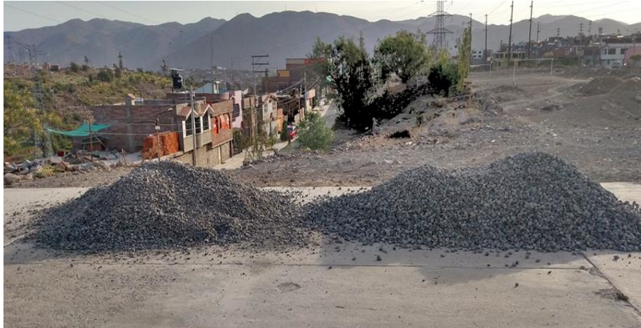
Fig. 6.2: Terreno para la realización de losa de prueba de concreto permeable. Fuente: Propia.
