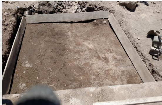
Fig. 6.9: Encofrado de terreno. Fuente: Propia.
