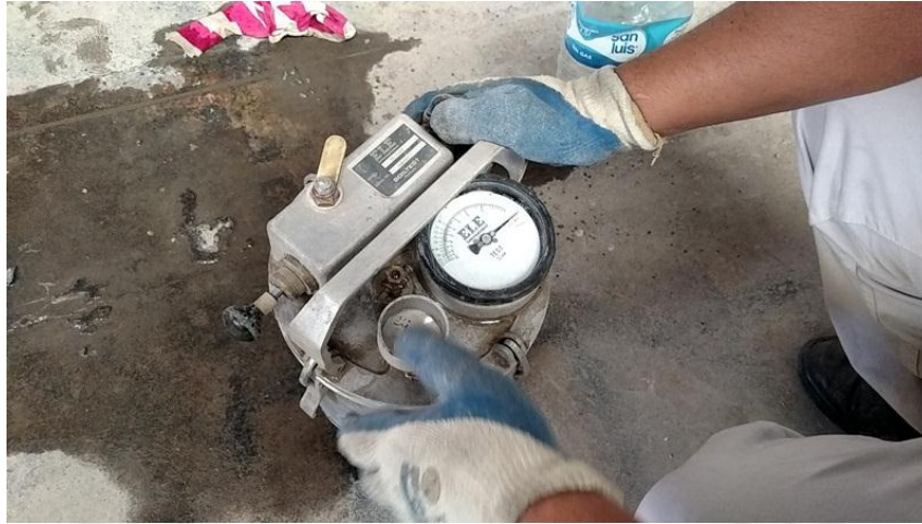
Fig. 4.12: Bombear para que ingrese aire dentro de la cámara. Fuente: Propia.
