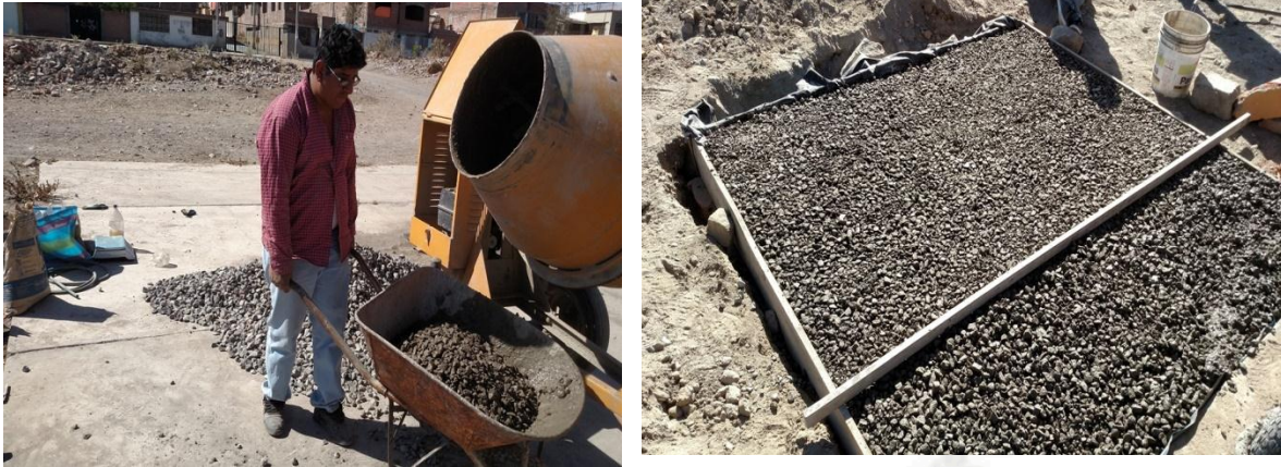
Fig. 6.11: Vaciado de la losa. Fuente: Propia.
