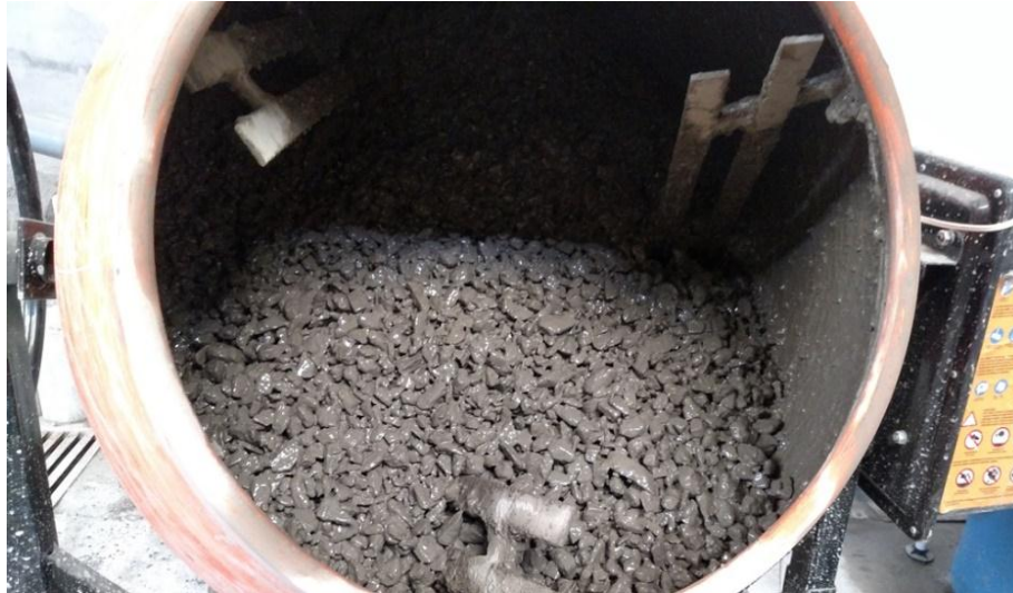
Fig. 1.6: Mezclado de concreto. Fuente: Propia.
