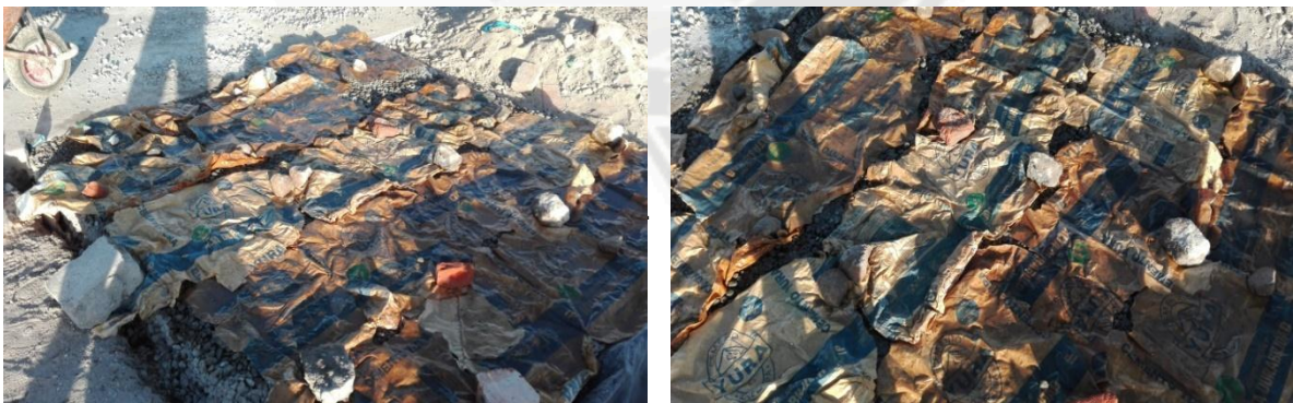
Fig. 6.12: Curado de la losa. Fuente: Propia.
