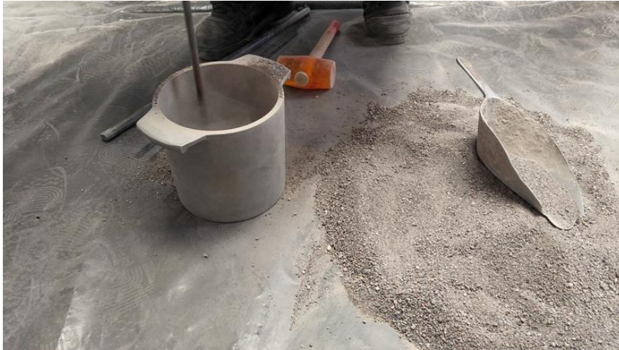
Fig. 2.37: Se apisona la capa de agregado con la varilla 5/8", compactando. Fuente: Propia.
