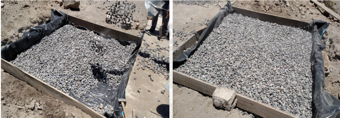
Fig. 6.10: Relleno con material granular. Fuente: Propia.
