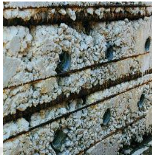
Fig. 1.9 Una buena consolidación es necesaria para lograrse un concreto denso y durable (izquierda). Una consolidación pobre (derecha) puede resultar en corrosión temprana de la armadura (refuerzo) y baja resistencia a compresión. Fuente: PORTLAND CEMENT ASSOCIATION (PCA) – 2004.
