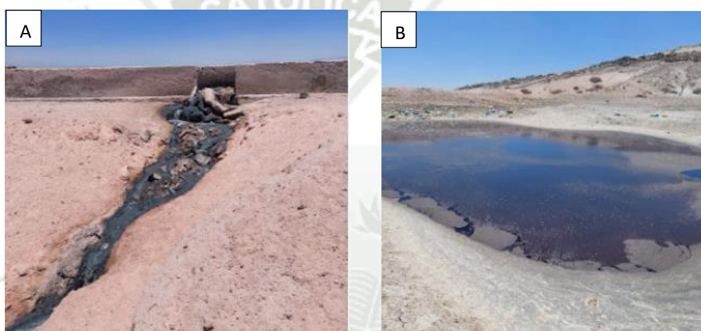
Figura 13. Primer punto de monitoreo. (A) Ruptura del canal principal de efluentes industriales, (B) Inicio de la contaminación.
