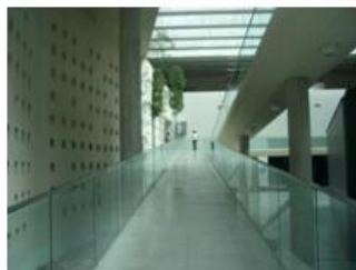
Foto N° 1. 22: Hall principal con rampa de acceso del C.C.P.M. Fuente: IDEM
