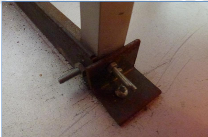
Fig. 4.7 Empotramiento en la plataforma con perfiles de acero
