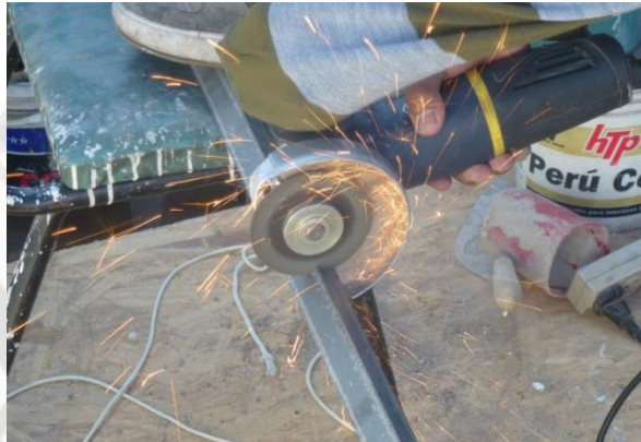
Fig. 3.15 Corte de los perfiles con la cortadora
