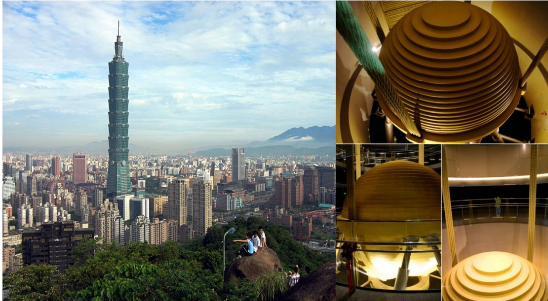
Fig.2.10 Taipei 101 con amortiguador bañado en oro
