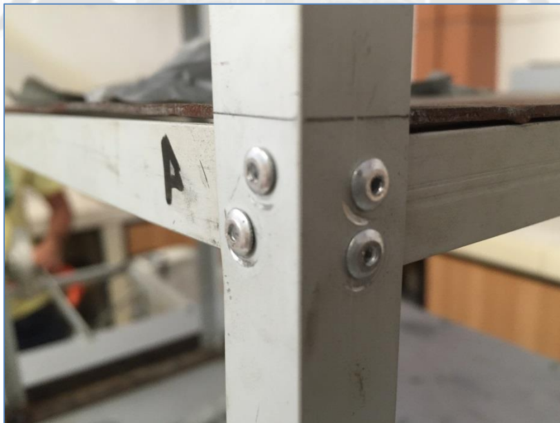
Fig. 4.5 Uniones Remachadas
