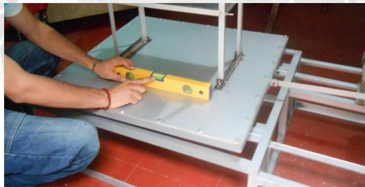
Fig. 3.31 Nivelación de la plataforma para alcanzar la horizontalidad adecuada
