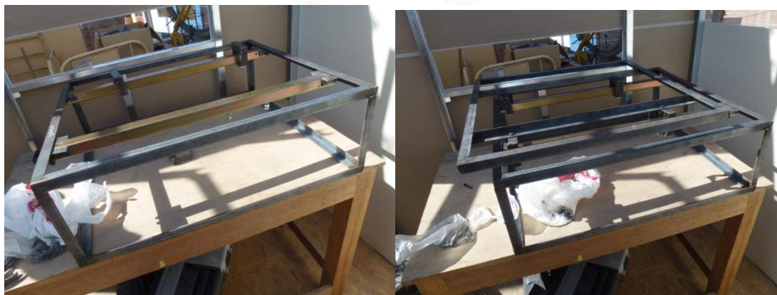
Fig. 3.17 Estructura soldada y armada
