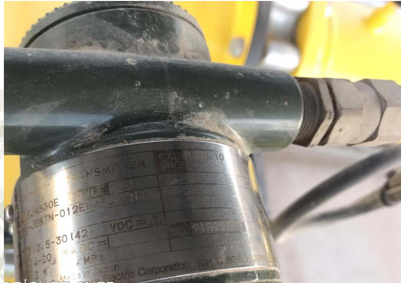
Figura 17 Transmisor de presión protocolo HART (FUENTE: PROPIA)
