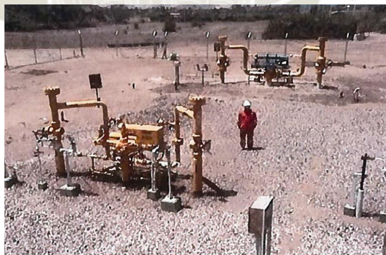
Figura 24 Imágenes de la cámara de seguridad de la zona 1 FUENTE: TECHINT (2016).
